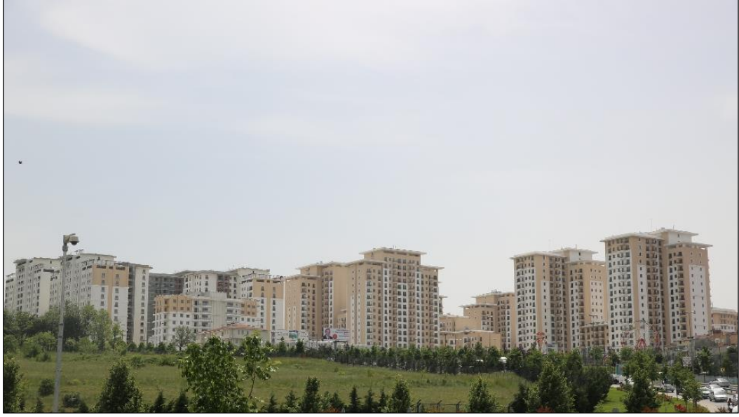
Şekil 5.15: Havaalanı Mahallesi Kentsel Dönüşüm Projesi.
