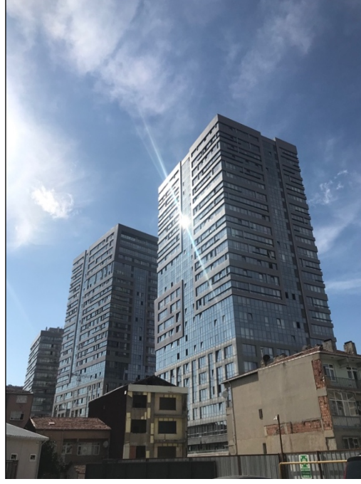
Şekil 5.11: Fikirtepe Riskli Alanı Kentsel Dönüşüm Projesi.
