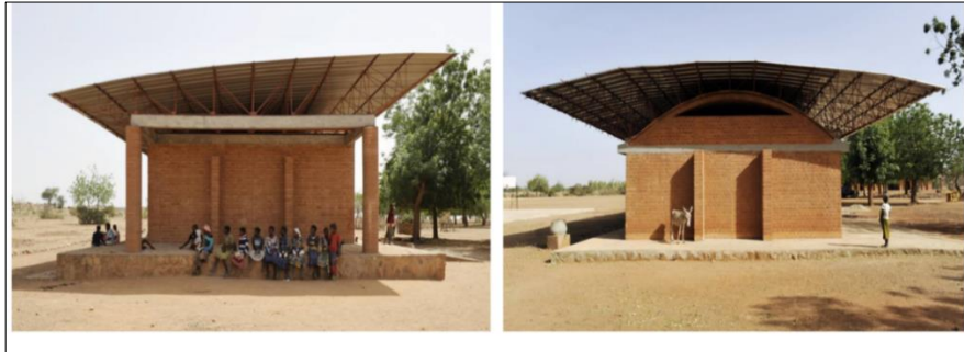
Şekil 4.39: Gando İlkokulu ve Ek binasından çatı görüntüleri.
