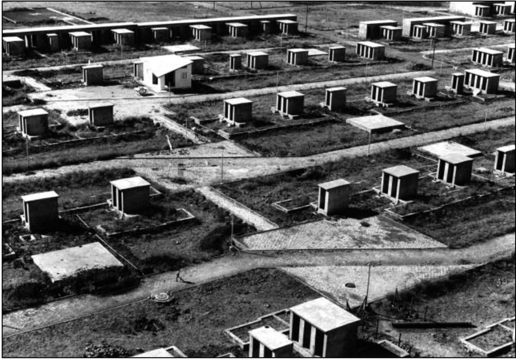
Şekil 4.28: 1989 yılı Aga Khan Mimarlık Ödülü alan Aranya Düşük Maliyetli Konut yerleşimi, 30 m 2 lik altyapı ve kaide planı.
