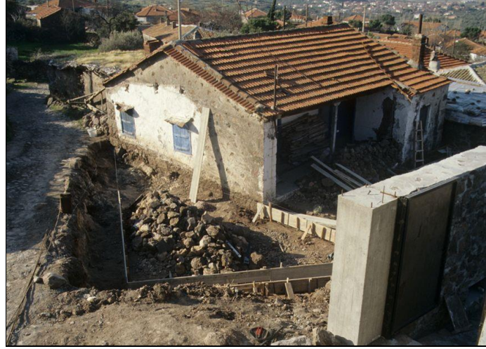
Şekil 5.21: Yahşibey 3. Ev'in İnşaat Süreci.
