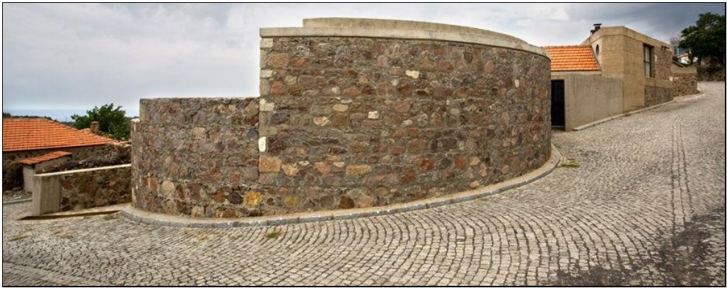
Şekil 5.30: Yahşibey 5. Ev'in Sokaktan Görünümü.
