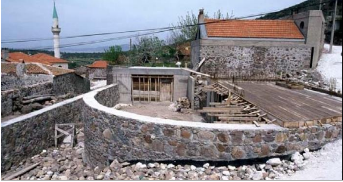
Şekil 5.34: Yahşibey 5. Ev'in İnşaat Süreci.
