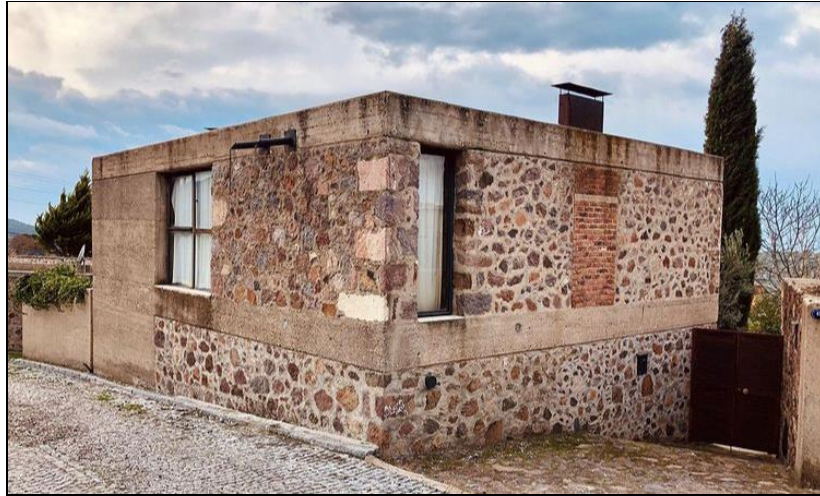
Şekil 5.16: Yahşibey 3. Ev'in Sokaktan Görünümü.
