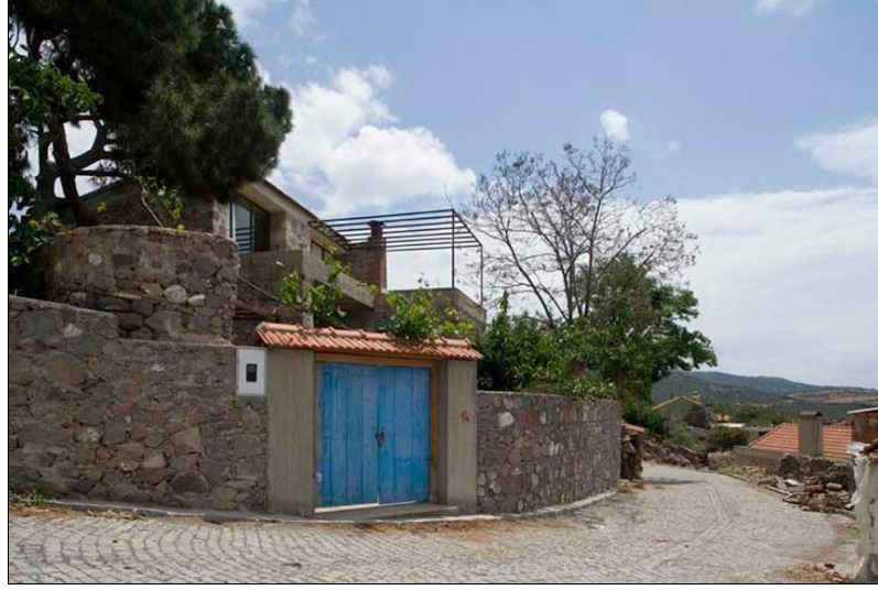
Şekil 5.6: Yahşibey 1. Ev'in Sokaktan Görünümü.
