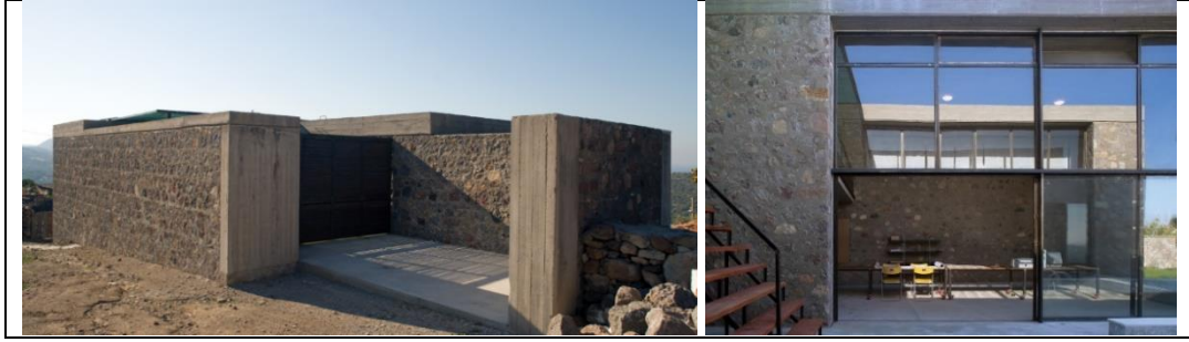
Şekil 5.42: a) Yahşibey Yaz Okulu Giriş Cephesi, b) Yahşibey Avluya Bakan Cephe.
