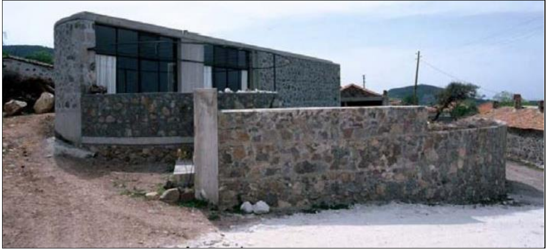
Şekil 5.31: Yahşibey 5. Ev'in Güney'den Görünümü.
