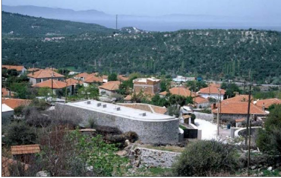
Şekil 5.27: Yahşibey 4. Ev'in Arka Cephesinden Görünümü.
