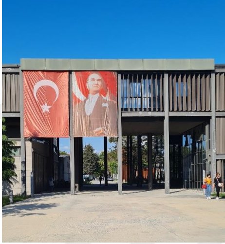
Yeni yapı-eski yapı.
