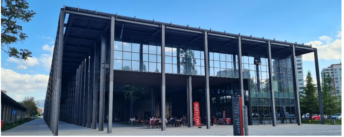
Şekil 4.39: Çelik bina dış görünüm.
