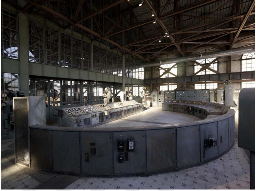
Şekil 4.21: Enerji Müzesi – kontrol odası.
