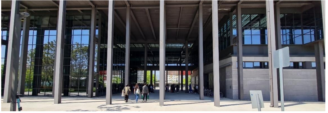
Şekil 4.40: Çelik bina dış görünüm.
