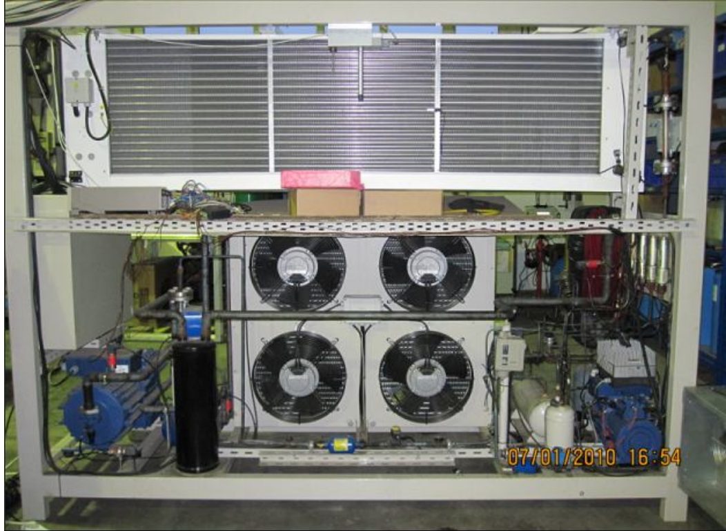
Şekil 7.4. Kaskad Sistem Deney Düzeneği Genel Görünümü (Kondenser Tarafı)
