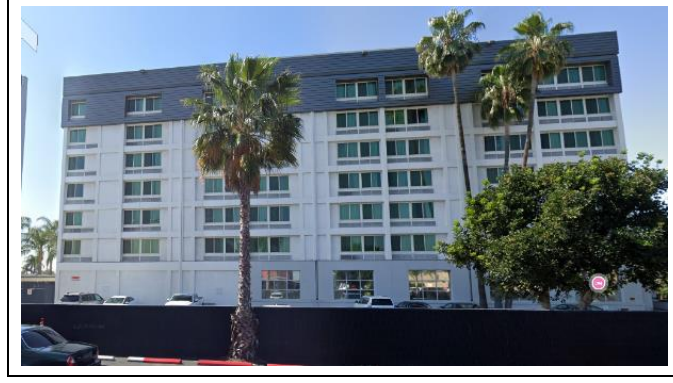
Şekil 4.5: Yapının günümüzdeki kuzey cephesi görünümü.
