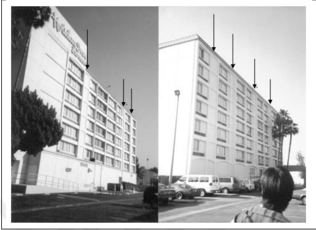
Şekil 4.3: Van Nuys Otel Binası güçlendirme amaçlı cephelere eklenen betonarme perdeler.
