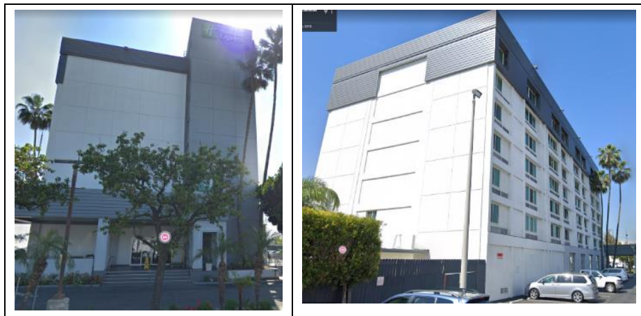
Şekil 4.4: Yapının günümüzdeki doğu ve batı cephesi görünümüleri.
