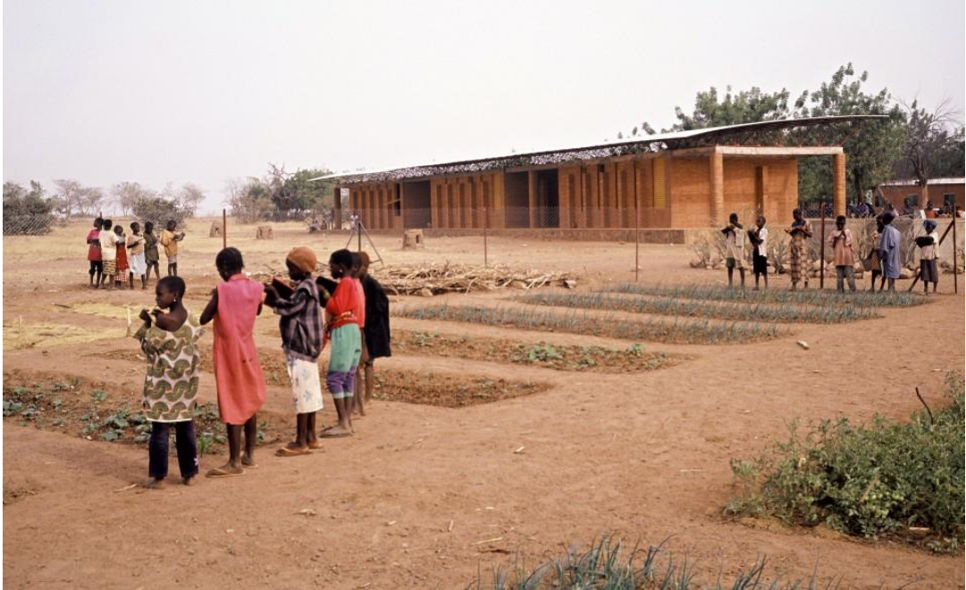
Şekil 3.9: Gando bölgesinde devam eden mimarlık uygulamaları.
