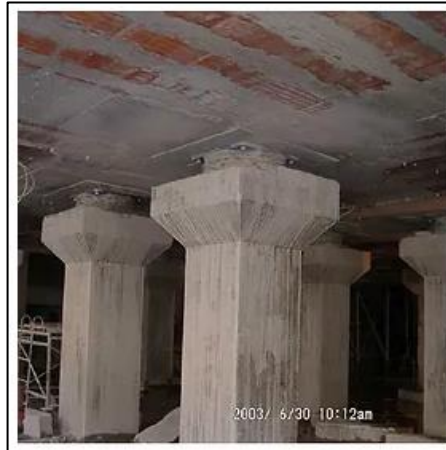
Şekil 3.2: Kocaeli Eğitim ve Araştırma Hastanesi izolatör uygulaması.
