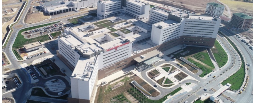
Şekil 3.4: Elazığ Şehir Hastanesi Genel Görünümü.
