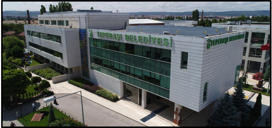
Şekil 4.1: Eskişehir Tepebaşı Belediye Hizmet Binası.
