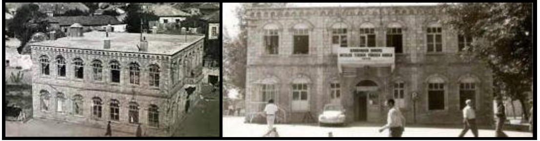
Şekil 4.14: Kahramanmaraş Eski Belediye Hizmet Binası Fotoğrafi.
