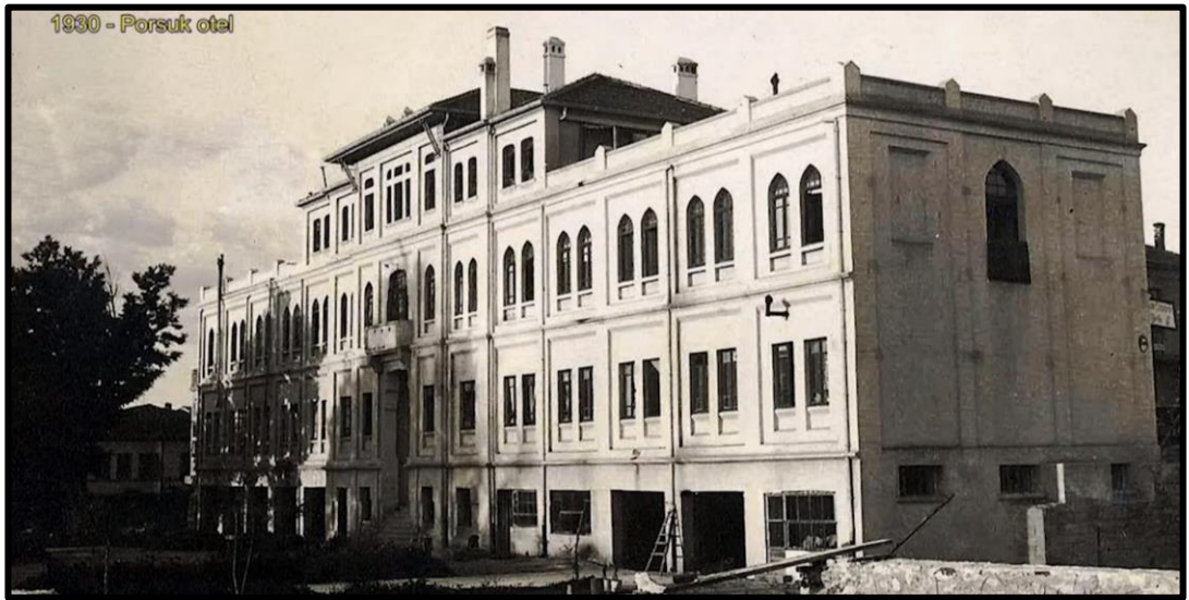
Şekil 4.3: (1930) Porsuk Otel (Eskişehir Eski Belediye Binası).
