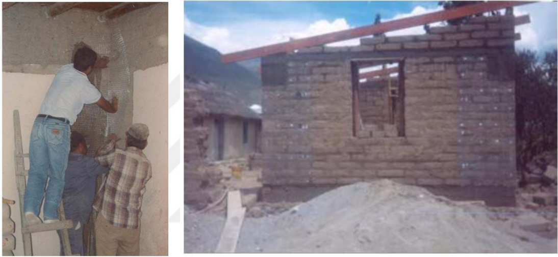
Şekil 3.2: Bir köşeye dikey örgü şeridinin yerleştirilmesi/köşelere çivilenmiş tel örgü şeritleri [98].
