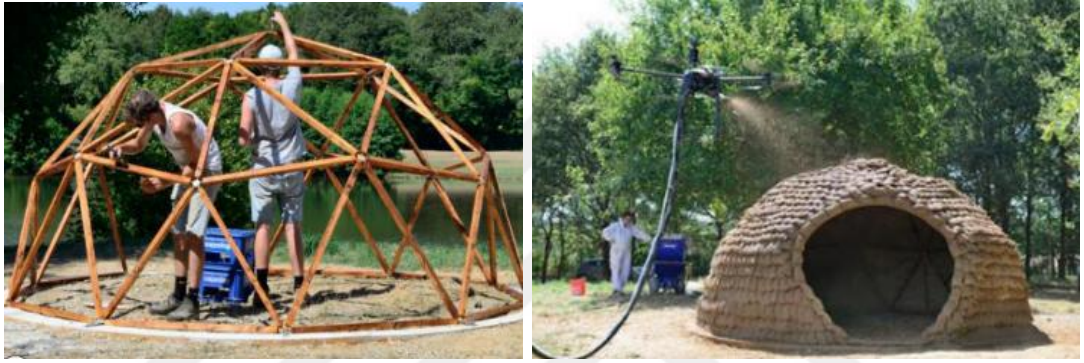
Şekil 3.29: Yapı kabuğu üzerine bio püskürtme yöntemi ile harç aktarımı [116].
