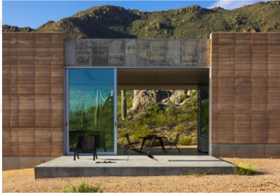
Şekil 2.33: Sıkıştırılmış toprak yöntemi ile yapılan Tucson dağ dinlenme tesisi[53].
