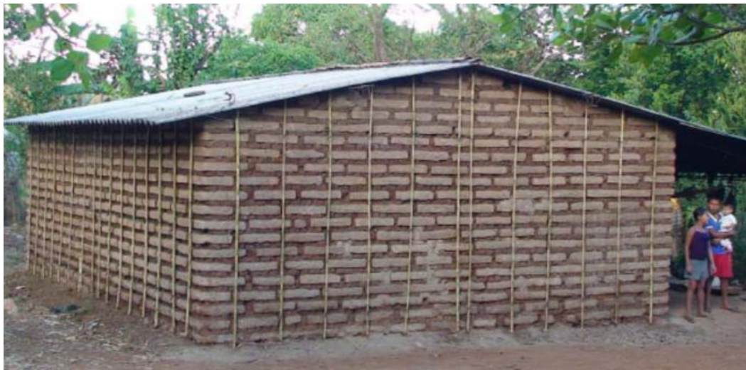
Şekil 3.3: Bambu kayış ile kerpiç duvar güçlendirilmesi [94].
