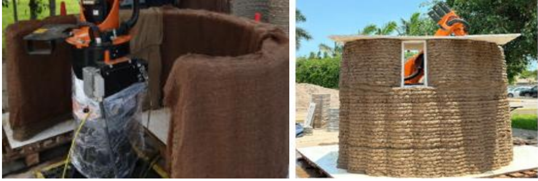
Şekil 3.25: Küreleme süreci ve tamamlanan büyük ölçekli prototip [112].
