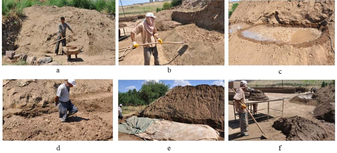
Şekil 2.28: Kerpiç harcının hazırlanması/ a-toprağın elenmesi /b-c-toprak çamurunun hazırlanması/ d- harcın karıştırılması/ e-harcın dinlendirilmesi / e-hazırlanan harç [48].
