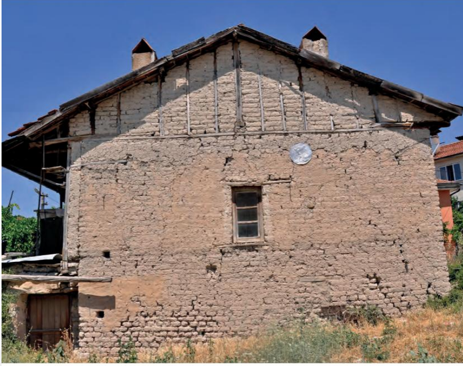
Şekil 2.35: Yığma kerpiç yapı [18].
