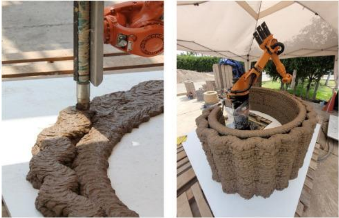
řekil 3.24: Kuka robotik kolu ile katman yapım sreci [112].
