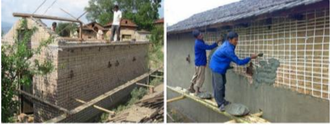
Şekil 3.4: Kerpiç duvarların ağ tipi dış güçlendirmesi [97].
