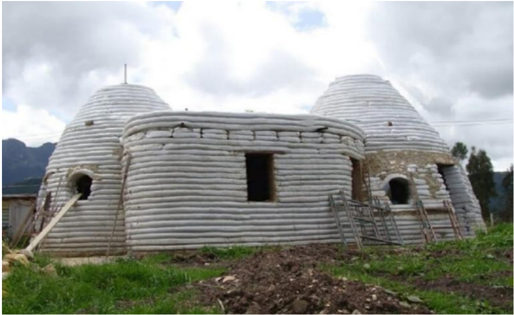
Şekil 2.43: Toprak çuval yapı [66].
