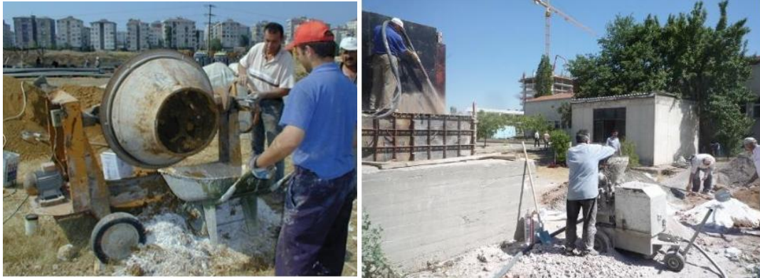
Şekil 4.5: Beton mikseri ve püskürtme yöntemi ile kerpiç yapı yapımı (kaynak: U1 arşivinden).
