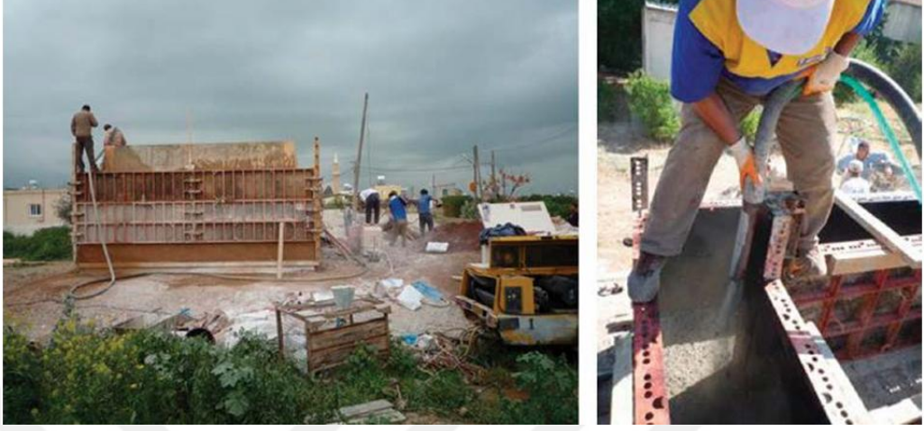
Şekil 2.34: Püskürtme yöntemi ile kerpiç üretimi [55].
