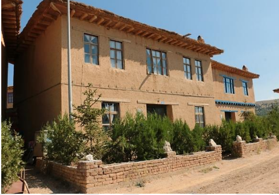
Şekil 2.40: Ahşap hatıllı kerpiç dolgulu yapı [60].
