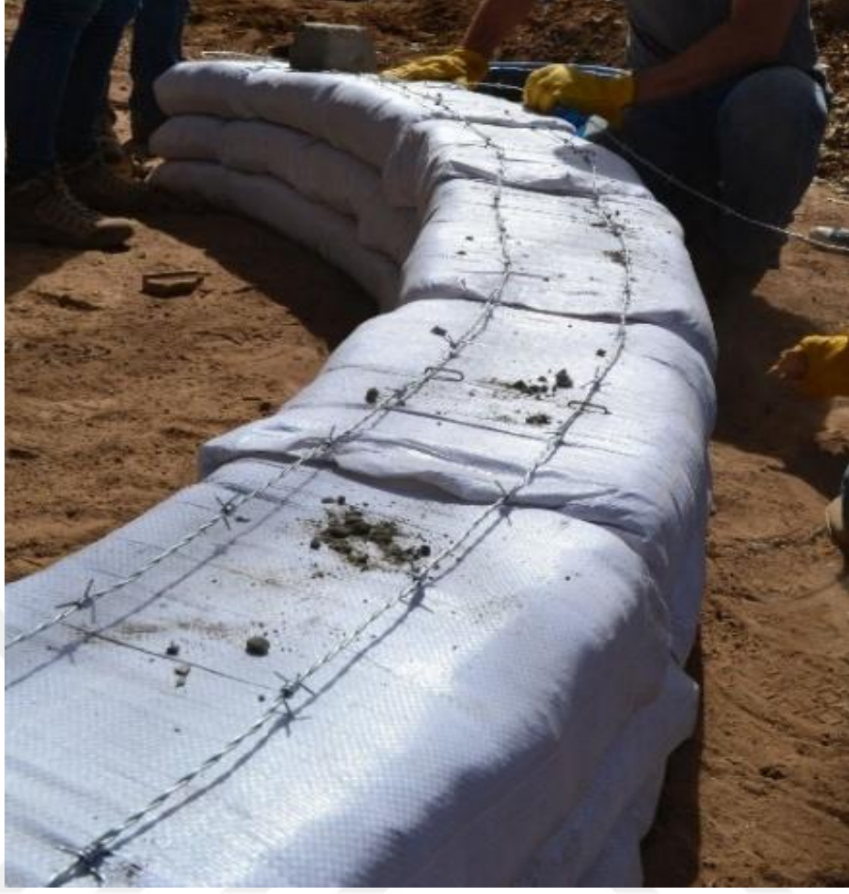
Şekil 2.42: Toprak çuval yapı hazırlanışı [66].
