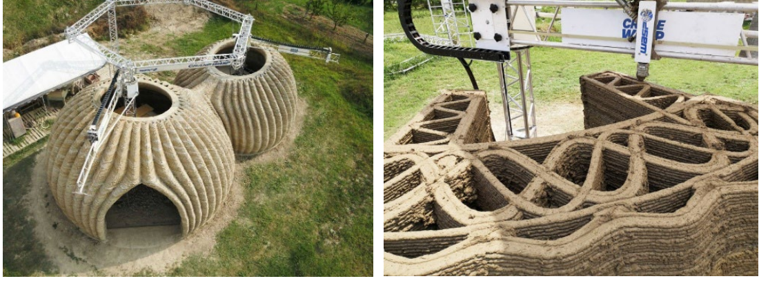
Şekil 4.50: TECLA: a) ev prototipi, b) duvar yapısı [238].
