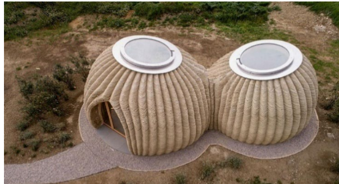
Şekil 4.42: Kabuk yapı uygulaması [230].
