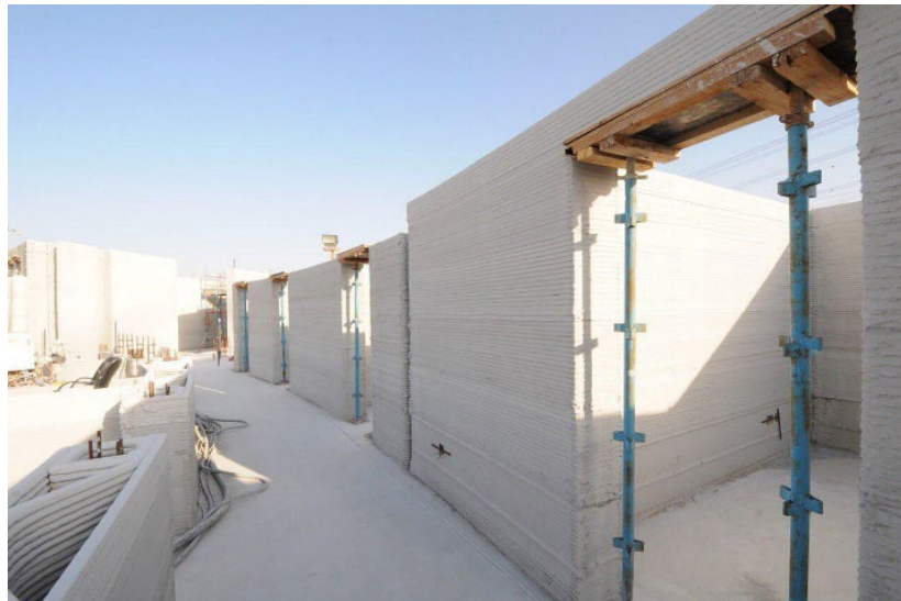
Şekil 4.34: Kapı yerlerinin oluşturulması [225].
