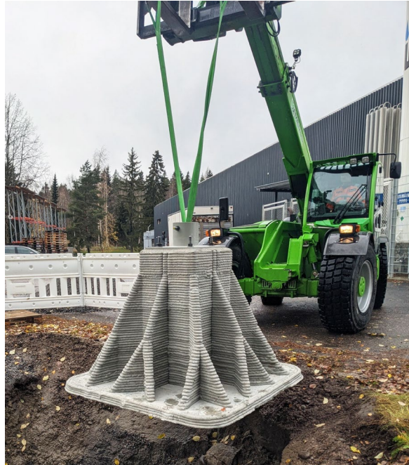
Şekil 4.26: Enerji santrali için düşük karbonlu temel [218].
