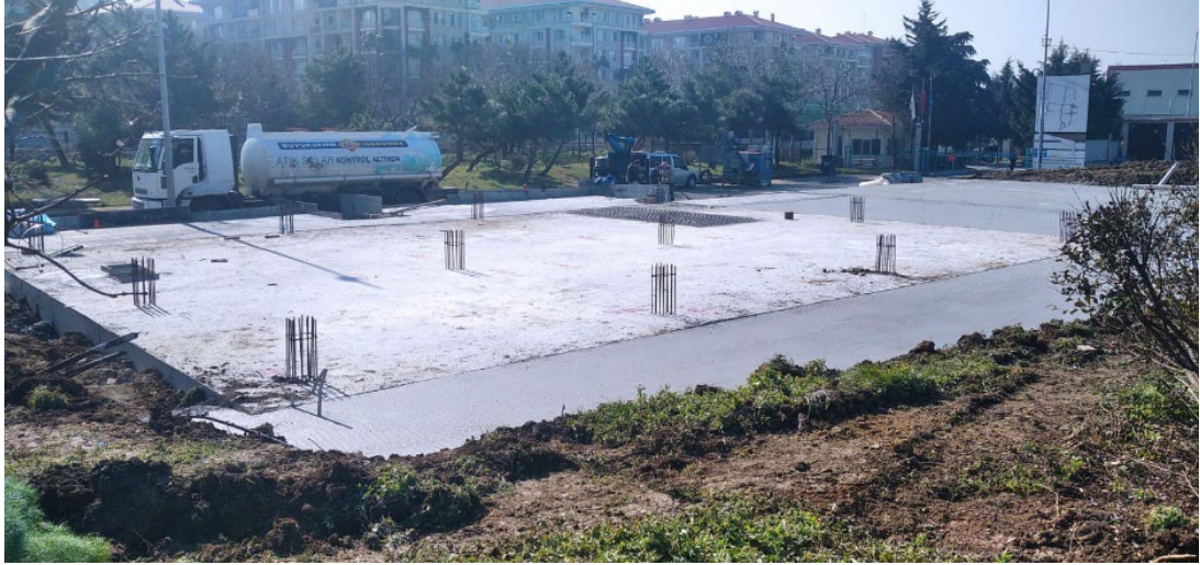
Şekil 5.7: 3D yazıcı teknolojisiyle yapı üretimi öncesinde oluşturulan temel [247].
