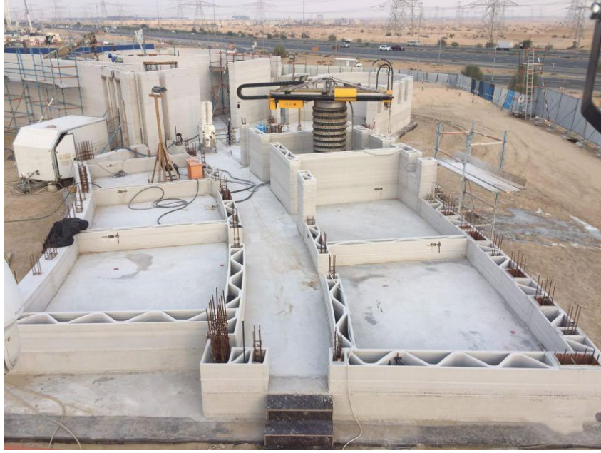
Şekil 4.33: Dubai’de üretilen bir ofis yapısının inşası [225].
