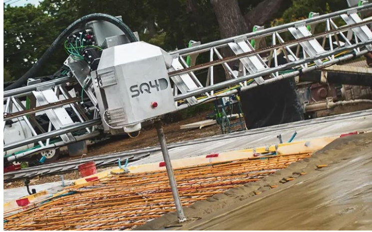
Şekil 4.27: ARCS yazıcı kullanılarak üretilen temel [219].
