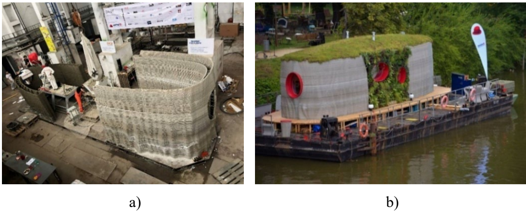
Şekil 4.54: Floating House: a) üretim aşaması, b) yapının su üstündeki hali [242].
