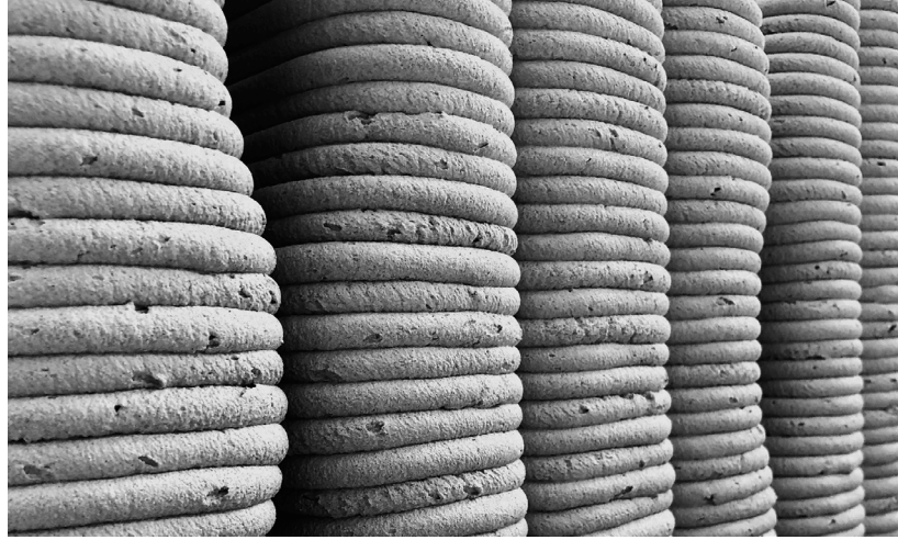
Şekil 3.28: 3D yazıcı teknolojisiyle üretilen beton yüzey [148].
