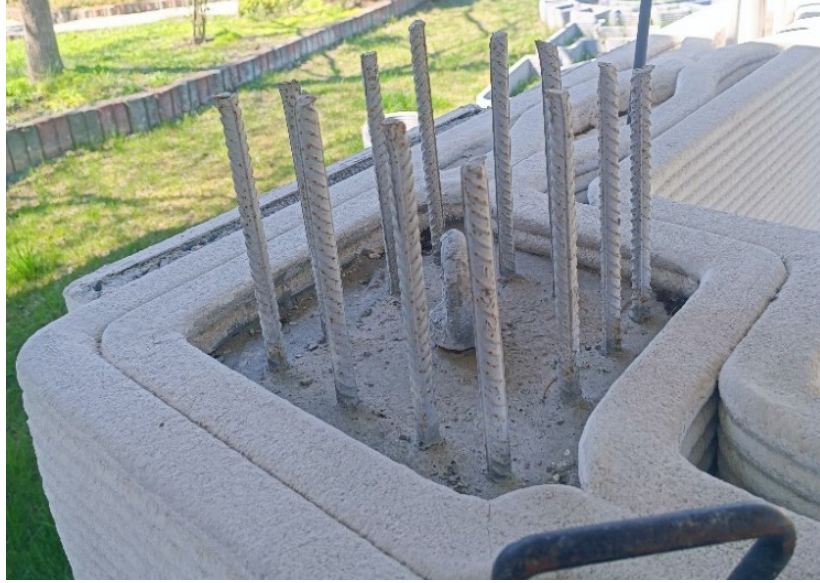
Şekil 5.8: 3D yazıcı teknolojiyle üretilen kolon [246].
