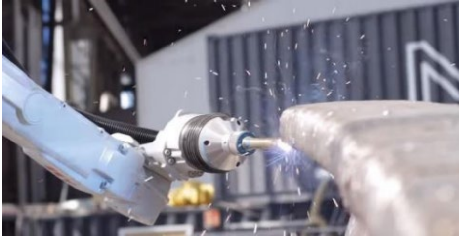
Şekil 3.10: LENS tekniği ile Hollanda’da metal köprü inşası [6].
