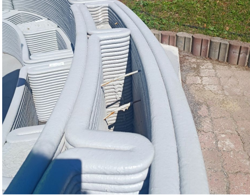
Şekil 5.2: Üretim sırasında eklenen destek yapısı [246].
