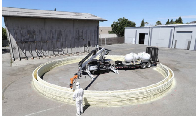
Şekil 4.24: Keating'in çift duvarlı kubbe yapısı üretimi [216].
