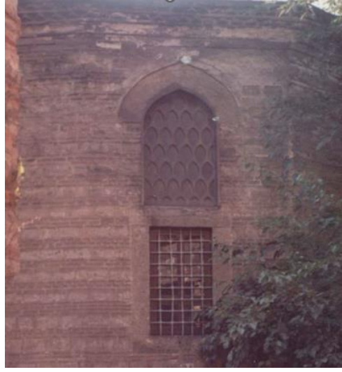
Şekil 4.59: Atıf Efendi Kütüphanesi almalı duvar örgüsü ve pencere sövelerinde küfeki taşı ( Atatürk Kitaplığı ).
