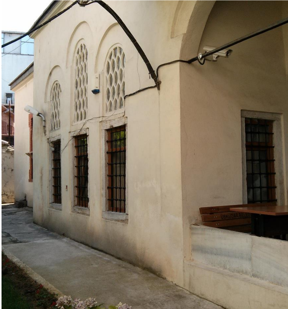
Şekil 4.110: Hacı Selim Ağa Kütüphanesi yan cephesi.
