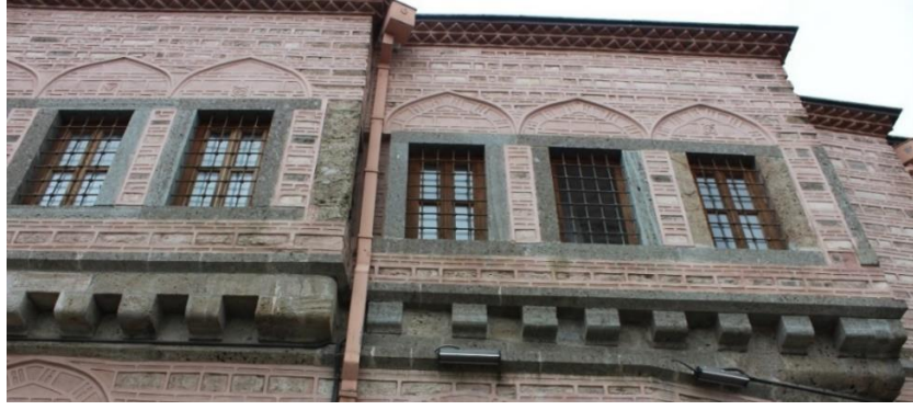
Şekil 4.63: Atıf Efendi Kütüphanesi meşruta ev cephesi.
