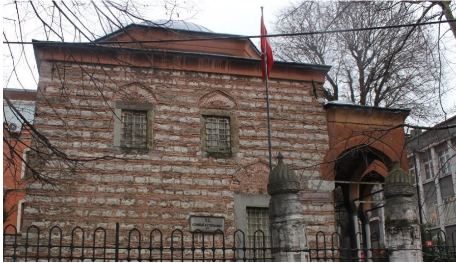
Şekil 4.7: Köprülü Kütüphanesi Divanyolu cephesi yapı malzemeleri.
