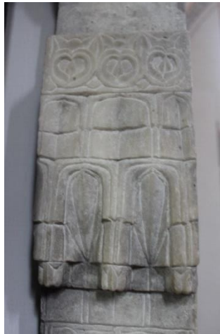
Şekil 4.43: Kütüphane ve dersane/mescit mekanlarının giriş kapı söveleri.
