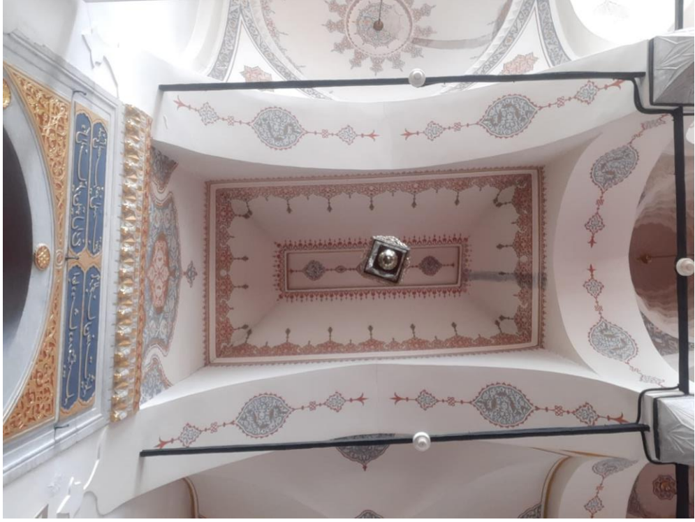
Şekil 4.24: Feyzullah Efendi Kütüphanesine ara mekândan kütüphaneye geçiş kısmı aynalı tonoz.
