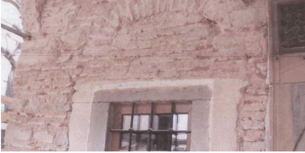
Şekil 4.104: Hacı Selim Ağa Kütüphanesi almaşık duvar detayı (KTVKK İstanbul 6 numaralı Bölge Müdürlüğü).
