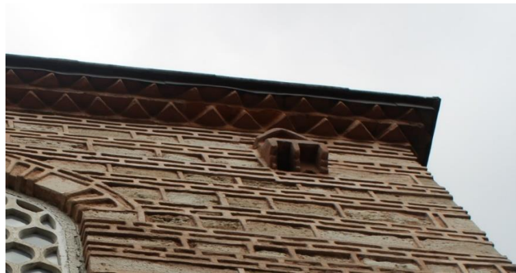
Şekil 4.34: Feyzullah Efendi Külliyesi dersane/mescit cephesi kuş evi ve kirpi saçak detayı.
