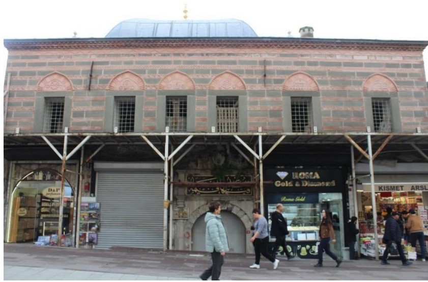
Şekil 4.91: Ragıp Paşa Külliyesi Ordu Caddesi (Koska Caddesi) cephesi.
