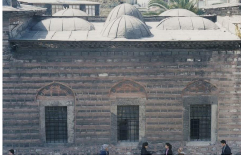
Şekil 4.31: Feyzullah Efendi Külliyesi Macarlar Caddesi cephesi kütüphane- derslane arası ara mekân cephesi ( Atatürk Kitaplığı ).
