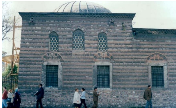
Şekil 4.32: Feyzullah Efendi Külliyesi Macarlar Caddesi Cephesi dersane/mescit mekânı cephesi ( Atatürk Kitaplığı ).
