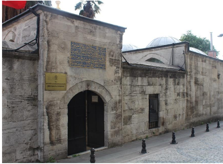
Şekil 4.20: Feyzullah Efendi-Millet Kütüphanesi Feyzullah Efendi Sokağı cephesi kesme taş inşa düzeni.
