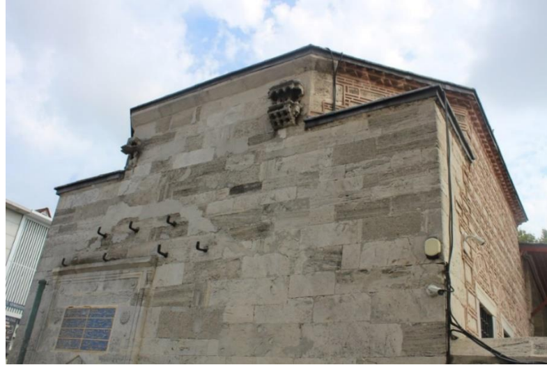
Şekil 4.29: Feyzullah Efendi Kütüphanesi kesme taş düzeni ve kuş evi.
