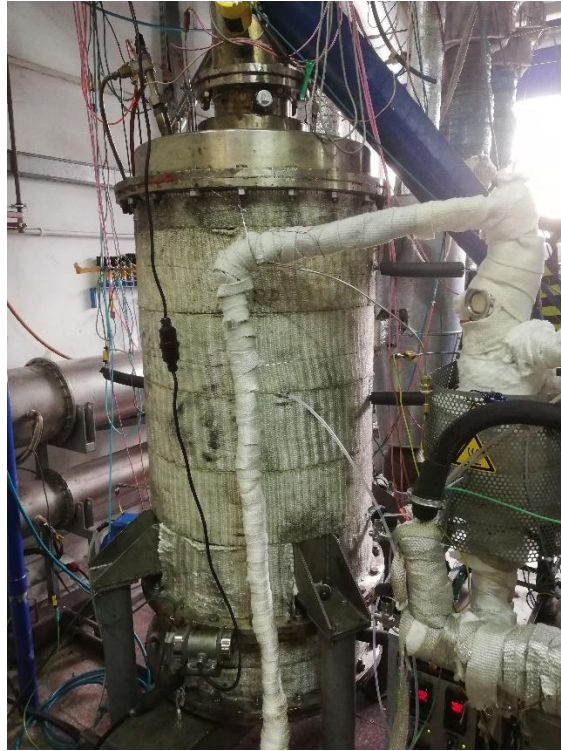
Şekil C1.1: Hava üflemlili gazlaştırıcının fotoğrafı.
