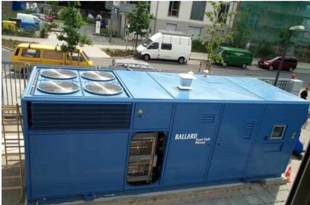
Şekil 2. 9. Ballard 250 kW PEM yakıt pili sabit uygulaması [7]
