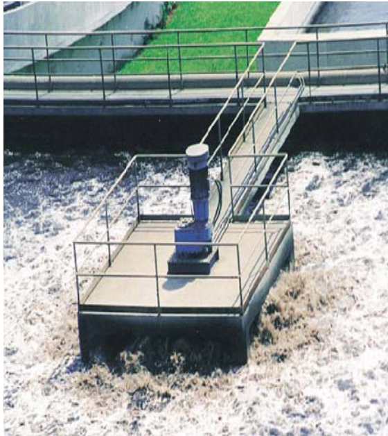
Şekil 6.1. (a) Düşük hızlı düşey milli mekanik yüzey havalandırıcısı [Astım, Katalog].
