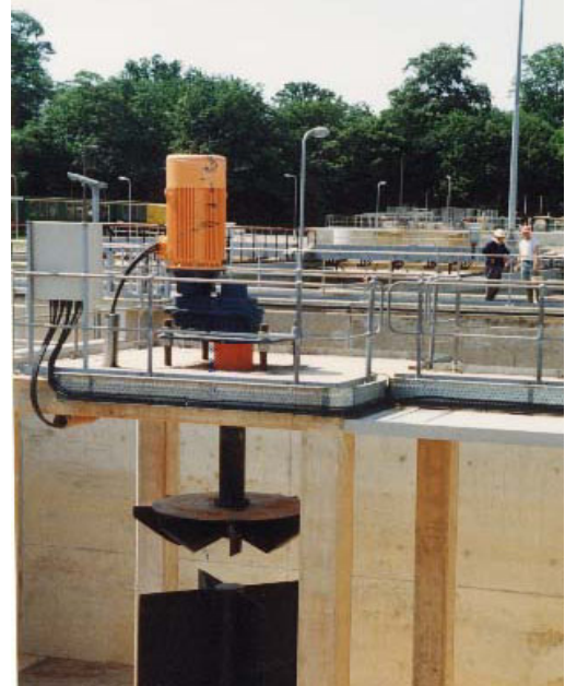
Şekil 6.1. (b) Akım kırıcılı düşük hızlı düşey milli mekanik yüzey havalandırıcısı [Biwater Treatment, Brochure].
