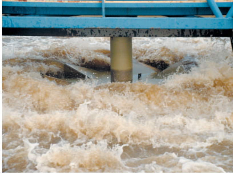
Şekil 2.22. Düşük hızlı düşey milli mekanik yüzey havalandırıcı pervane çalışma konumu [Landustrie Water Technologie Broshure, 2007]
