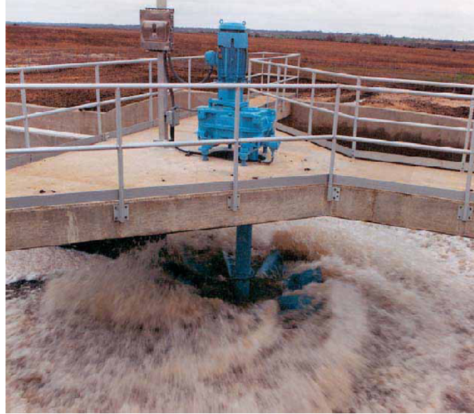
Şekil 2.19. Düşük hızlı düşey milli mekanik yüzey havalandırıcısı çalışma esnasındaki resmi [Eimco Water Technologies, 2004]
