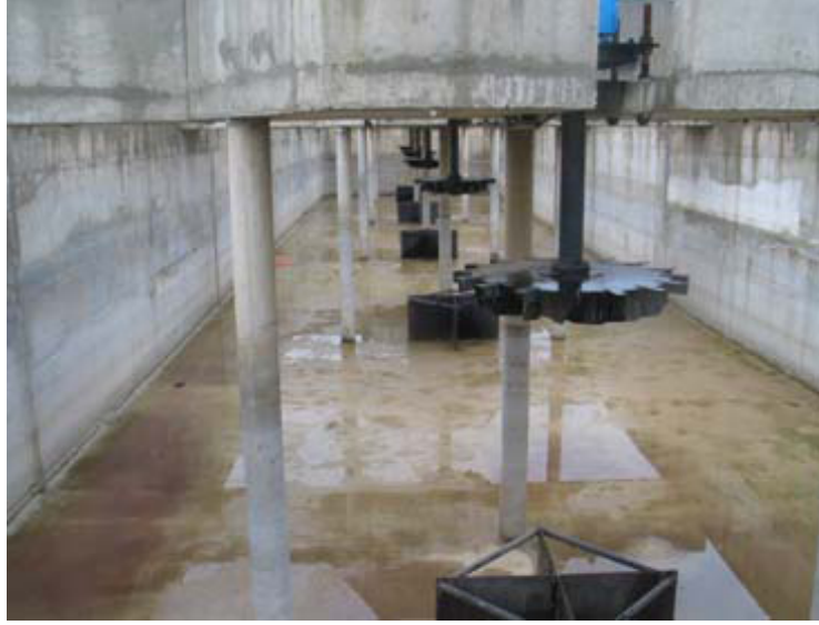
Şekil 2.20. Düşük hızlı düşey milli mekanik yüzey havalandırıcı pervanesi [Astım, Katalog]
