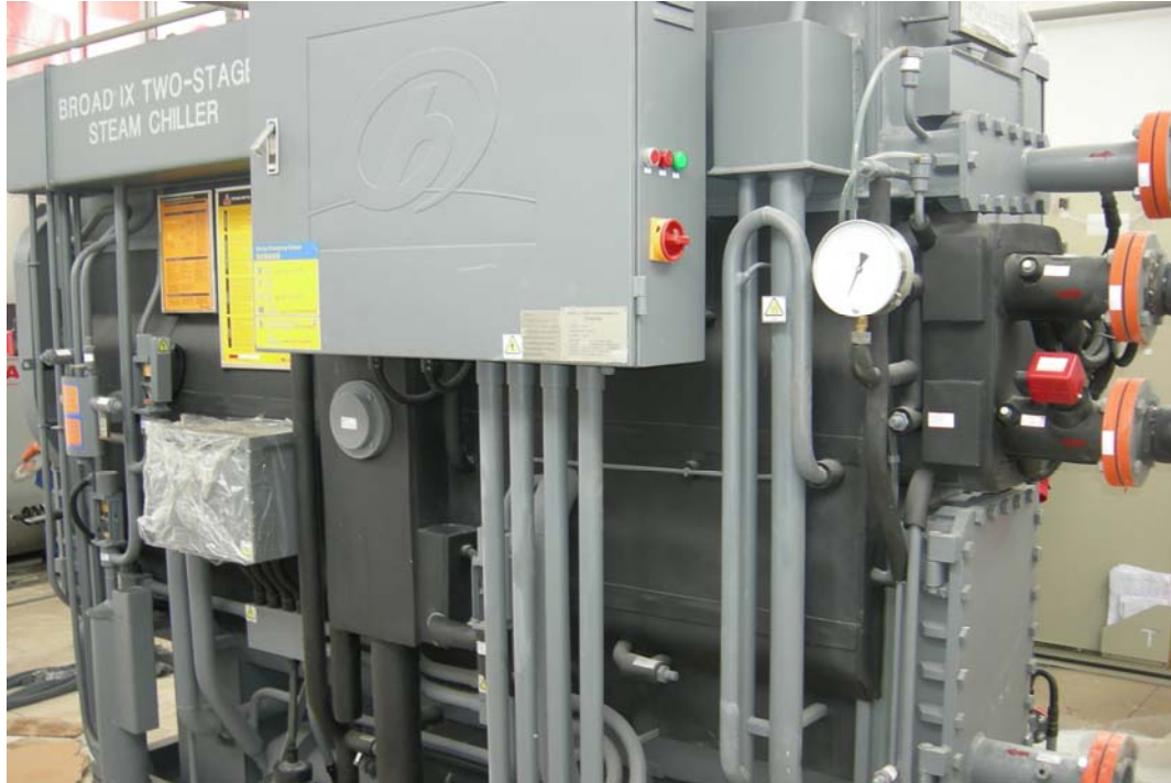
Şekil 6.4 Sistemde kullanılan absorpsiyon sistemi
