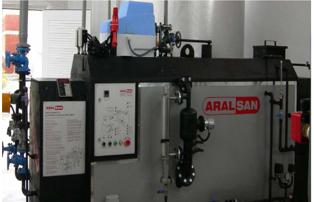
Şekil 6.6 Buhar Jeneratörü
