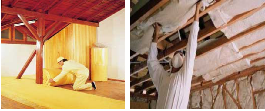
Resim 4.2. Mevcut Yapılara Çatı Yalıtımı Uygulanması
