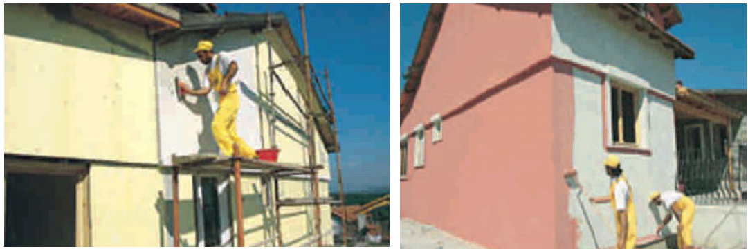
Resim 4.1. Mevcut Bir Yapıya Dıştan Isı Yalıtım Uygulanması
