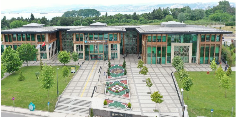
Şekil 4.6: Başiskele Belediye Hizmet Binası.
