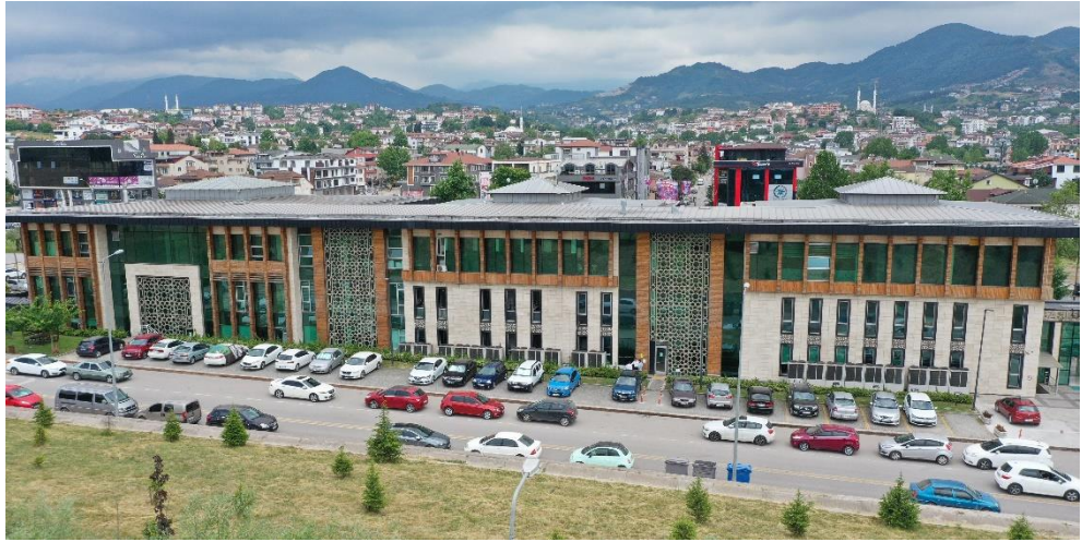
Şekil 4.7: Başiskele Belediye hizmet binası.
