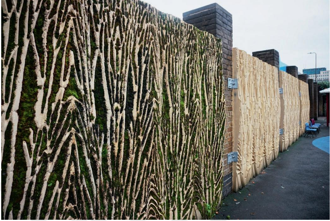
Şekil 3.15: St. Anne East Putney Bio-Receptive Wall örneği üzerinden doğaya karşı tepki verebilen duvar, Marcos Cruz.
