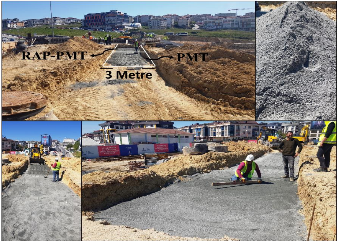
Şekil 4.3: Tesviye kumu imalatı.
