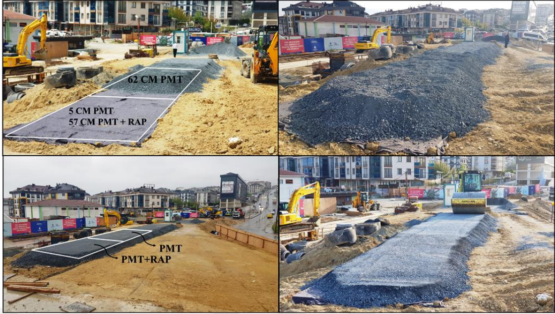
Şekil 4.7: PMT tabakası imalatları.
