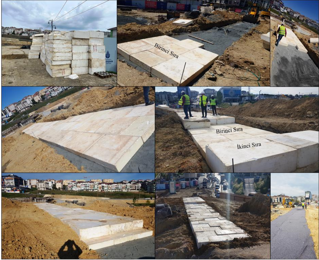
Şekil 4.6: Geofoam blok imalatları.
