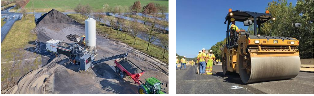
Şekil 2.16: Soğuk geri dönüşüm plenti ve uygulaması.
