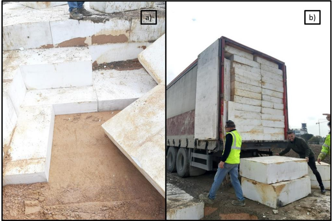
Şekil 3.2: a) Geofoam blokların sökümü, b) Blokların servis yolunda bu çalışma kapsamında kullanılmak üzere taşıta yüklenmesi.
