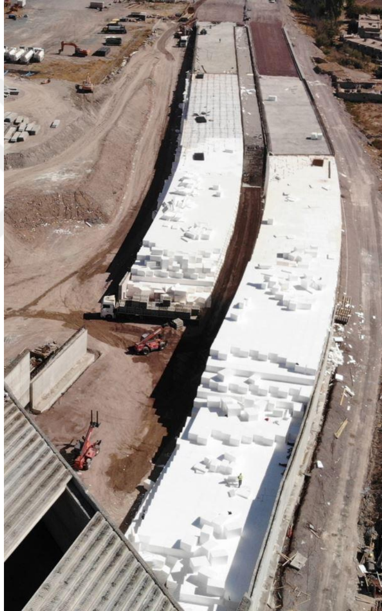
Şekil 2.10: Geofoam blok köprü yaklaşım dolgusu, Boğazköy Köprüsü,Kayseri [Özer,2020].
