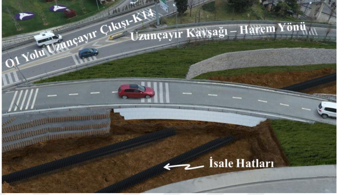
Şekil 2.13: İsale hatları üzerine inşa edilen geofoam blok yol dolgusu, Acıbadem, İstanbul [Özer, 2020].
