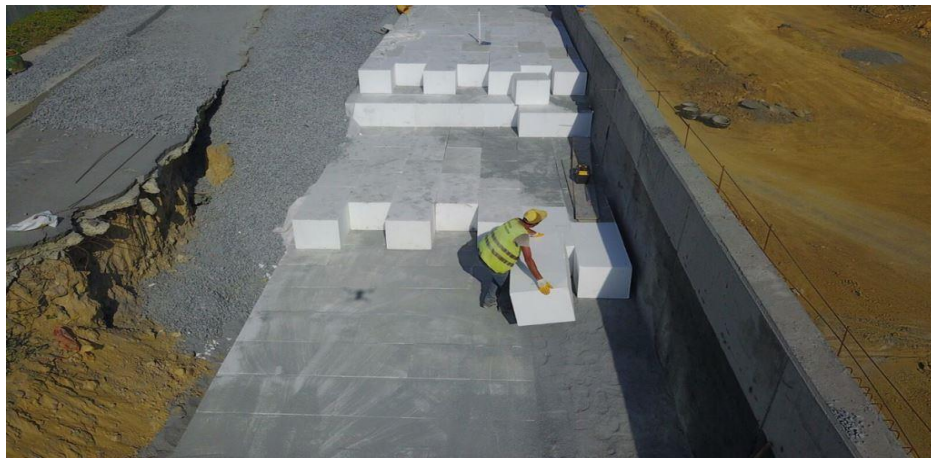
Şekil 2.11: İstinat duvarı geofoam blok geri dolgu imalatı, Kayaşehir, İstanbul [Özer, 2020].
