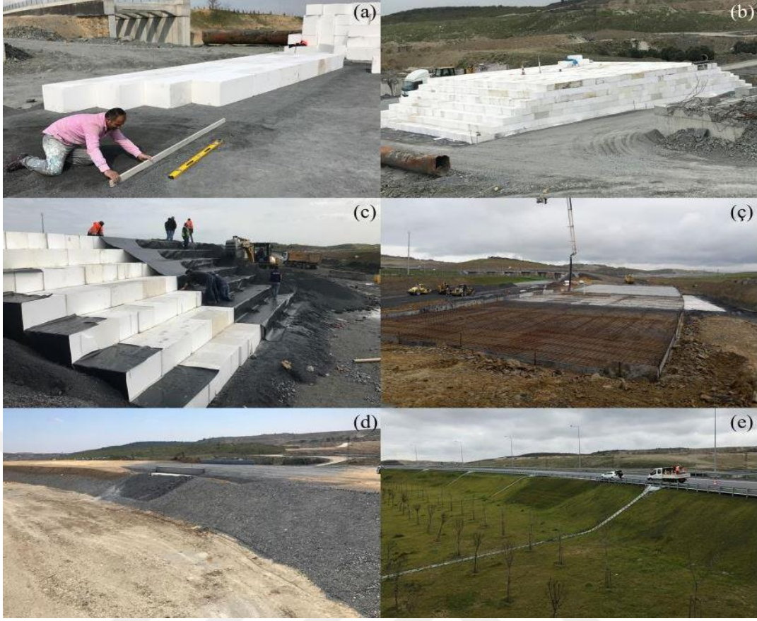
Şekil 2.8: Geof foam blok yol dolgusu uygulaması (a) tesviye kumu serilmesi (b) geof foam blok yerleşimi (c) şevde geomembran uygulaması (ç) betonarme yük yayma platform imalatı (d) yol üst yapı imalatı (e) tamamlanmış imalat [Özer, 2020].
