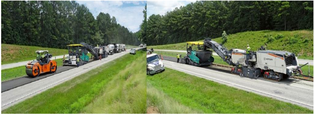
Şekil 2.15: Yerinde soğuk geri dönüşüm uygulaması.
