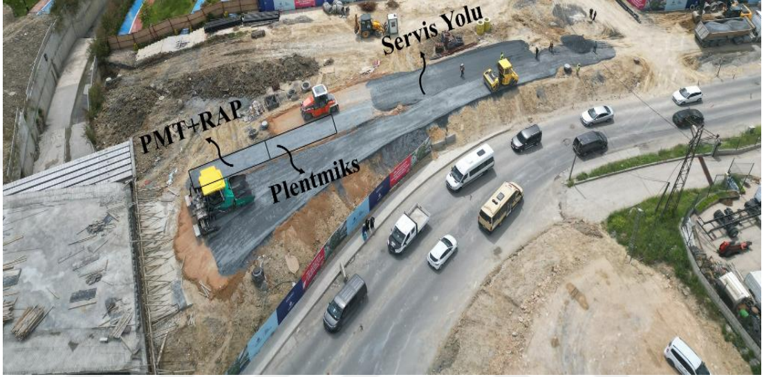
řekil 4.19: Asfalt tabakaları imalatı.
