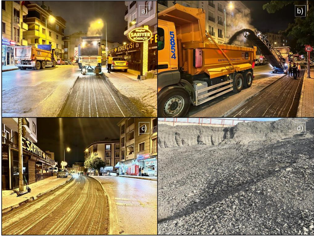
Şekil 3.1: a) Asfalt kazıma çalışmaları, b) Kazılmış asfaltın kamyonlara yüklenmesi, c) Kazımı tamamlanmış asfalt, d) RAP depo alanı.
