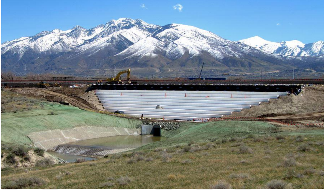
Şekil 2.12: Menfez üzeri geof foam blok demiryolu dolgusu, Draper, UT, USA [Bartlett vd., 2015].
