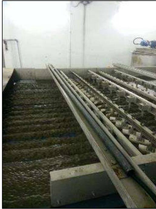
Şekil 4.9: Mekanik çamur yoğunlaştırma ünitesi.
