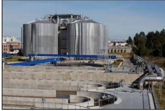
Şekil 4.3. Anaerobik çamur çürütücüler.
