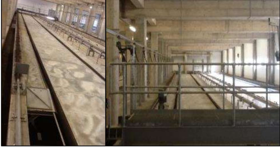
Şekil 4.4: Havalandırmalı kum ve yağ tutucu görüntüleri.
