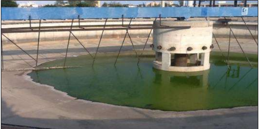
Şekil 4.8: Çökeltme havuzları.
