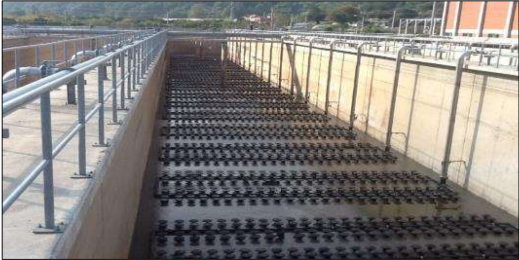
Şekil 4.7: Havalandırma havuzu ve yerleşimi.
