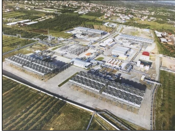
Şekil 1. 5: Aydıncık'ta yer alan pamukören jeotermal elektrik üretme tesisi.
