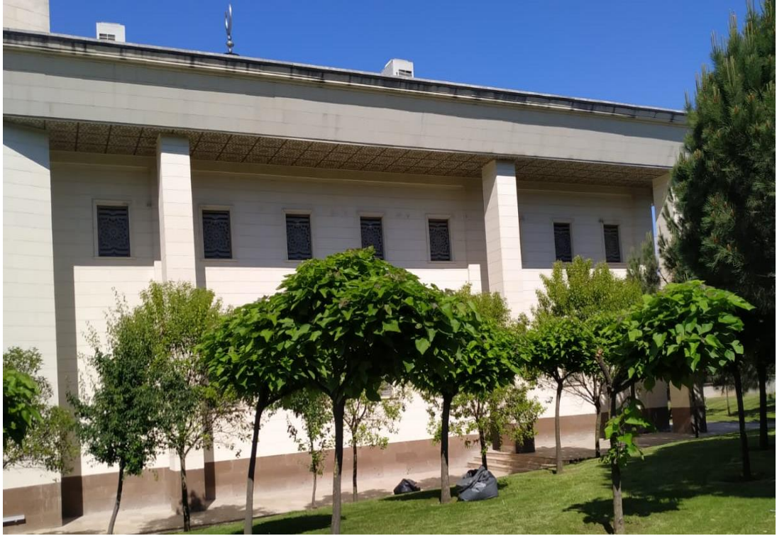
Şekil 4.40: GEPOSB Camisi Kolon Uygulaması.
