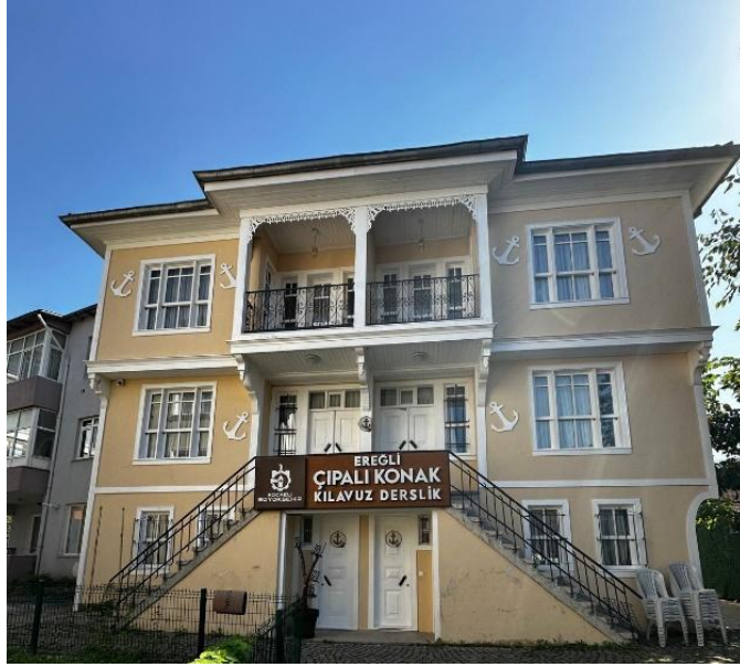
Şekil 3.42: Çıpalı Konak kuzey cephe [Yazar, 2024].
