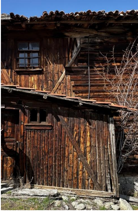
Şekil 2.8: Dizeme duvarlı yapı, Bolu [Yazar, 2025].
