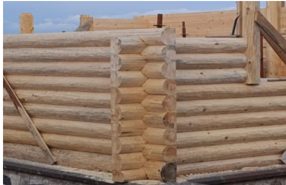
Şekil 2.2: Yığma ahşap sistemde köşe duvar birleşimi [Yazar, 2025] .
