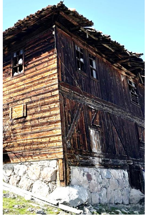
Şekil 2.8: Dizeme duvarlı yapı, Bolu [Yazar, 2025].
