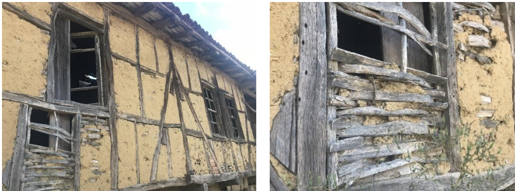
Şekil 2.6: Dal örgü duvar sistemi, Tahtalı Köyü/Derince [Yazar, 2018].
