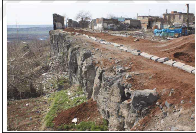
Şekil 3.8: Deprem sonucu yıkılıp ters döndüğü düşünülen duvar.
