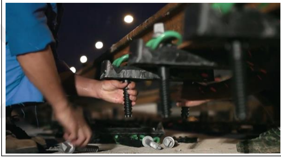
Şekil 5.13: Sultan 2.Abdülhamid Han'ın kabri önündeki tramvay hattında yapılan ilave izolasyon uygulaması.
