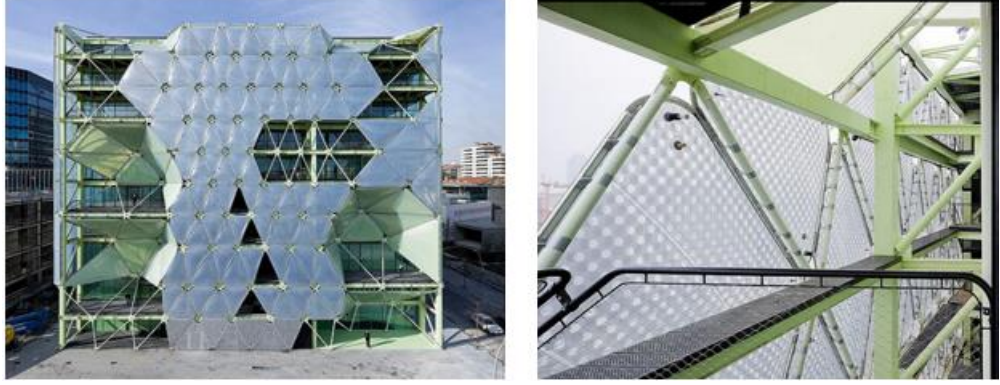
Şekil 3.25: Media-TIC yapısının kinetik/adaptif cephesi [Web 23'den yararlanarak yazar tarafından oluşturulmuştur].
