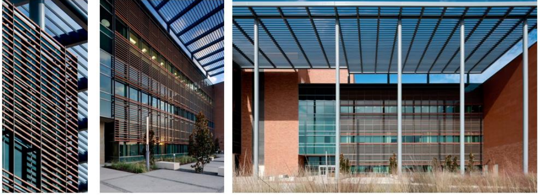
Şekil 3.13: San Antonio Askerî Tıp Merkezi'nde yatay güneş kontrol elemanlarının cephedeki uygulaması [Web 13'ten uyarlanarak yazar tarafından oluşturulmuştur].
