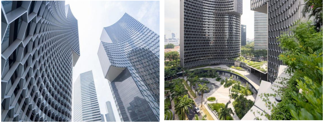
Şekil 3.16: DUO İkiz Kuleleri cephesinde sabit kare-kafes güneş kontrol elemanı uygulaması [Web 15'ten uyarlanarak yazar tarafından oluşturulmuştur].
