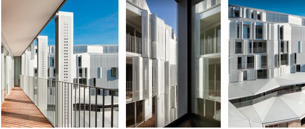
Şekil 3.20: M9-C yapısının cephesinde kullanılan manuel ayarlanabilir güneş kontrol elemanları [Web 20'den uyarlanarak yazar tarafından oluşturulmuştur].
