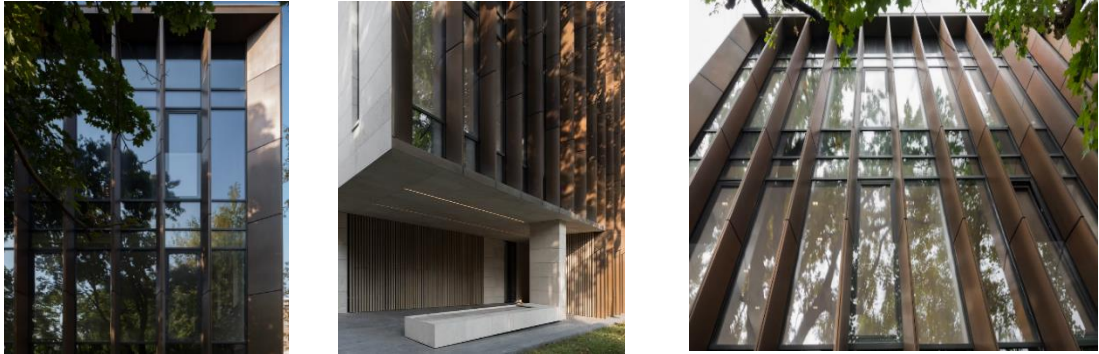
Şekil 3.8: Chekhov Apartman Bloğu’nda kullanılan sabit dikey güneş kontrol elemanlarına ilişkin cephe görselleri [Web 11’den uyarlanarak yazar tarafından oluşturulmuştur].
