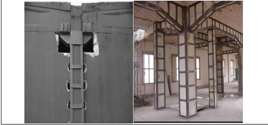
Şekil 2.13: Kolon çelik sargı manto görseli.
