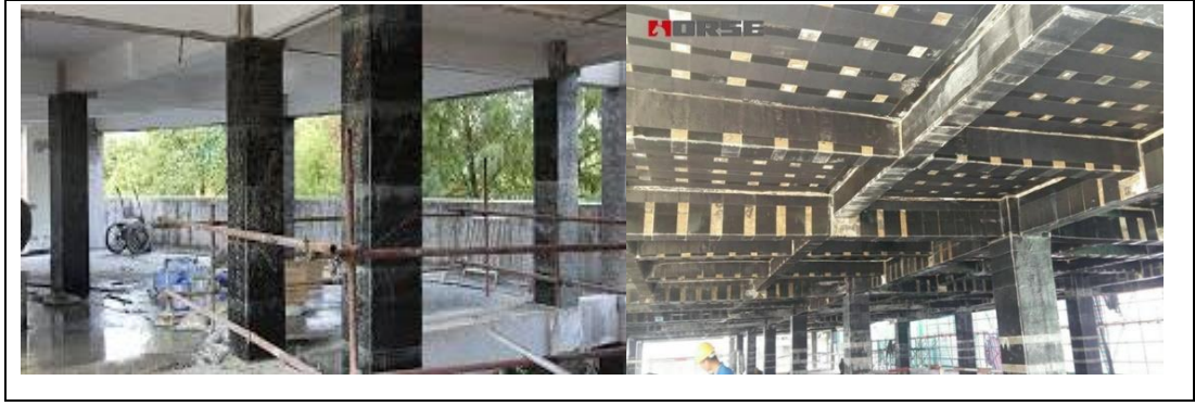
Şekil 2.14: Karbon lifli kolon-kiriş sargı görseli.
