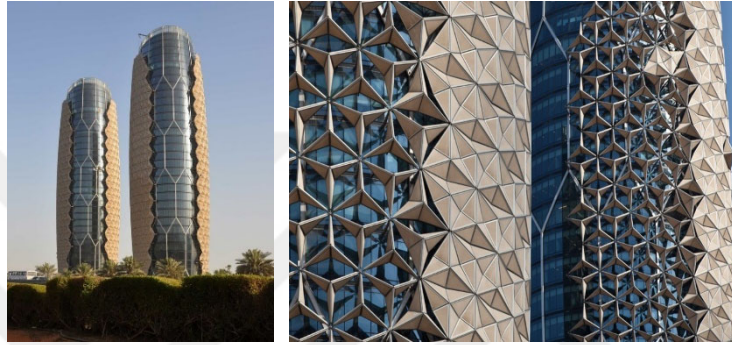
Şekil 2.17: Al Bahar Kuleleri cephesi, 2012[Web 3, 2021].
