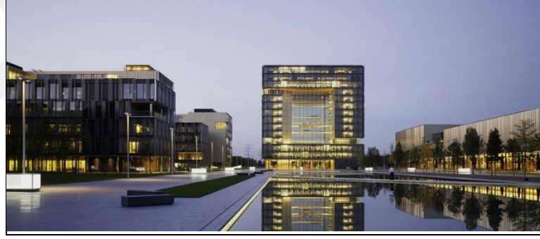
Şekil 4.46: ThyssenKrupp Mahallesi ve Q1 Binası.
