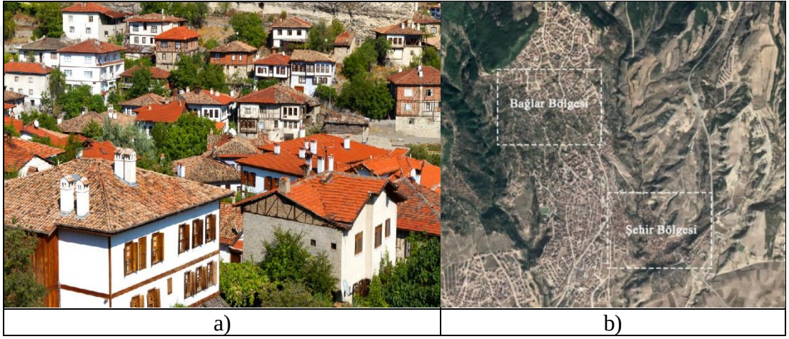
Şekil 3.11: a) Safranbolu evlerinin topoğrafya ile uyumlu genel görünüşü, b) Safranbolu evlerinin yoğunlaştığı şehir ve bağlar bölgeleri.
