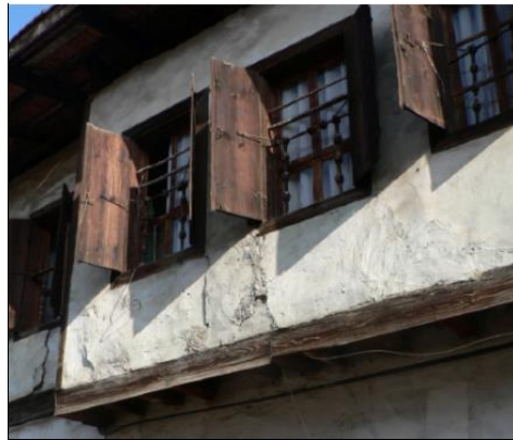
Şekil 3.14: Safranbolu evlerinde kullanılan kara kepenk gölgeleme elemanları.
