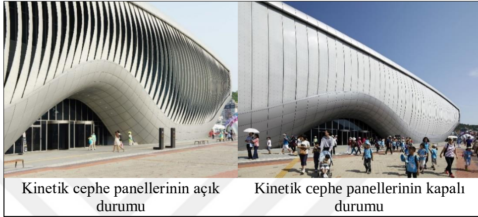
Şekil 4.34: Kinetik cephe panellerinin açık ve kapalı durumu.
