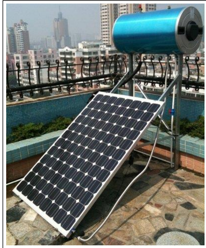
Şekil 5.3: Temsili Su bazlı PV/T sistemi.
