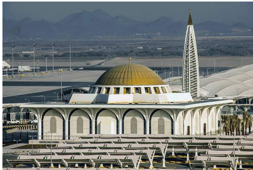
Şekil 4.5: Genişletme kapsamında inşa edilen cami.
