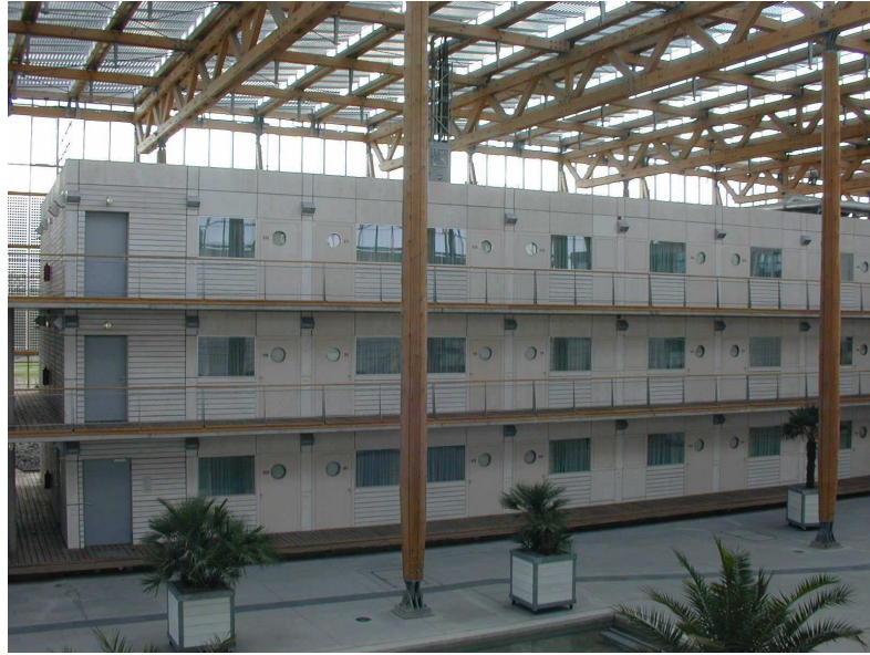
Resim 2. 15 m Yüksekliğinde Çatı Örtüsü ve İç Binalar [37].
