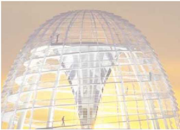
Resim 21. Ayna Kaplı Ters Koni Şeklindeki Havalandırma Bacası ve Toplantı Salonunun Doğal Aydınlatılması
