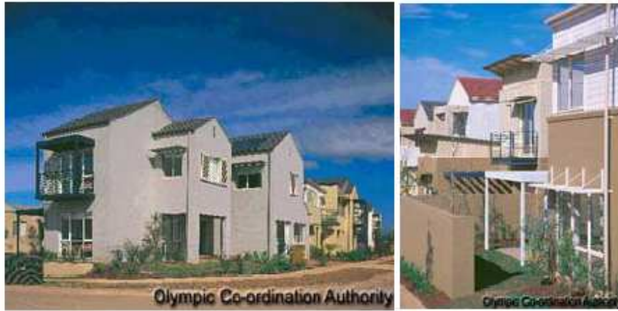
Resim 11. Sporcu güneş evlerinden görünüm, [39]
