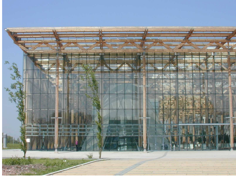
Resim 1. 15 m Yüksekliğinde Çatı Örtüsü [37].
