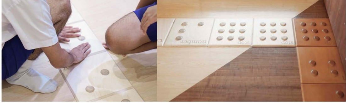
Şekil 4. 27: Görme Engelliler Sınıfı Zemin Detayı.
