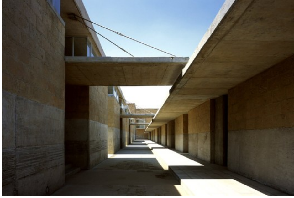
Şekil 4. 17: Görme Engelli Merkezi Beton Yüzeyler.
