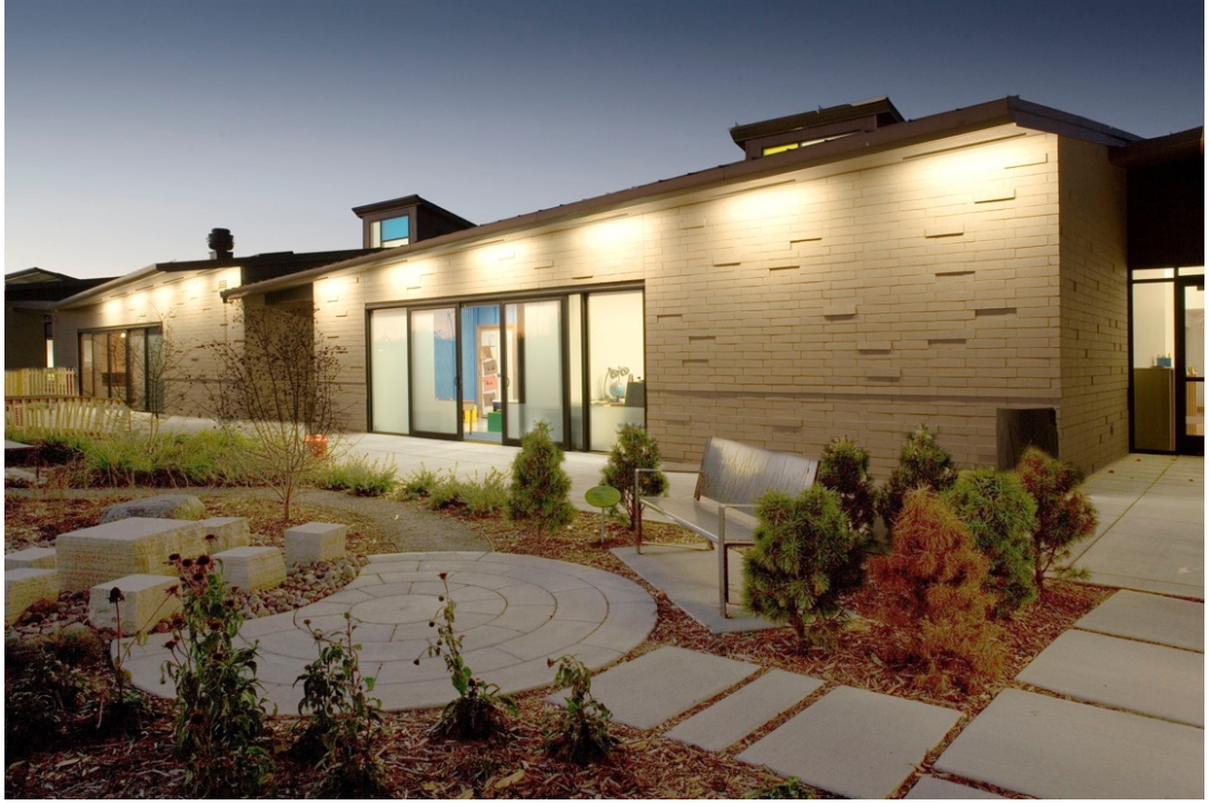
Şekil 4. 35: Bağlantı Merkezi Sarı Duvar.
