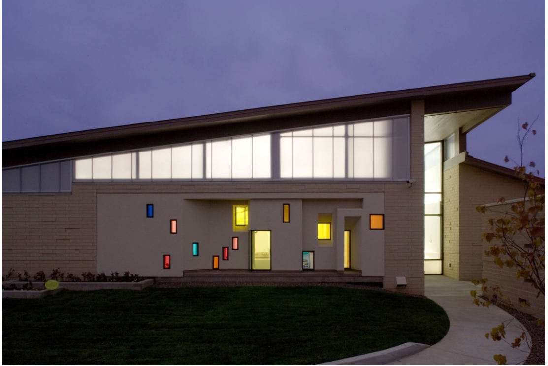
Şekil 4. 36: Bağlantı Merkezi Cephesi.
