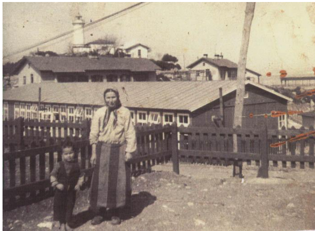
Şekil 4.13: Kilise, 100. Yıl Sokak Lojmanları, Fener Kulesi, 1950.
