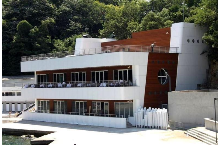
Şekil 4.27: Deniz Kulübü Yıkılarak Yeniden Yapılan Kısım.
