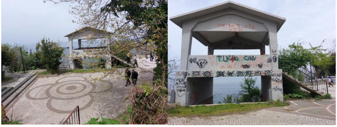
Şekil 4.18: Tulumba Katı- Seyir Terası- Aşıklar Kulesi,2022.
