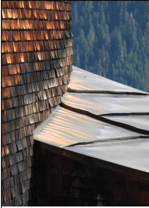
Malzeme – Birleşim Detayı.
