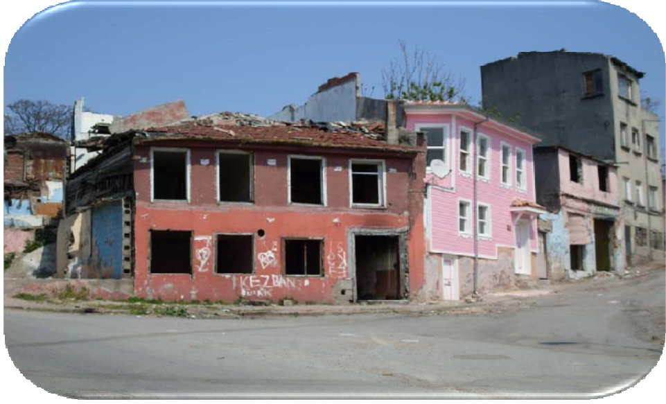
Şekil 3.10. Sarmaşık sokak ve Kaleboyu caddesi köşesinde, yıkılmayı bekleyen iki binanın arasında, sivil mimarlık örneği olduğu için korunmuş yapıdan bir görünüm
