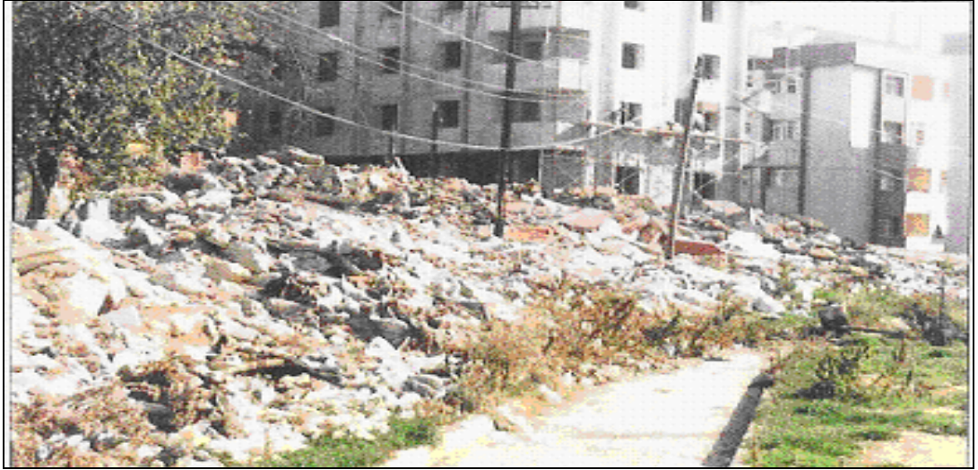
Şekil 2.6. Yapısal atıklarının kontrolsüz dökümü sonucu oluşan görüntüler (Ölmez. 2006)
