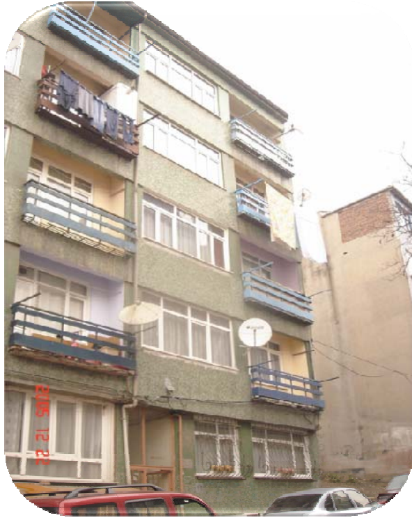
Şekil 3.16. Çalışma alanında yedi katlı betonarme yapı (İBB BİMTAŞ A.Ş Fatih Kentsel Dönüşüm Projesi, Nisan 2009)
