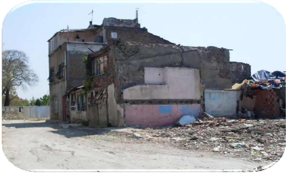
Şekil 3.12. Prof .Naci Şensoy caddesi ile Kaleboyu caddesi köşesinde yığma bir yapıdan bir görünüm
