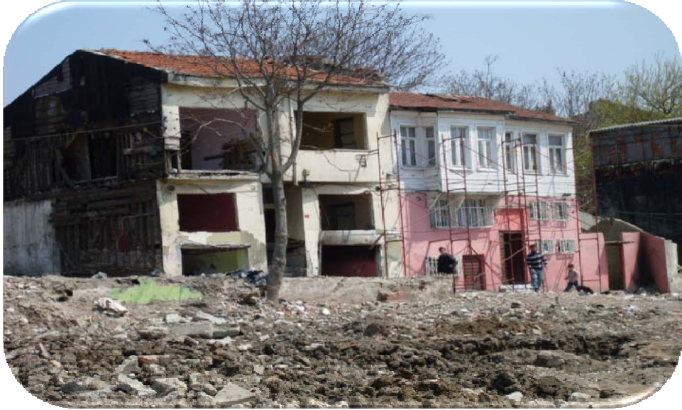
Şekil 3.9. Küçük Çeşme sokak üzerinde bulunan ve restore edilen tarihi bir yapı
