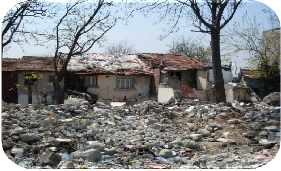
Şekil 3.3. Niyazi Misri sokak üzerinde yıkılan yapıların atıklarından bir görüntü
