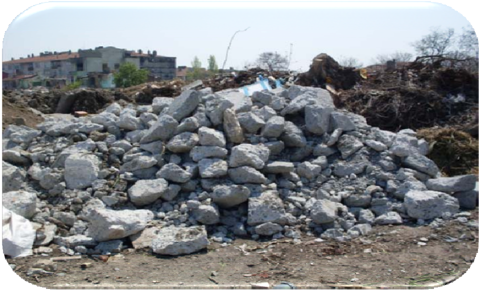
Şekil 3.14. Muhtar Muhittin Sokak yakınındaki, tamamen boşaltılmış alandaki, moloz yığını haline getirilmiş, betonarme inşaat atıkları
