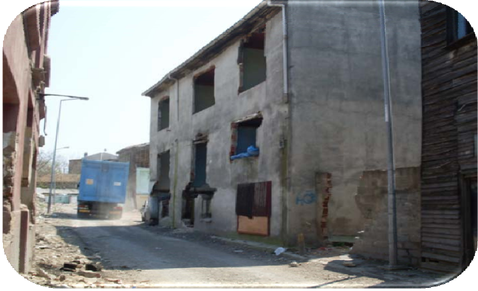
Şekil 3.13. Muhtar Muhittin sokak üzerinde, terk edilmiş metruk vaziyette, betonarme bir yapı
