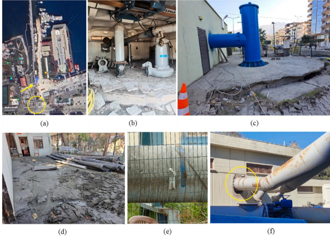
Şekil 3.14: İskenderun yağmur suyu ve atıksu pompa istasyonunda sıvılaşma nedeniyle oluşan hasar: (a) sahanın konumu (daire) ve denize uzanan boru (ok), (b) hasarlı pompalar ve tesis içindeki farklı oturma ve yükselme, (c) binanın güney tarafındaki yükselme, (d) tesis dışındaki kum kaynaması belirtileri, (e) boru desteklerinin kayması ve (f) yapının kuzey tarafındaki boruda hasar (yaklaşık PGA = 0.26 g, PGV = 45.69 cm/s) [Toprak vd., 2024b].
