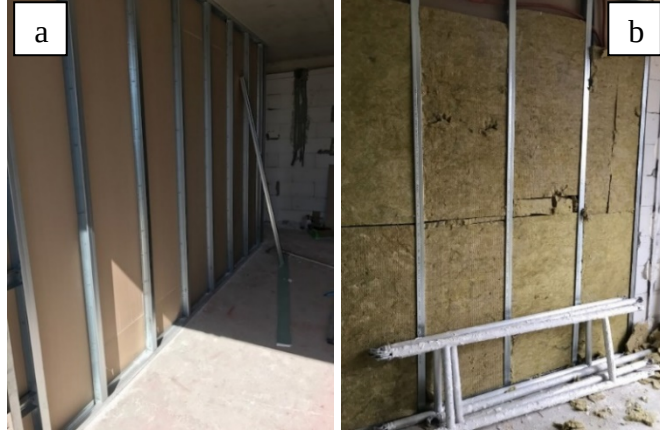
Şekil 4.6: a) Alçı levhaların konstrüksiyona montajı ve b) taş yünü yalıtım uygulaması.
