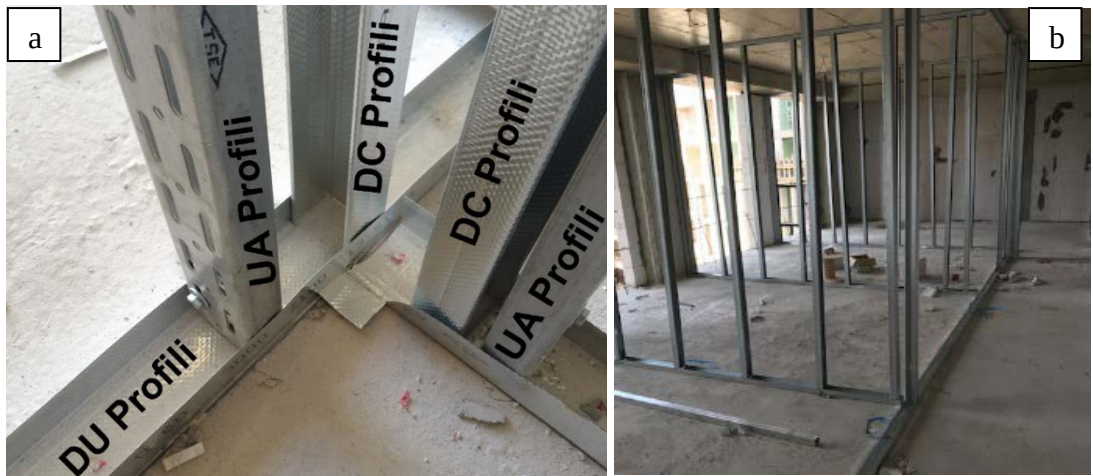
Şekil 4.5: a) Alçı levha konstrüksiyon profillerinin birleşimi ve b) tamamlanmış konstrüksiyon örneği.
