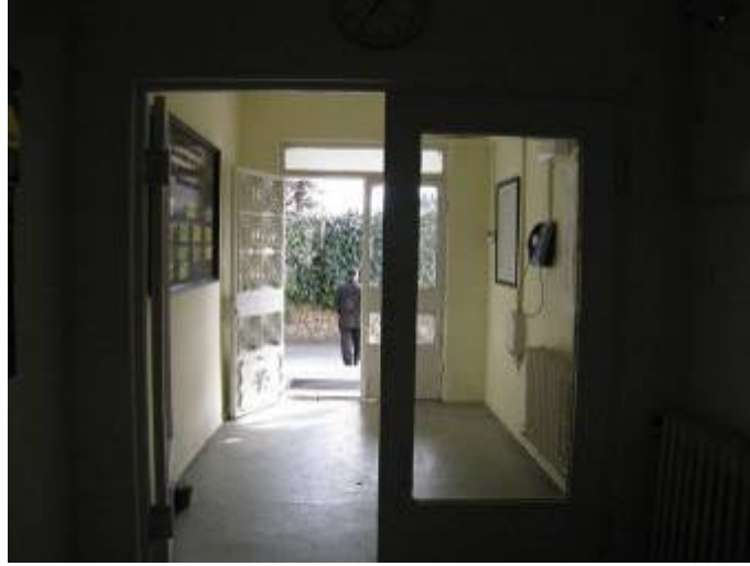
Şekil 3.71 : Sağlık Ocağının giriş kapısı ve giriş holü
