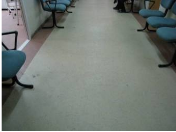
Şekil 3.89 : PVC döşeme kaplama
