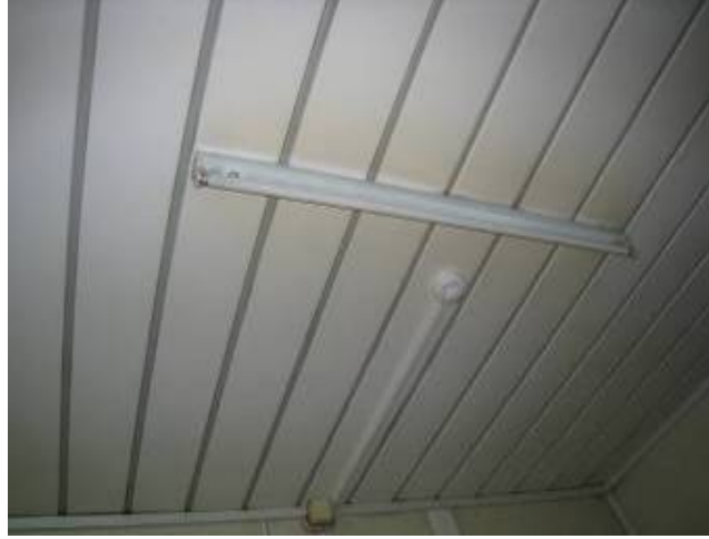
Şekil 3.96 : Çalışmayan flüoresan lambalardan biri
