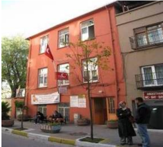
Şekil 3.38 : Sinanpaşa Sağlık Ocağı- Beşiktaş
