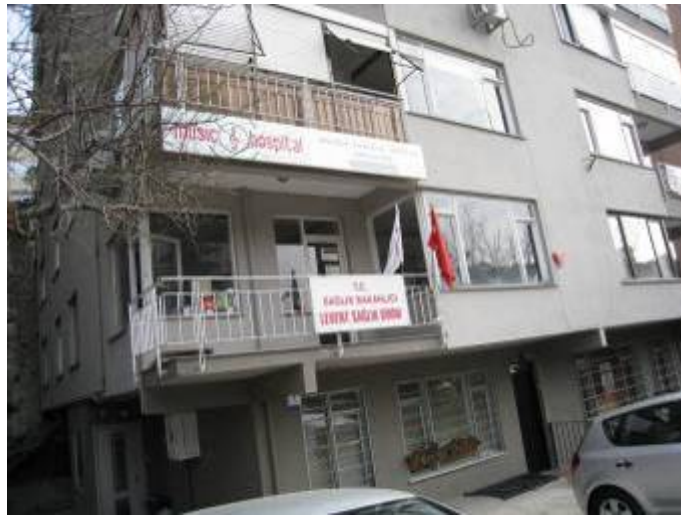
Şekil 3.72 : Levent Sağlık Ocağı – Beşiktaş
