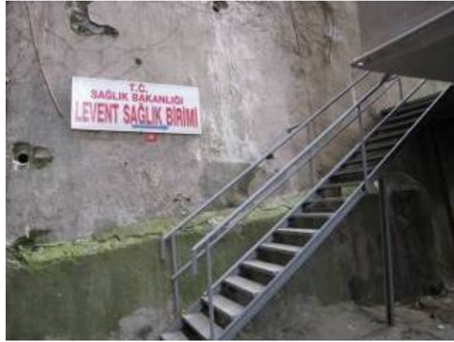
Şekil 3.74 : Sağlık ocağına çıkan merdiven
