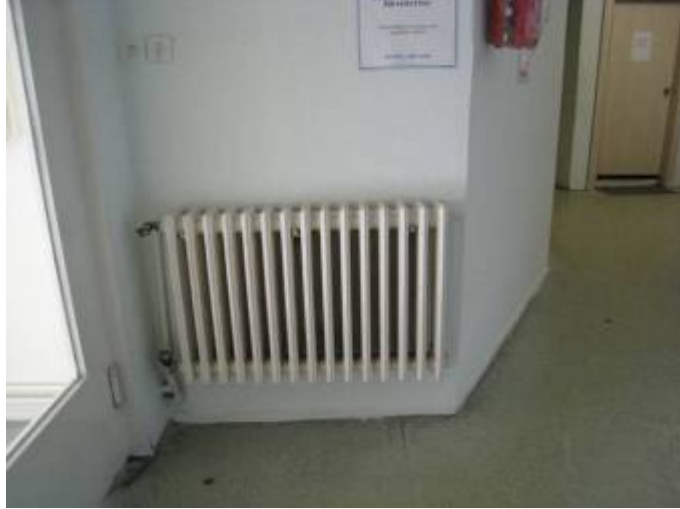
Şekil 3.69 : Giriş holündeki döküm radyatör
