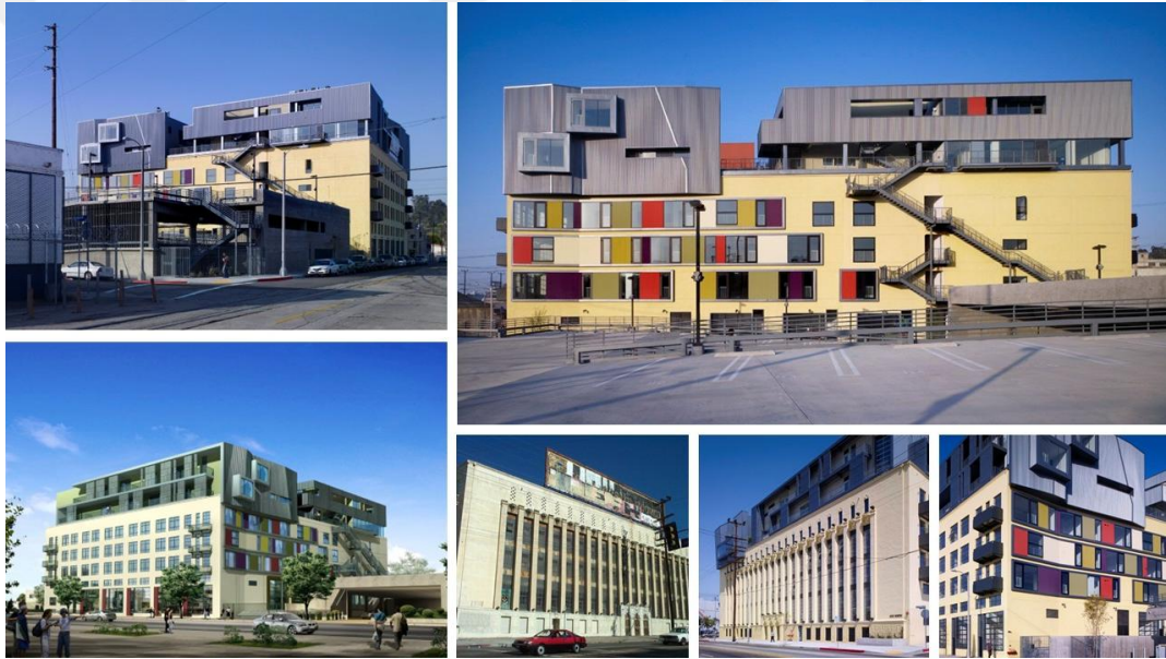
Şekil 3.13: Brooks + Scarpa Architects tarafından tasarlanan ve iki kat çatı katı loftu eklenerek endüstriyel binadan dönüştürülen Fuller Lofts (eski işlev: beton endüstri binası (depo), yeni işlev: karma kullanımlı ticari konut, Los Angeles, 2010) [Web 28, 2025].
