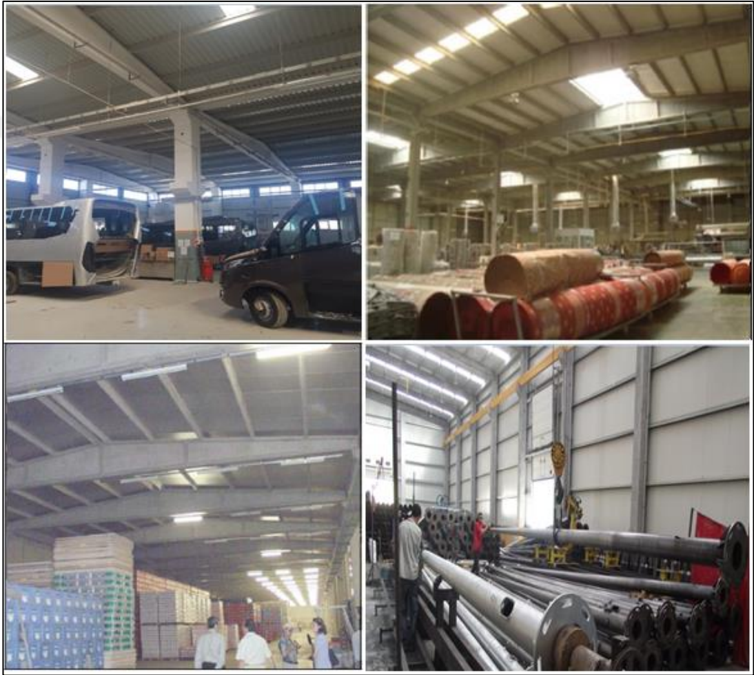
Şekil 2.6: Aktif üretim yapılan tesislerde tercih edilen tek katlı prefabrik yapı örnekleri.
