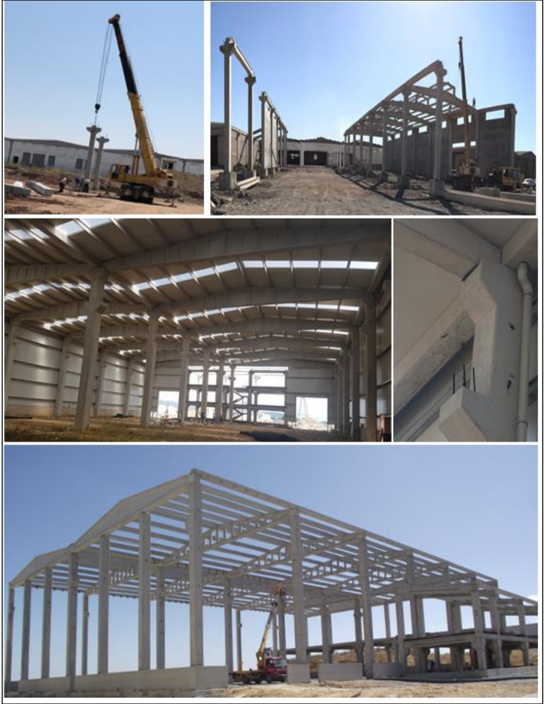
Şekil 2.5: Yapılan saha çalışmalarında elde edilen inşa aşamasındaki yapı örnekleri.
