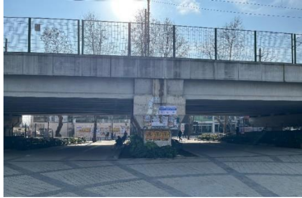
Şekil 5.44: Meydanın köprü altında kalan geçiş alanları.
