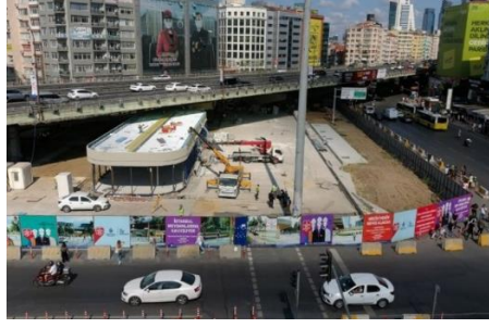
Şekil 5.16: Mecidiyeköy Meydanı yenileme çalışmaları [Web 90].
