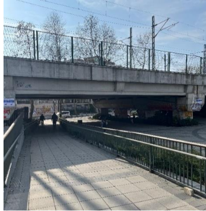
Şekil 5.42: Cadde seviyesinden zemine inen rampa.
