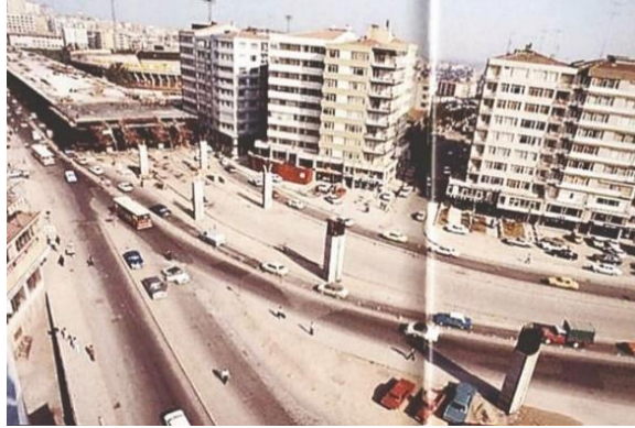
Şekil 5.13: 1974 yılından Mecidiyeköy Viyadüğü'nün yapım çalışmaları [Web 87].
