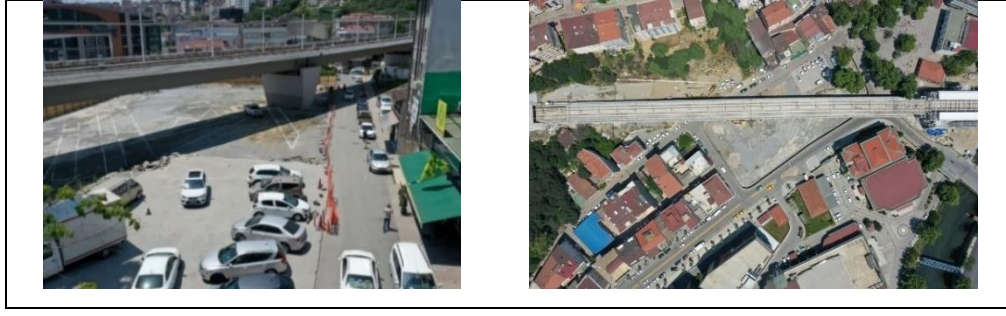
Şekil 5.4: Kağıthane Meydanı'nın bulunduğu alandaki inşaat çalışmaları [Web 83].
