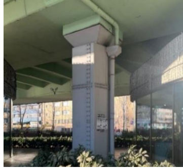
Şekil 5.28: Alanda bulunan kolonlar ve yağmur suyu boruları.
