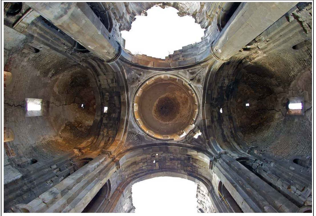
Şekil 5.8: Kemerlerin taşıyıcılığını koruması.
