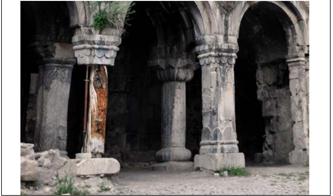
Şekil 5.9: Sonradan eklenen ağaç destek.
