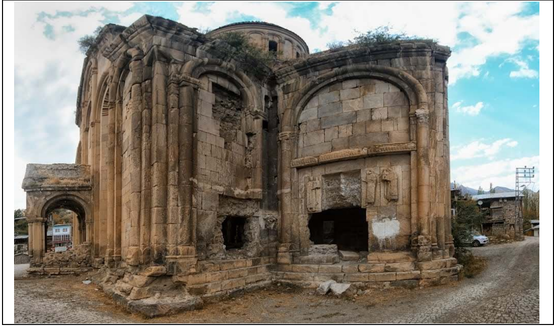
Şekil 5.10: İnsanlar tarafından duvarlarda açılan oyuklar ve delikler.
