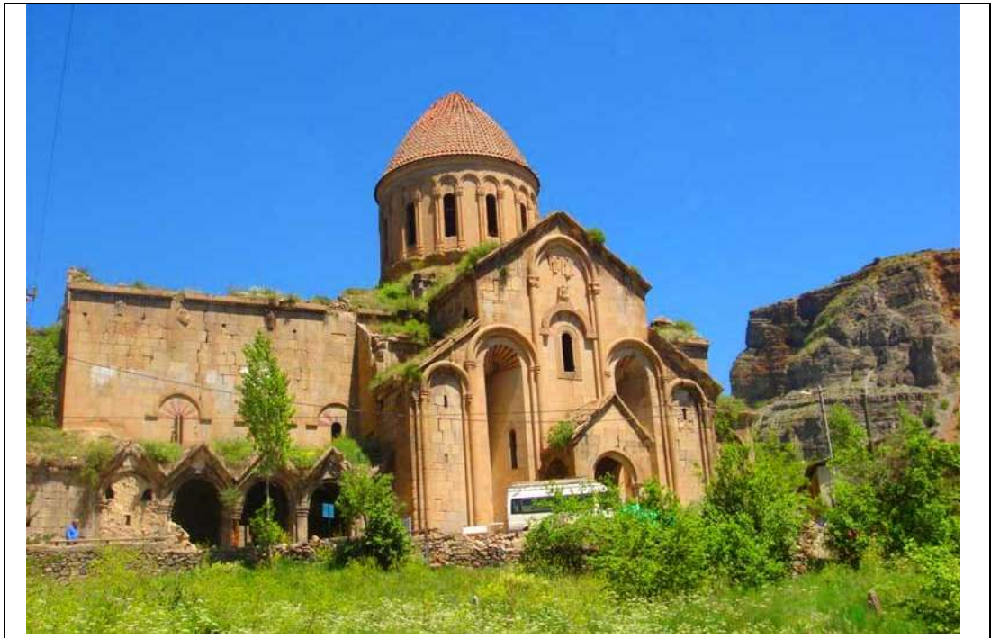
Şekil 5.11: Kilisenin duvarlarının görünüşü.
