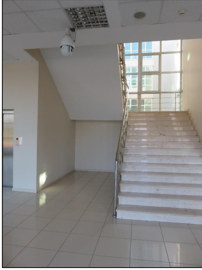
Şekil 4.60: Bilgisayar Mühendisliği Bölümü ve Bilişim Teknolojileri Enstitüsü binası iç merdiven ve pencereleri.
