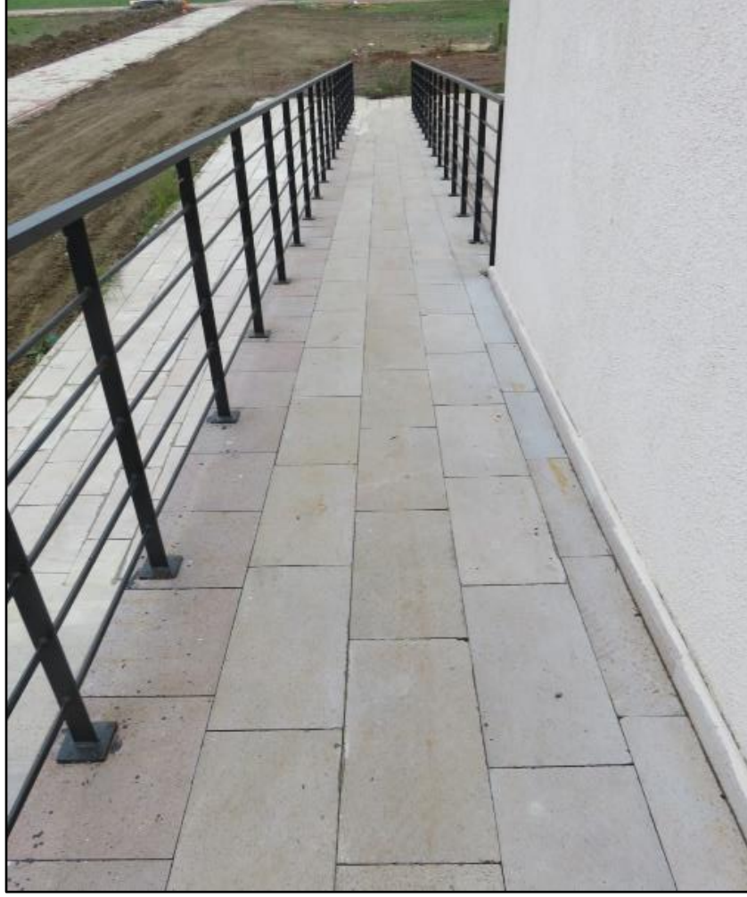
Şekil 4.34: Katı Atık Laboratuvarı binası giriş rampası.
