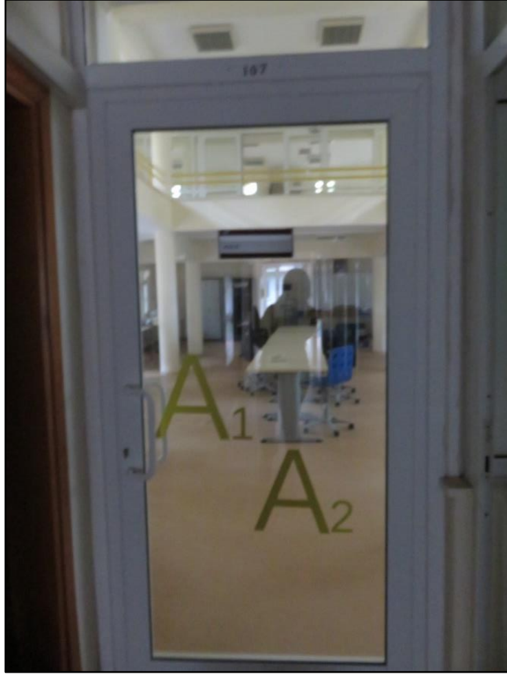
Şekil 4.48: Mimarlık Bölümü bina iç kapıları ve işaretlemeleri.
