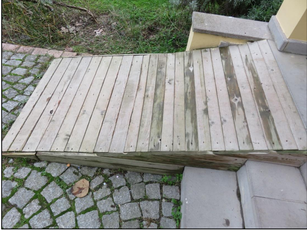
Şekil 4.23: Anaokulu binası giriş rampası.
