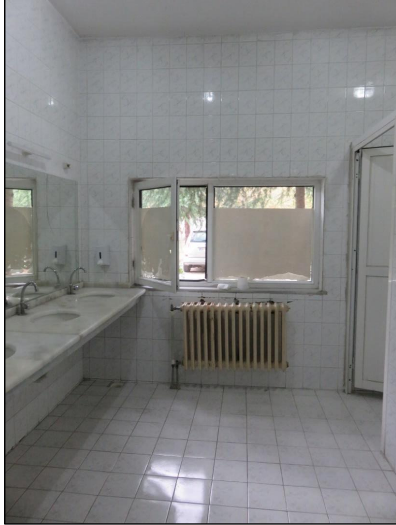
řekil 4.43: Derslikler binası tuvaleti.
