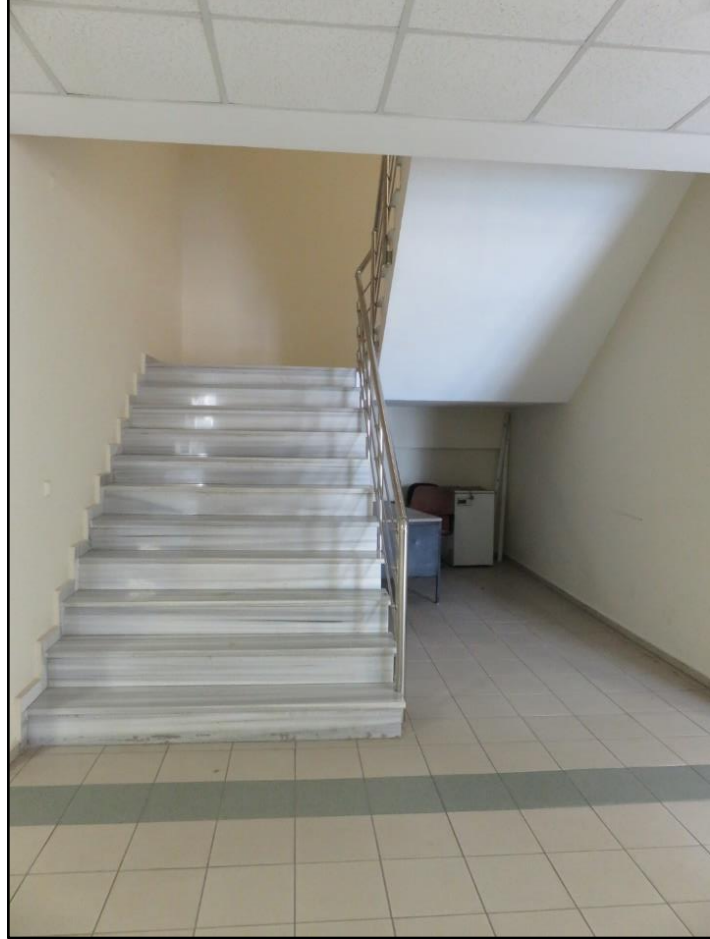
Şekil 4.62: Kimya Mühendisliği binası merdiveni ve merdiven altı.
