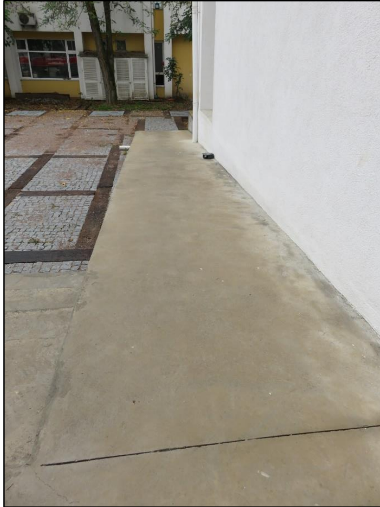
Şekil 4.18: Mimarlık Fakültesi bina giriş rampası.
