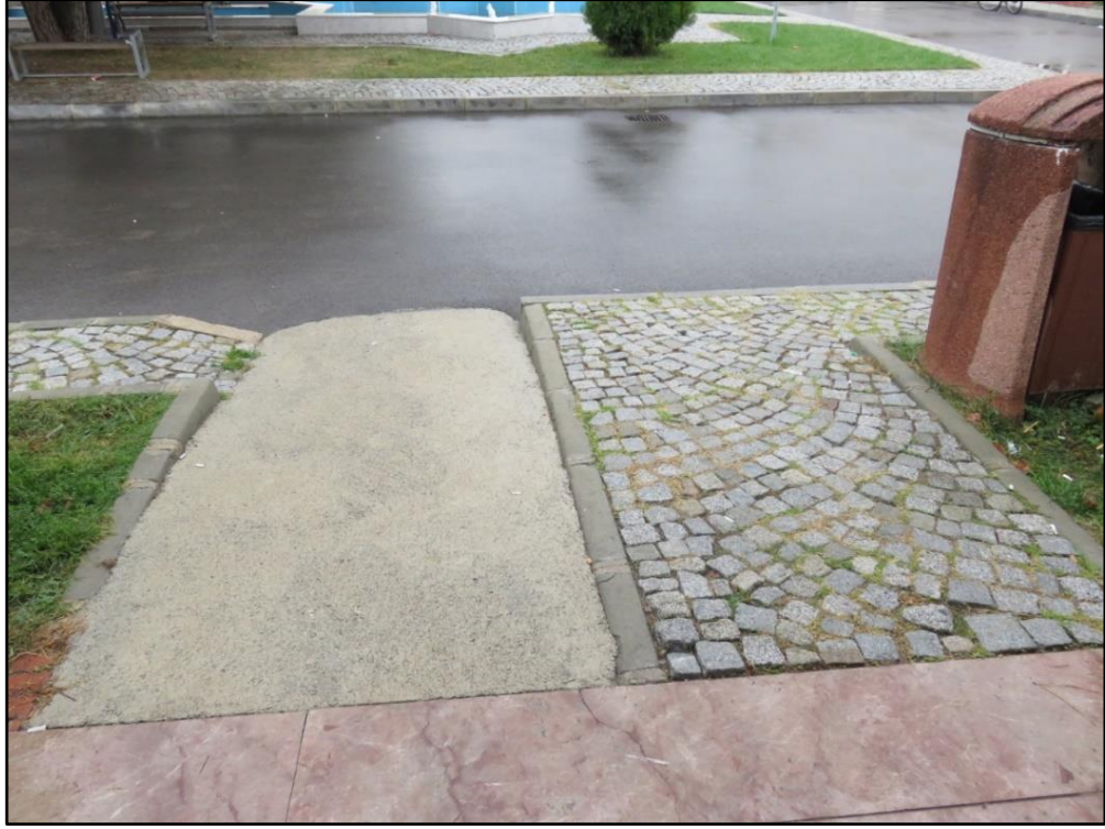
Şekil 4.3: A, B, C, D blok bina giriş rampası ve kaldırım.
