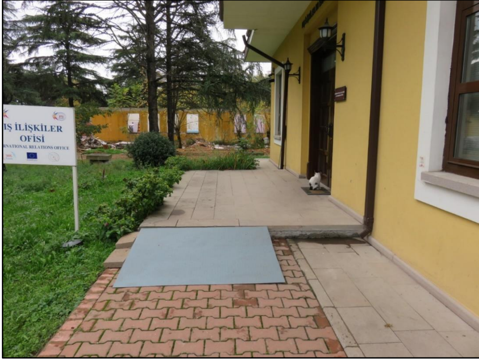
Şekil 4.26: Dış İlişkiler Ofisi bina giriş rampası ve kaldırımı.
