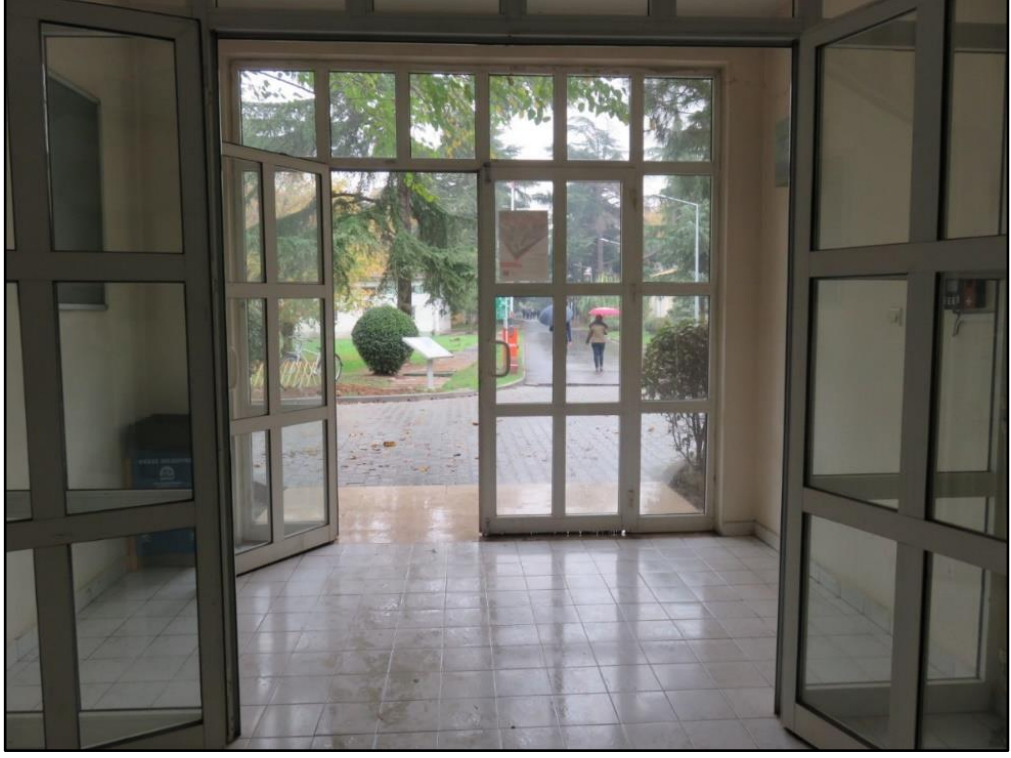
Şekil 4.9: Derslikler binası giriş kapısı.
