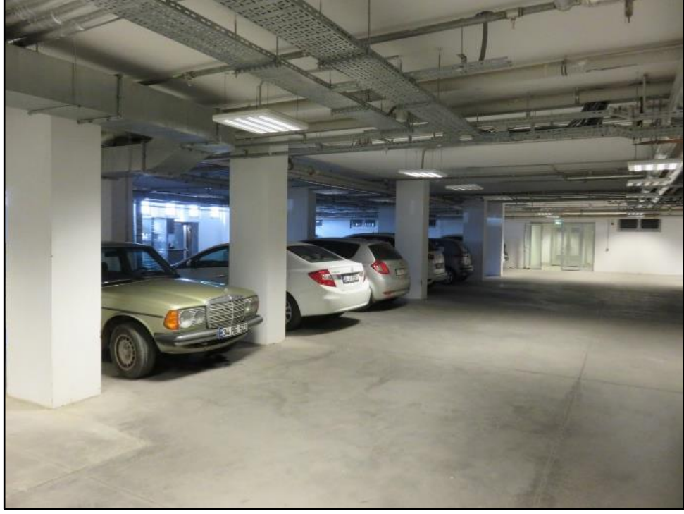
Şekil 4.33: Kimya Bölümü, Çevre Mühendisliği ve Temel Bilimler Fakültesi binasının kapalı otopark alanı.
