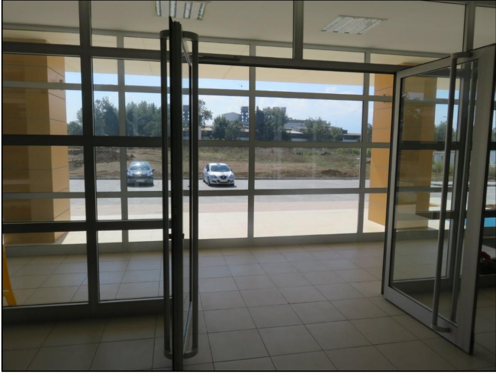
Şekil 4.32: Kapalı yüzme havuzu bina girişi ve büyük cam yüzeyler.
