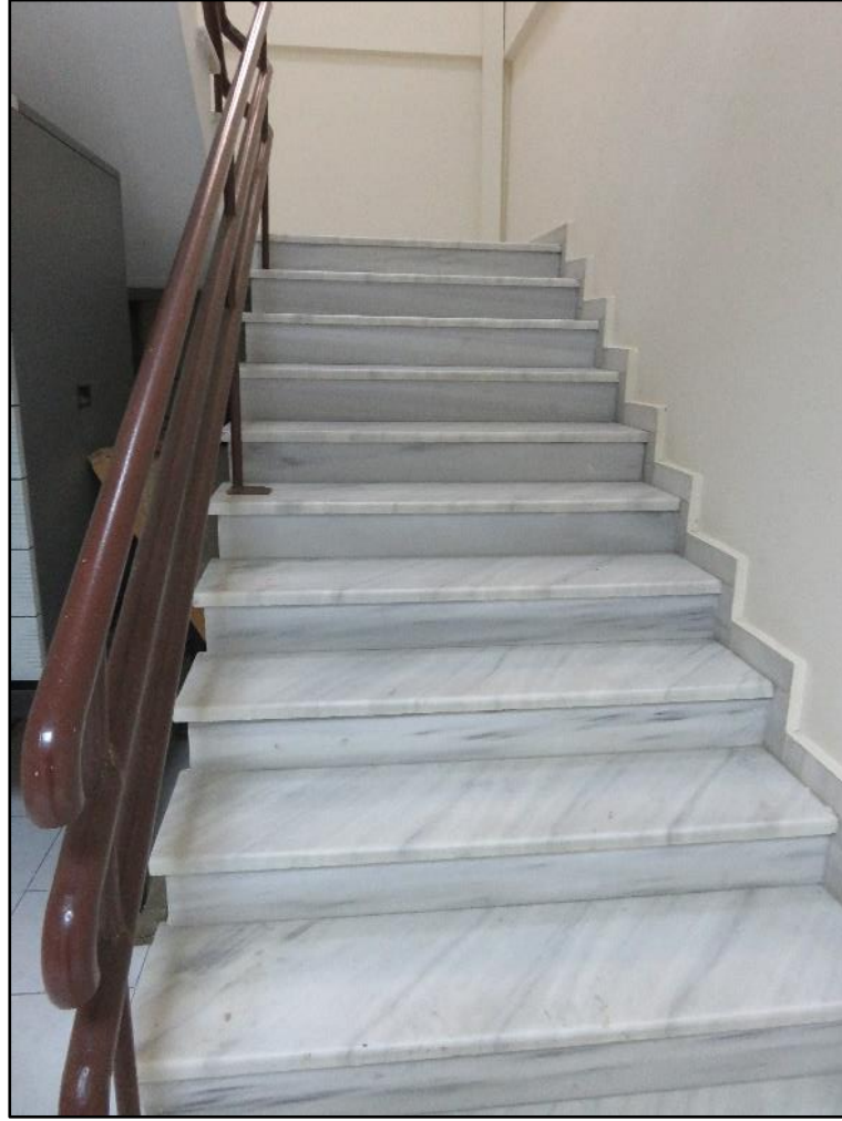
Şekil 4.49: Laboratuvar binası iç merdivenleri.
