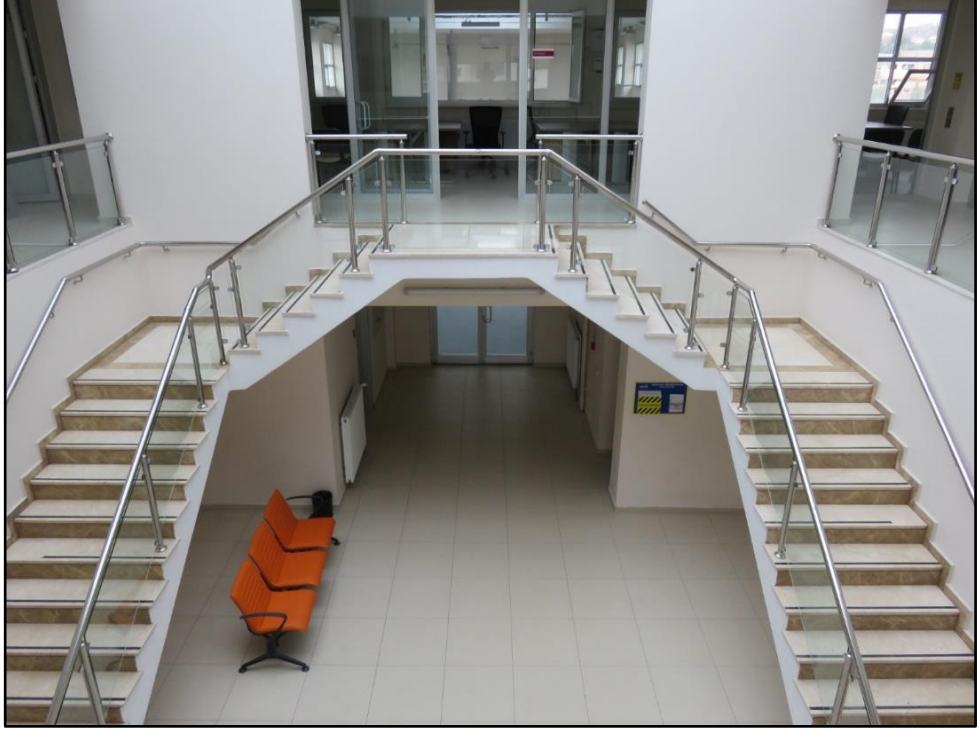
Şekil 4.67: Katı Atık Laboratuvarı binası iç merdiveni ve dolaşım alanları.
