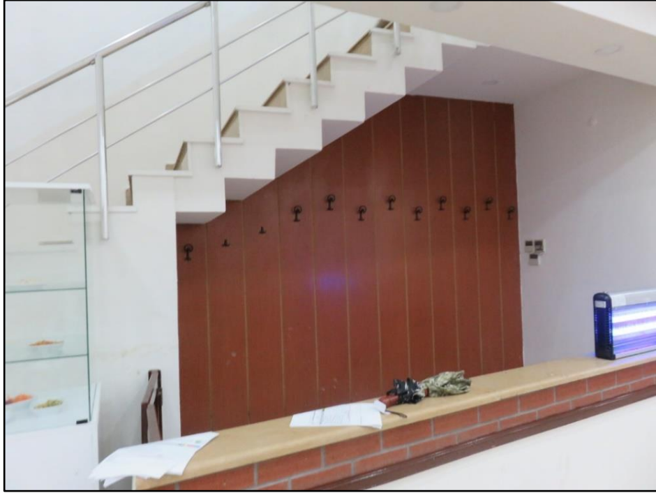
Şekil 4.47: Öğrenci yemekhanesi binası merdiven altı.
