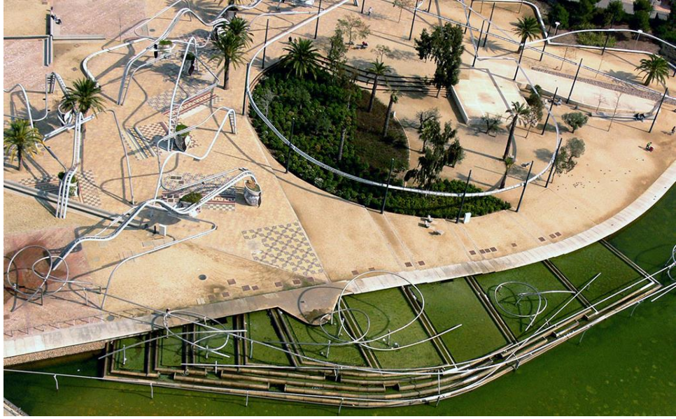
Şekil 4.33: Diagonal Mar Park - Park boyunca devam eden borular.
