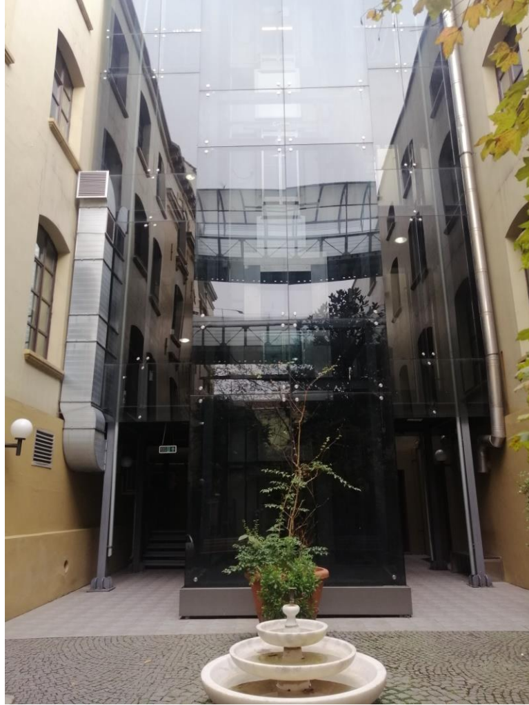
Şekil 4.59: Bloklar arasına eklenen çelik taşıyıcılı cam köprü, 2021.
