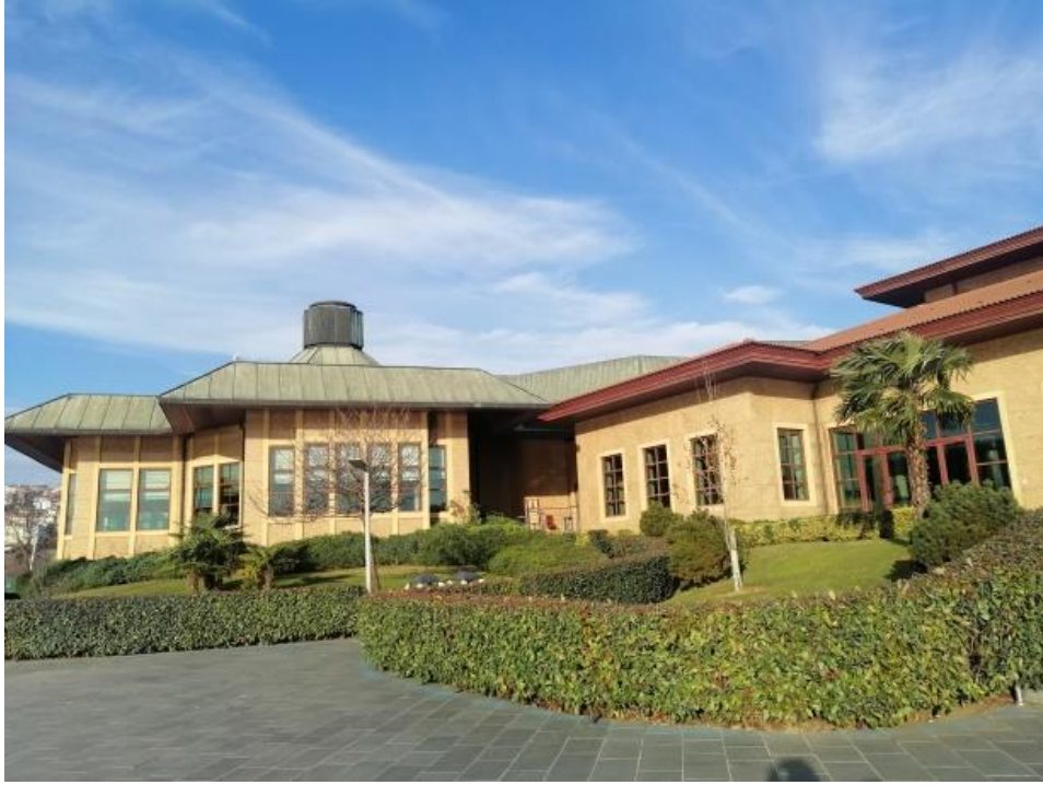
Şekil 4.121: Yıkılıp yenilenen yapı, 2021.
