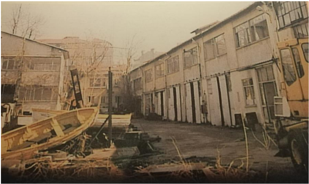
Şekil 4.69: Hasköy Tershanesi C Binası.
