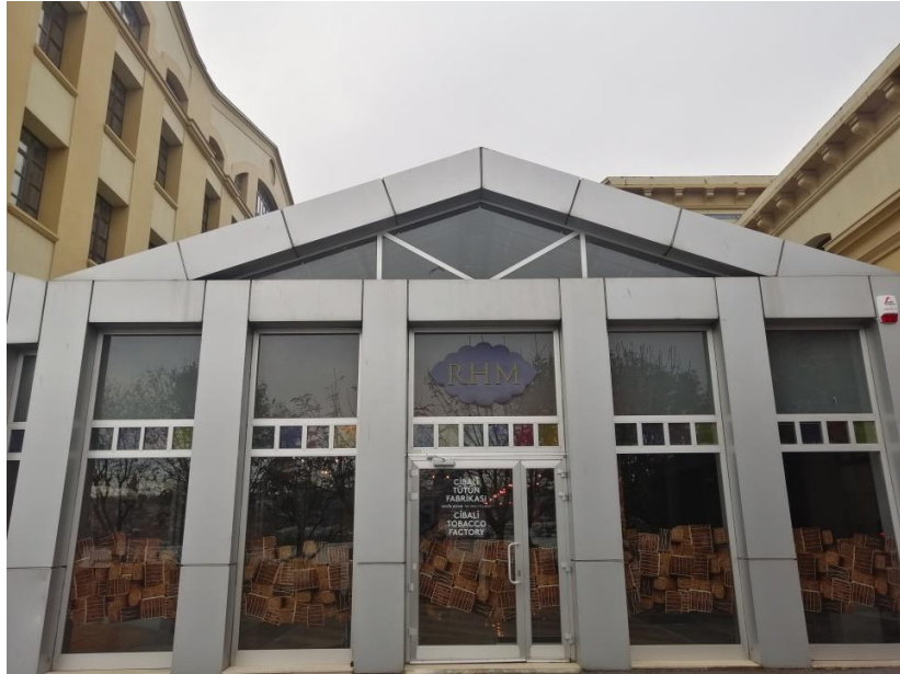
Şekil 4.51: B-C Blok arası geçit ve Rezzan Has Müzesi girişi, 2021.
