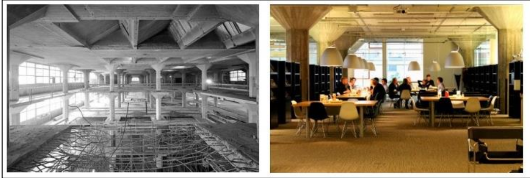
Şekil 2.17: a) Las Palmas, Rotterdam yapısı taşıyıcı mantar kolonlar eski hali, b) Rotterdam yapısı taşıyıcı mantar kolonlar yeni hali, Hollanda.
