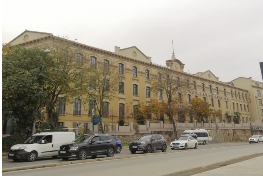
Şekil 4.50: Cibali Tütün Fabrikası özgüne dönüşen cephe, 2021.
