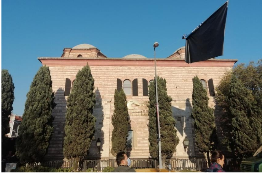
Şekil 4.73: Lengerhane Binasi Hasköy Caddesi cephesi, 2021.
