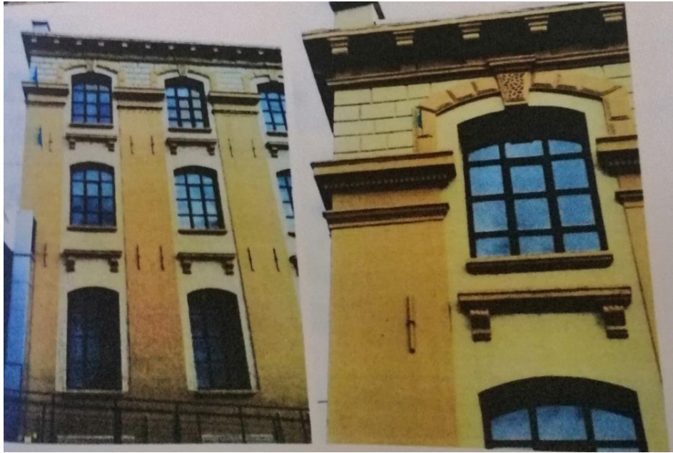
Şekil 4.47: Cibali Tütün Fabrikası basit onarım sonrası.
