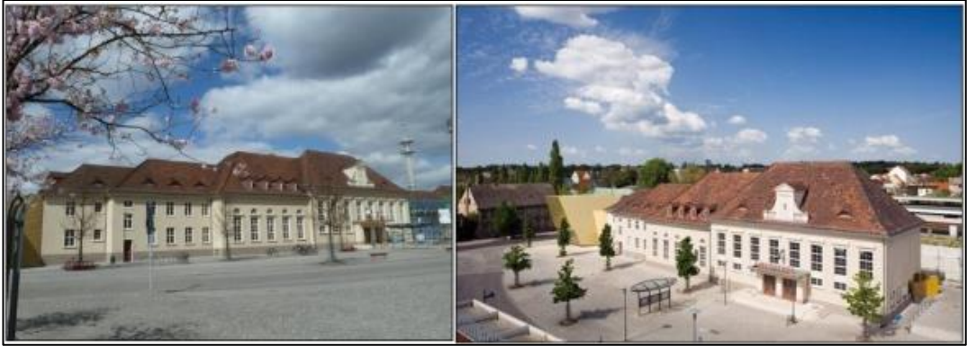
Şekil 2.12: a) Luckenwalde Tren İstasyonu işlev değişimi sonrası cephesi, b) Luckenwalde Tren İstasyonu işlev değişimi sonrası cephesi.
