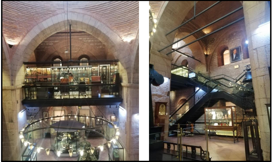
Şekil 4.75: Yenileme sonrası eklenen çelik elemanlar ve yapıyla ilişkisi, 2021.
