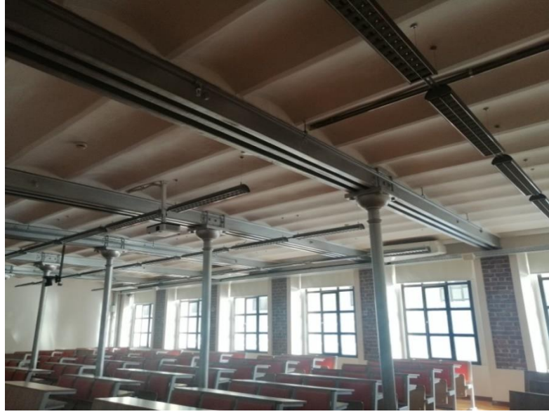
Şekil 4.61: Özgün volta döşeme ve teknik elemanlar, 2021.
