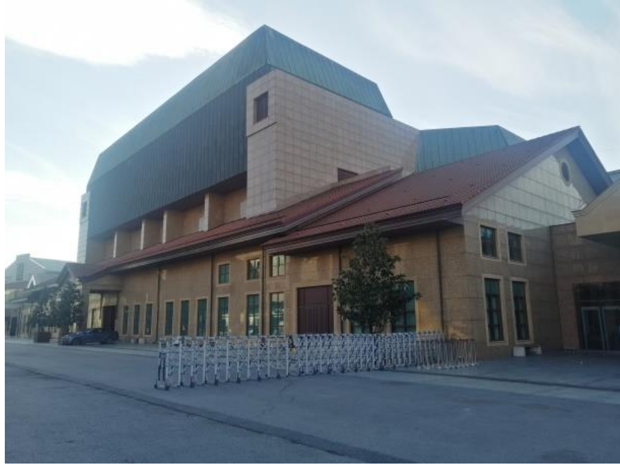
Şekil 4.122: Yıkılıp yenilenen yapı, 2021.
