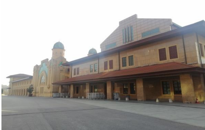
Şekil 4.116: Yıkılıp yenilenen yapı, 2021.
