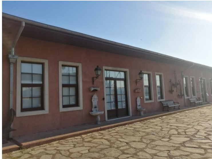
Şekil 4.82: Hasköy Tershanesi yenileme sonrası E Binası, 2021.
