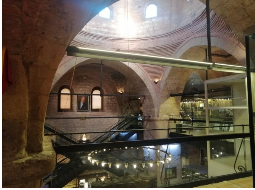
Şekil 4.74: Yenileme sonrası eklenen çelik asma kat, 2021.
