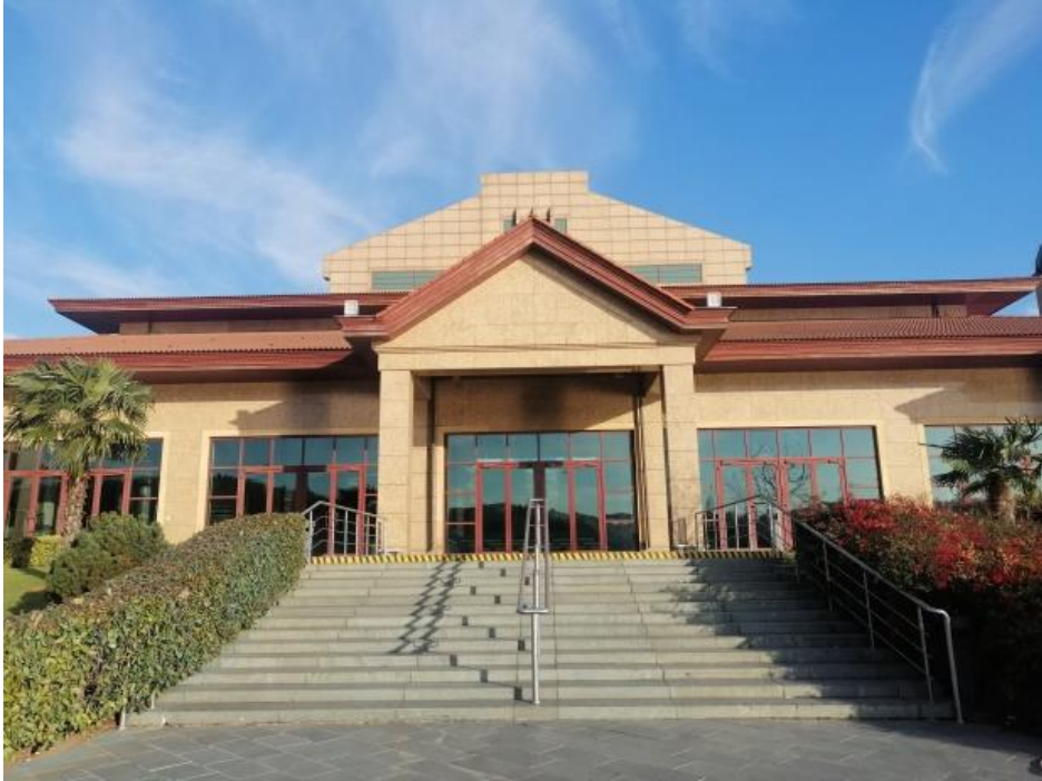
Şekil 4.114: Yıkılıp yenilenen yapı, 2021.
