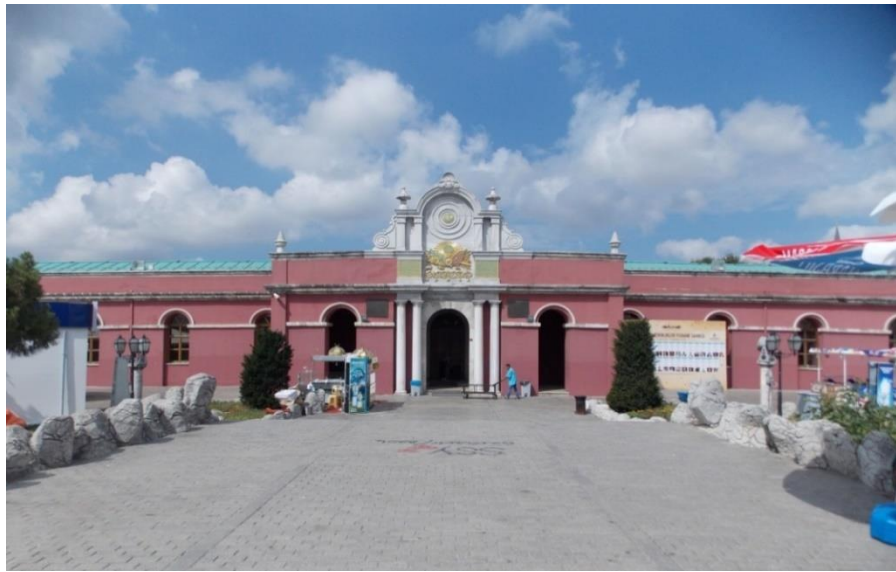
Şekil 4.15: Ana giriş kapısı(Cümle Kapısı) ve Kuzeydoğu cephesi.
