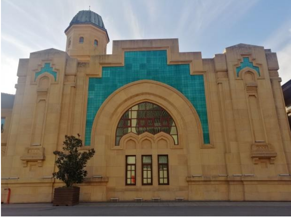
Şekil 4.113: Buzhane binası cephesi, 2021.
