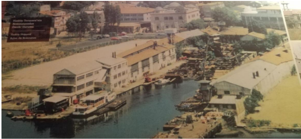
Şekil 4.67: Lengerhane Binası ve Hasköy Tershanesi.
