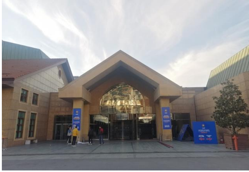
Şekil 4.115: Yıkılıp yenilenen yapı, 2021.
