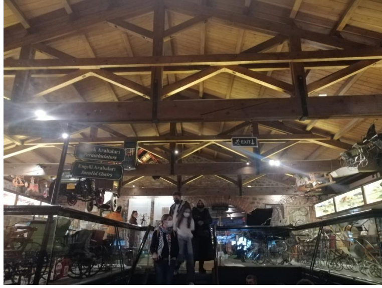
Şekil 4.79: Hasköy Tershanesi yenileme sonrası B Binası, 2021.
