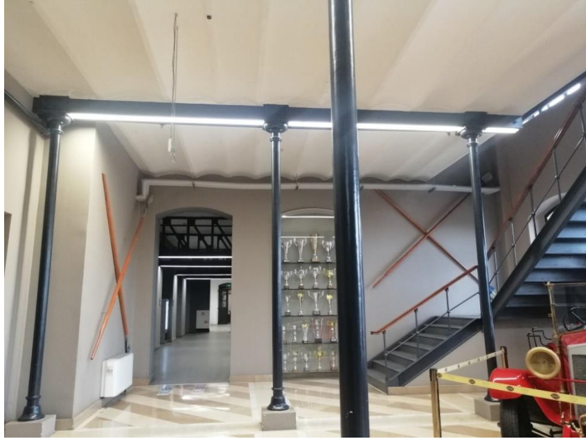
Şekil 4.60: Eklenen elik taşıyıcı elemanlar ve merdiven, 2021.
