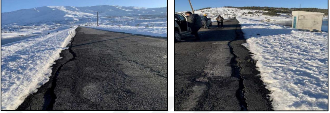
Şekil 6. 131: Sürgü Barajı, Malatya.
