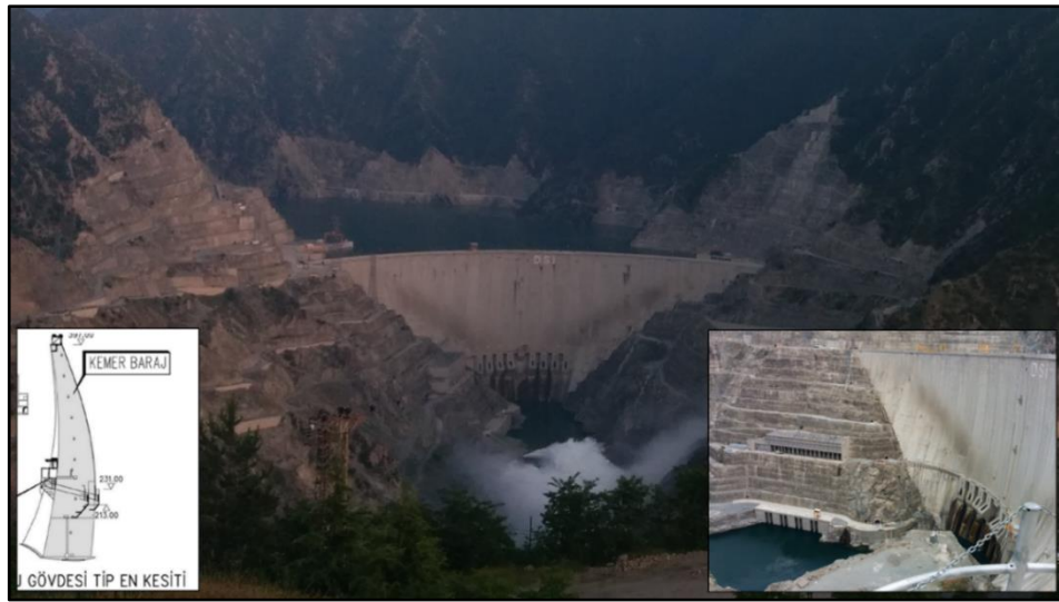
Şekil 2. 27: Çift Eğrilikli İnce Beton Kemer Deriner Barajı, Artvin.
