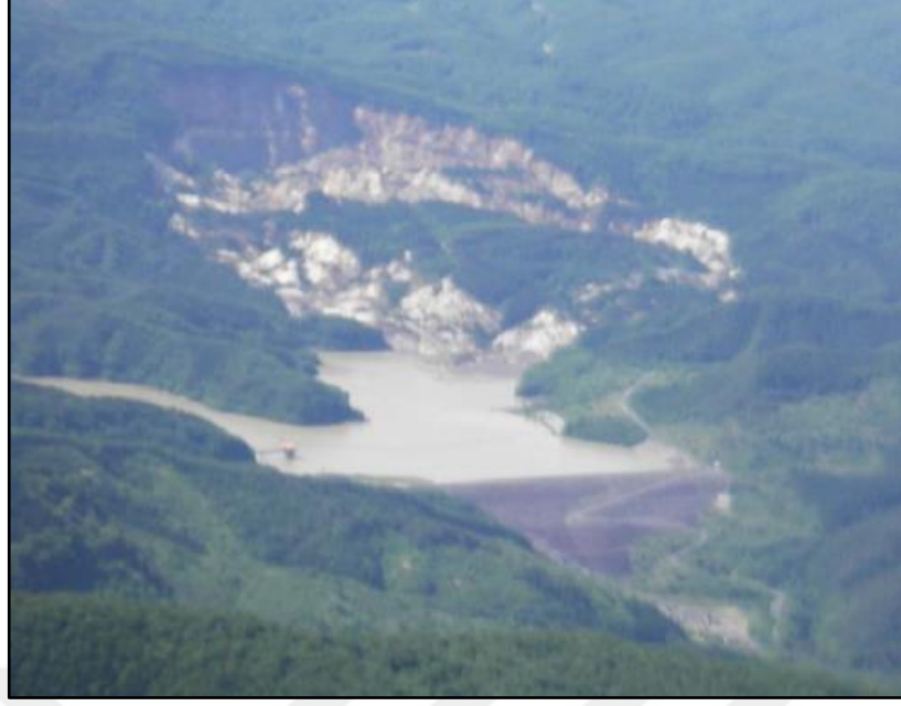
Şekil 4. 22: Aratozawa Barajı büyük rezervuar heyelanı.
