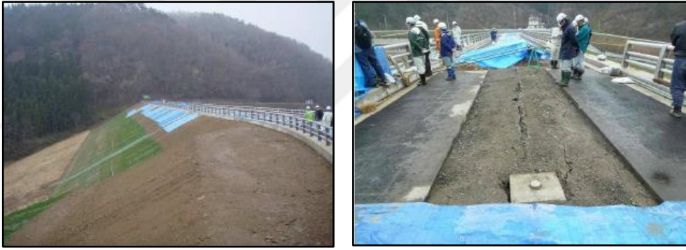
Şekil 4. 29: Koromokawa Barajı hasar gören kısımların kapatılması.
