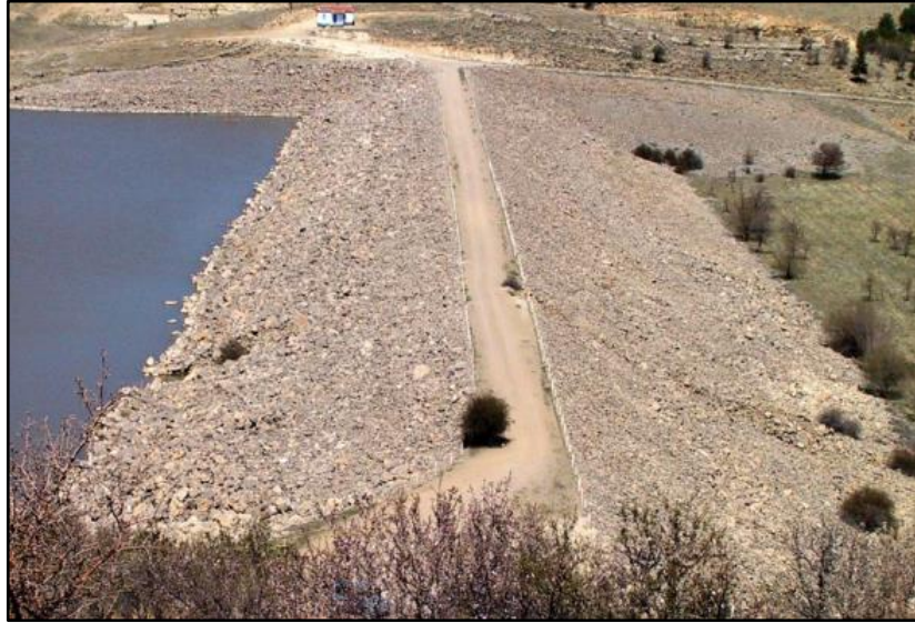
Şekil 2. 7: Homojen toprak dolgu May Barajı, Konya.
