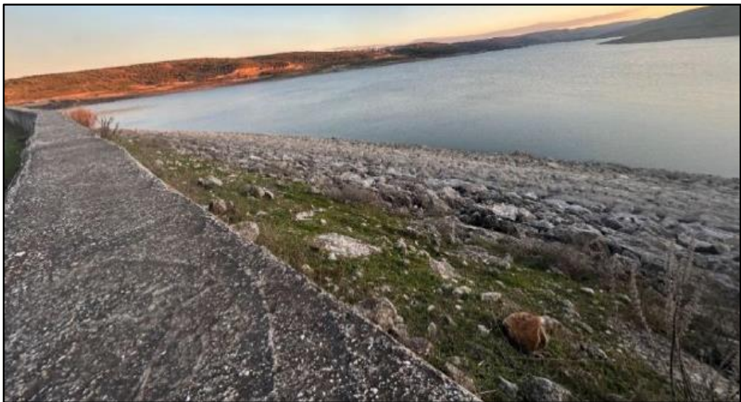
Şekil 6. 86: Yarseli Barajı memba şevi görünümü.
