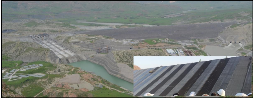
Şekil 2. 17: Ön yüzü beton kaplı kaya dolgu Ilısu Barajı, Mardin.
