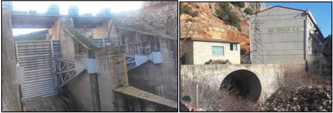
Şekil 6. 141: Kartalkaya Barajı, dolusavak, dipsavak ve santral binası, Maraş.
