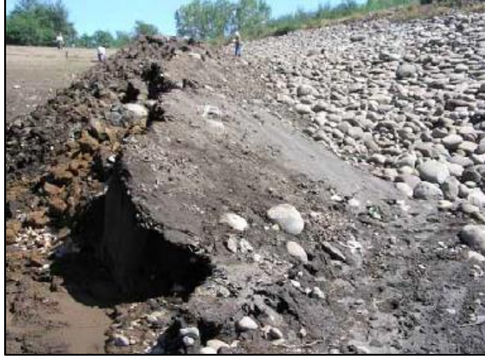
Şekil 4. 21: Memba topuğunda kabarma Şili Depremi Mw 8.8.
