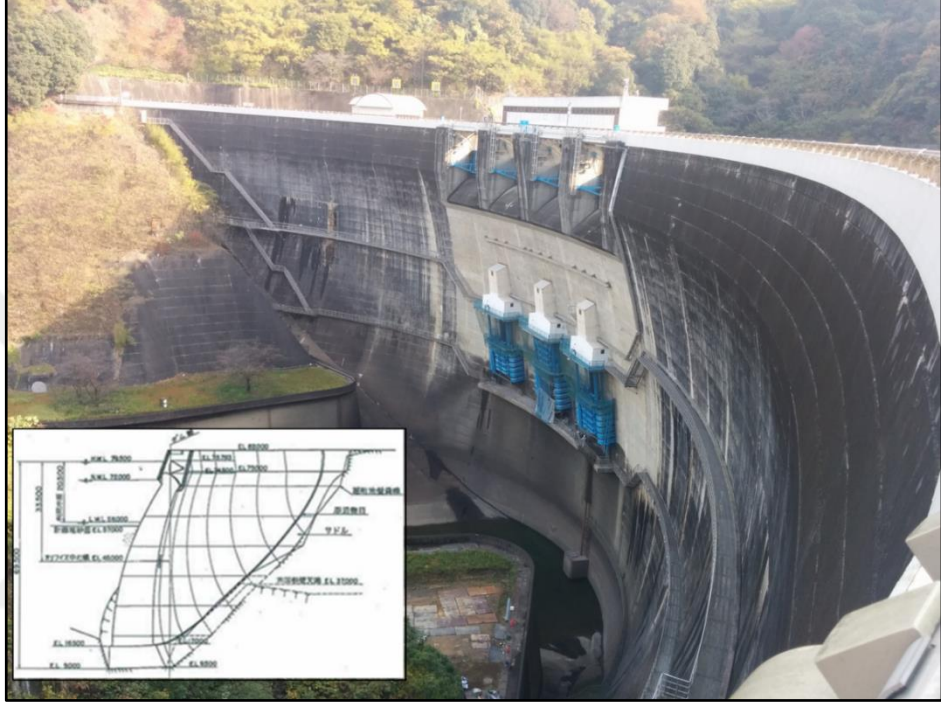
Şekil 2. 28: Çift eğrilikli ince beton kemer Amagase Barajı, Kyoto.
