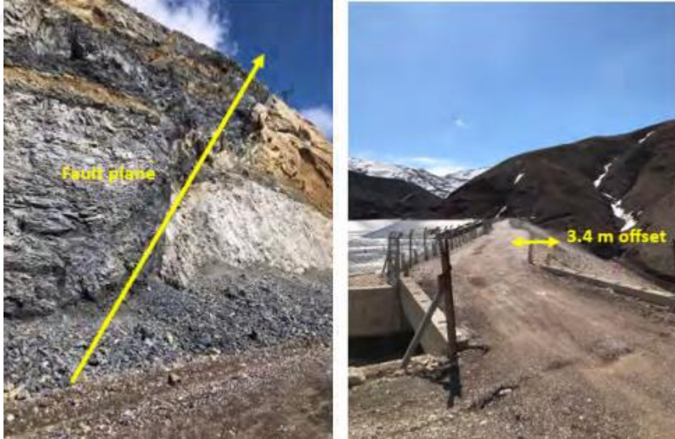
Şekil 6. 70: Fay düzlemi ve Erkenek Göleti kreti A:3.4 m.
