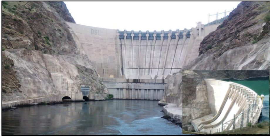
Şekil 2. 24: Beton ağırlık kemer Karakaya Barajı, Diyarbakır.
