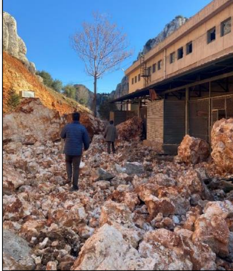
Şekil 6. 111: Santral binası çevresi ve kaya düşmeleri.
