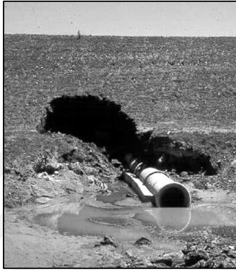
Şekil 4. 27: Dipsavak kondüvisi etrafında borulanma.
