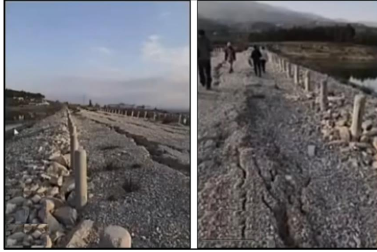
Şekil 6. 29: Krette memba yönlü yanal kalıcı hareket 1,25 m ve ~1 m oturma.
