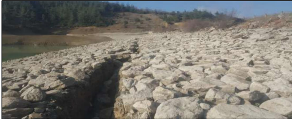
Şekil 6. 17: Arıklıkış Göleti memba şevinde kalıcı yanal deplasman.
