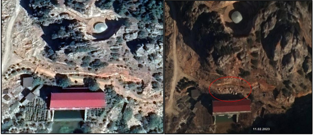
Şekil 6. 114: Santral binası depremler öncesi ve sonrası uydu görüntüsü.
