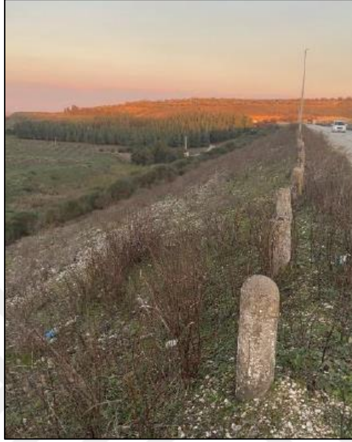
Şekil 6. 87: Yarseli Barajı mansap sevi görünümü.
