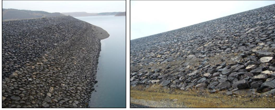
Şekil 2. 13: Atatürk Barajı memba ve mansap koruyucu riprap kaplaması.
