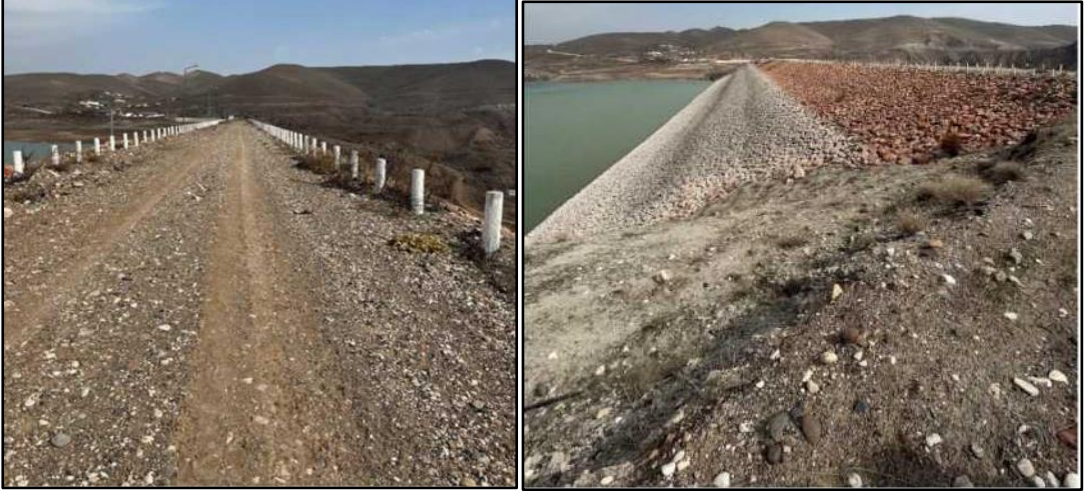
Şekil 6. 138: Boztepe Recai Kutan Barajı, Malatya.
