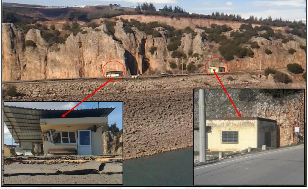
Şekil 6. 112: Farklı zemin koşullarındaki iki aynı tip yapının davranışı.
