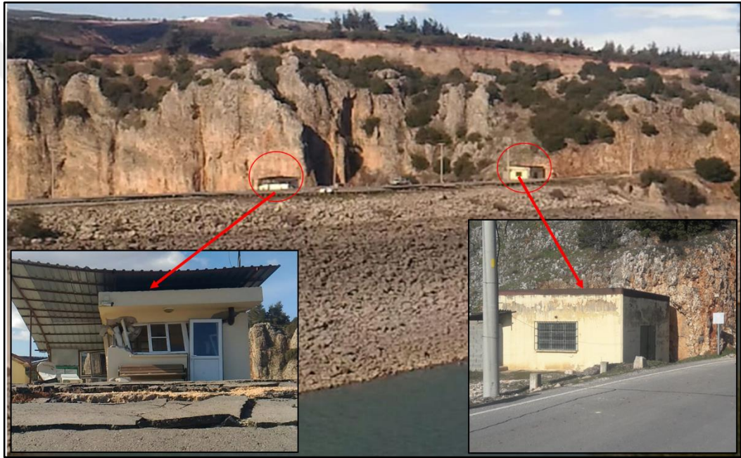
Şekil 7. 5: Yapı-zemin etkileşimi farklı zemin koşullarındaki iki aynı tip yapının davranışı, Kartalkaya Barajı, Pazarcık, Kahramanmaraş.
