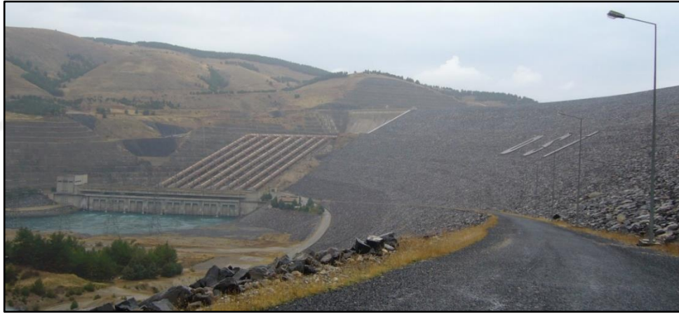
Şekil 2. 11: Kil çekirdek kaya dolgu Atatürk Barajı, Şanlıurfa.
