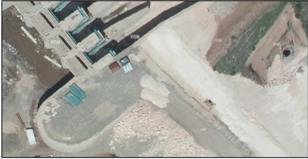
Şekil 6. 120: Çetintepe Barajı depremler sonrası krette oluşan çatlaklar ve düşen dolusavak köprüsü kirişleri.
