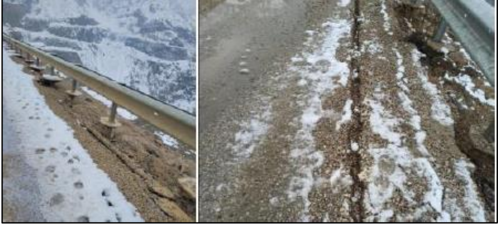
Şekil 6. 134: Kandil Barajı, Kahramanmaraş.
