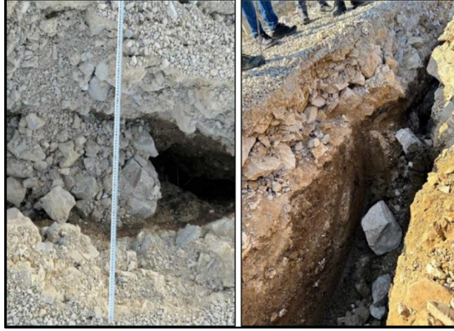
Şekil 6. 32: Krette memba yönlü yanal kalıcı hareket G:1,1 m D: 2,2 m.
