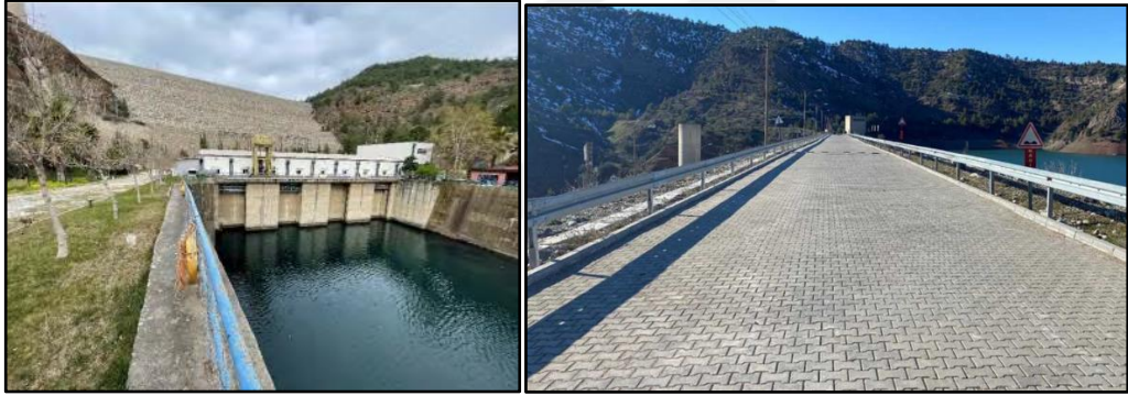
Şekil 6. 145: Menzelet Barajı, Kahramanmaraş.
