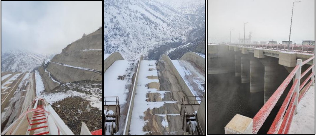
Şekil 6. 144: Kandil Barajı Dolusavak Yapısı, Kahramanmaraş.
