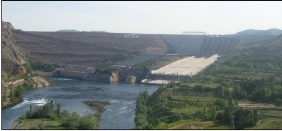
Şekil 2. 14: Kil çekirdek kaya dolgu Keban Barajı mansap görünümü, Elazığ.
