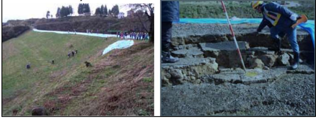
Şekil 4. 28: Asagawara Barajı hasar gören kısımların kapatılması.
