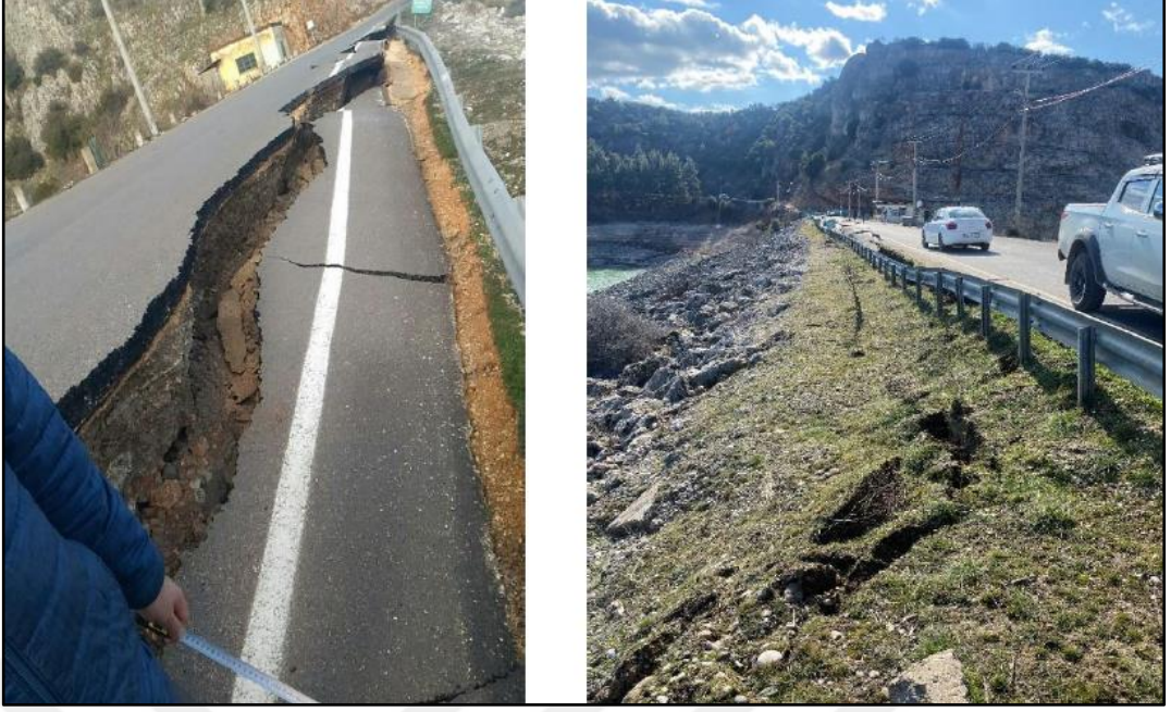
Şekil 6. 104: Kret memba şev birleşimindeki memba yönlü hareket.
