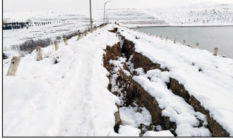
Şekil 6. 56: Baraj kreti boyunca aksa paralel oluşan memba yönlü yanal hareket G:1|~ 2.5 m, D:1.5~ 4 m.
