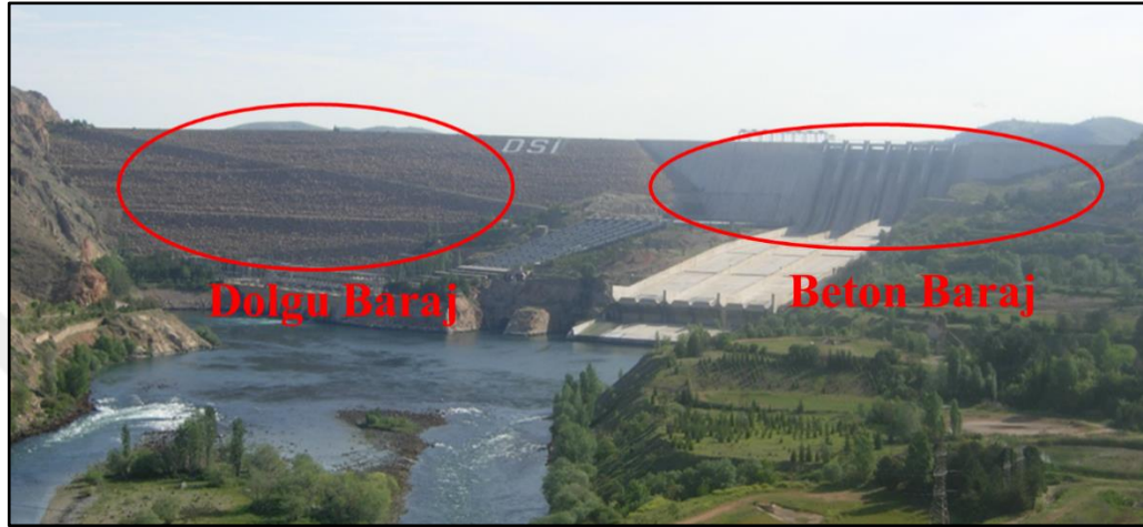
Şekil 2. 29: Kil çekirdek kaya dolgu ve beton ağırlık Keban Barajı, Elazığ.
