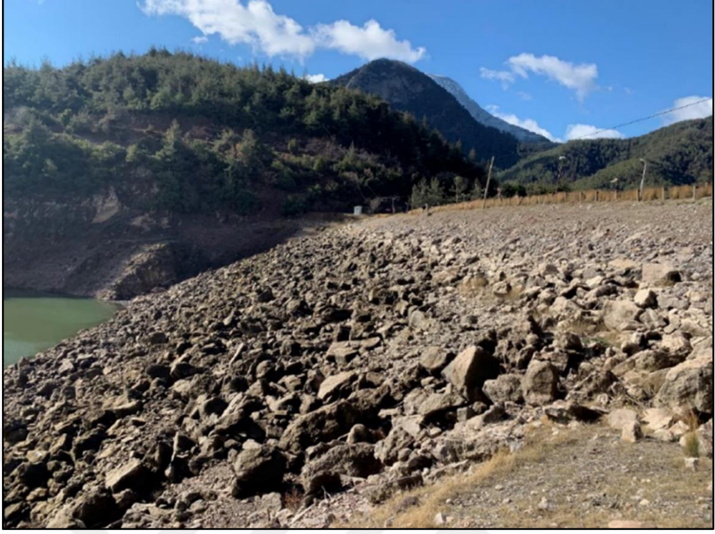
Şekil 6. 77: Kalecik Barajı memba şevi görünümü.
