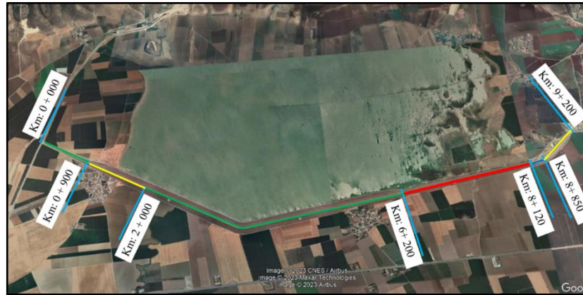
Şekil 6. 40: Baraj kreti hasarlı bölgeler gösterimi.
