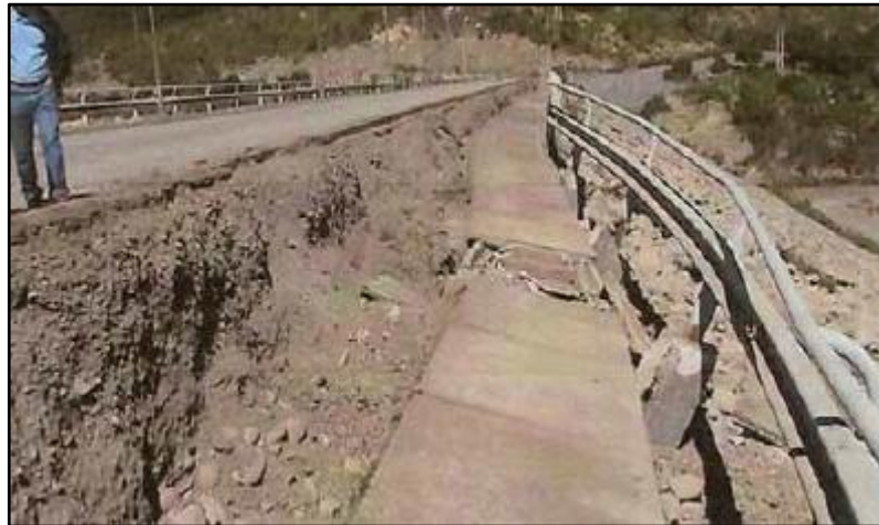
Şekil 4. 11: Mansap şevi kret birleşiminde yanal kayma.
