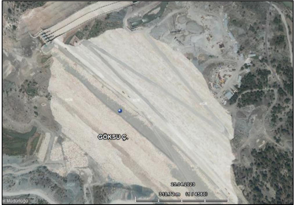
Şekil 6. 118: Çetintepe Barajı depremler sonrası uydu görünümü.
