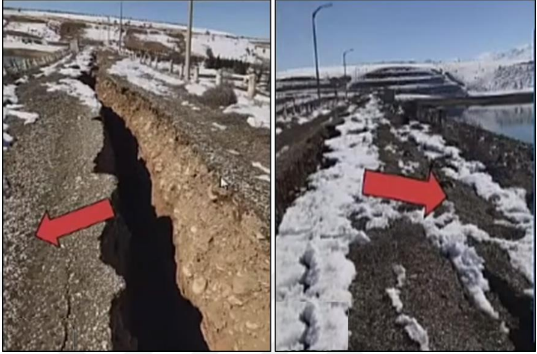
Şekil 6. 59: Krette ve Memba şev başlangıcında kalıcı yanıl hareket.
