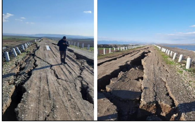
Şekil 6. 49: Baraj kreti Km: 6+200 – 8+120 arası büyük çatlaklar ve memba şev başlangıcında memba yönlü kalıcı hareket ve oturma.
