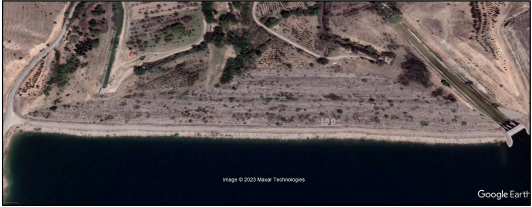
Şekil 6. 53: Sultansuyu Barajı uydu görünümü depremler öncesi 2022.
