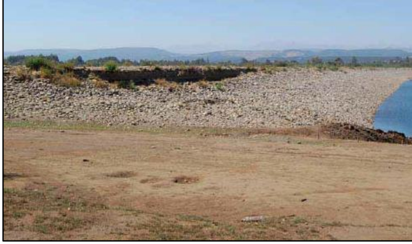
Şekil 4. 12: Mamba şevi kret birleşiminde yanal kayma Şili Depremi Mw 8.8.
