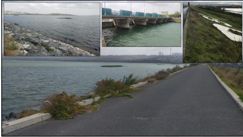
Şekil 2. 9: Homojen toprak dolgu Büyükçekmece Barajı, İstanbul.
