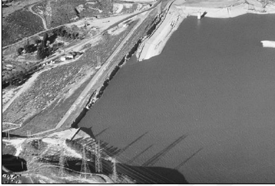
Şekil 4. 8: 1971 San Fernando depremi sonrası San Fernando Barajı memba yüzeyinde sivilaşma ve mukavemet yenilmesi.
