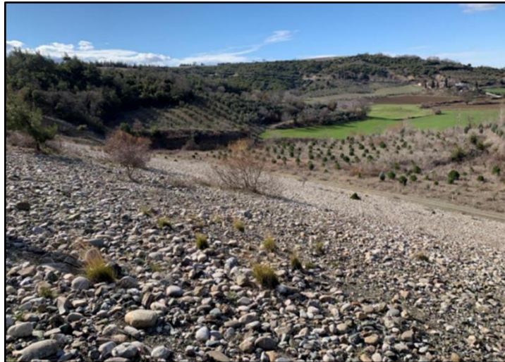
Şekil 6. 20: Kretten mansap şevinin görünümü.
