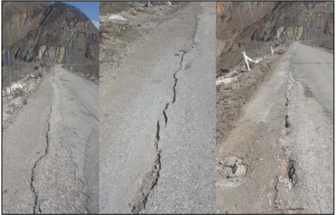
Şekil 6. 130: Çat Barajı, Malatya.
