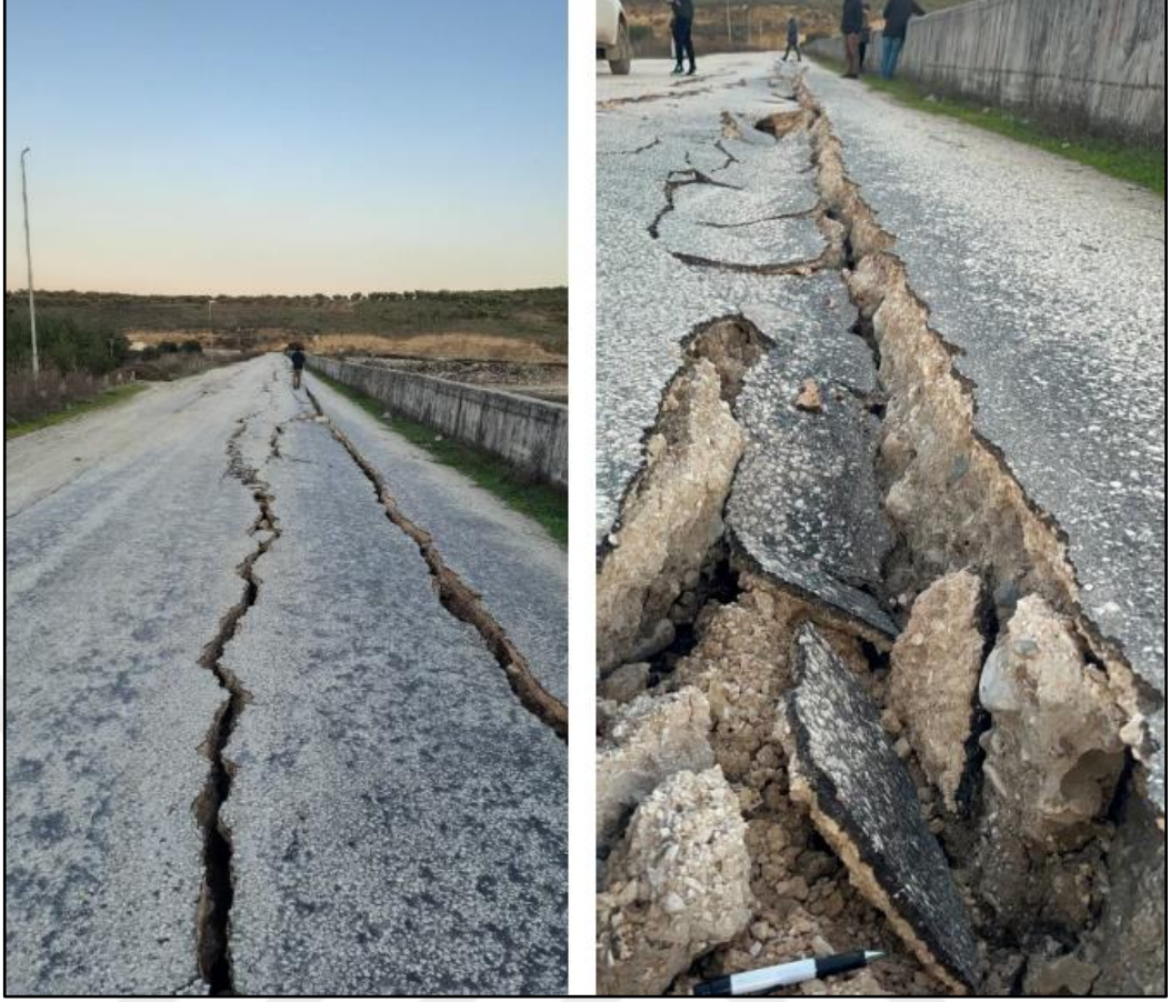
Şekil 6. 89: Krette memba yönlü yanal kalıcı hareket ve boyuna çatlaklar G:20 cm ~ 125 cm.
