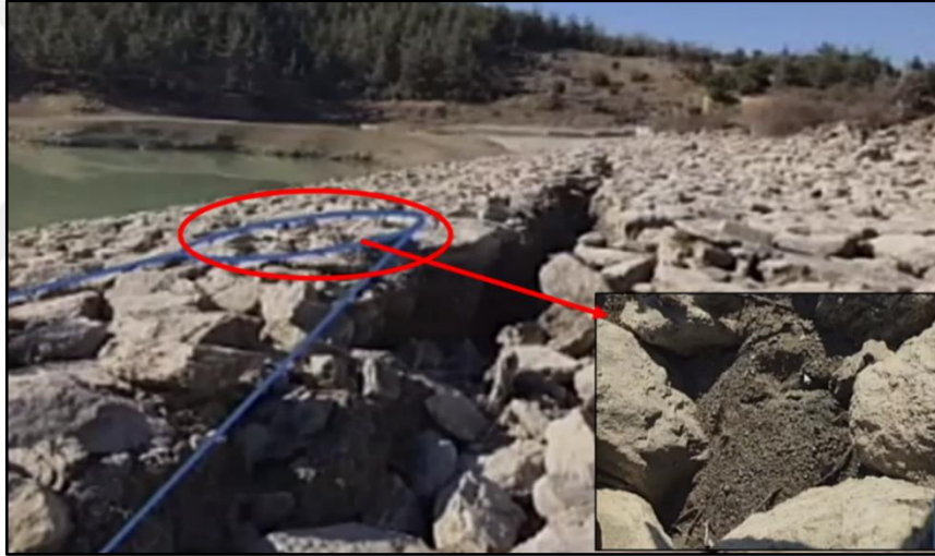
Şekil 6. 16: Memba şevinde kalıcı yanal hareket ve sıvılaşma belirtileri.
