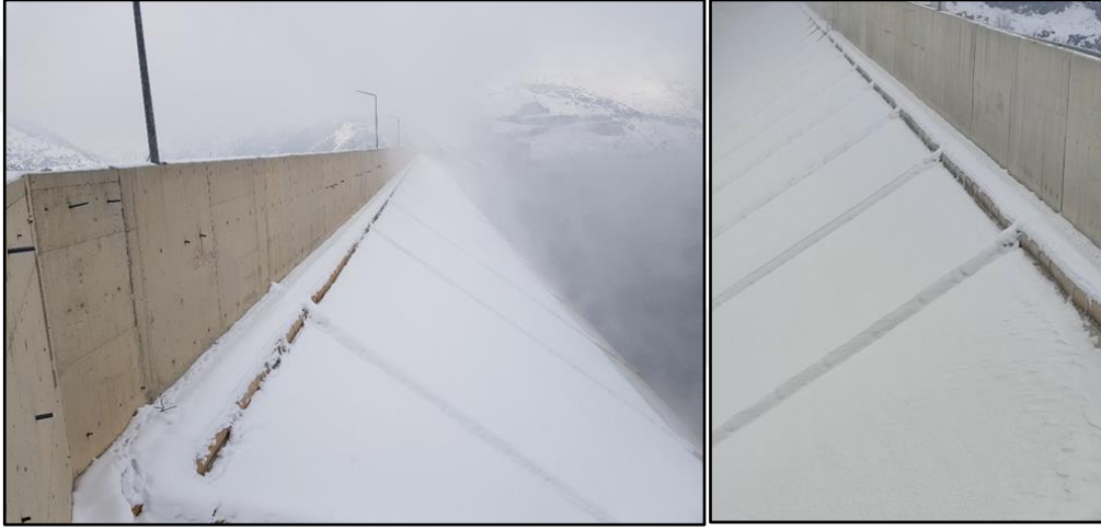
Şekil 6. 135: Kandil Barajı, Kahramanmaraş
