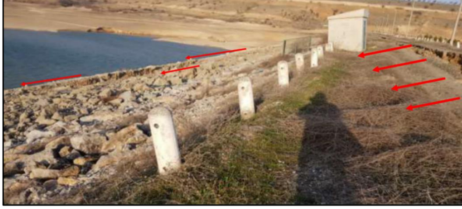
Şekil 6. 61: Krette ve memba şevi üzerinde oluşan memba yönlü yanal hareketler.
