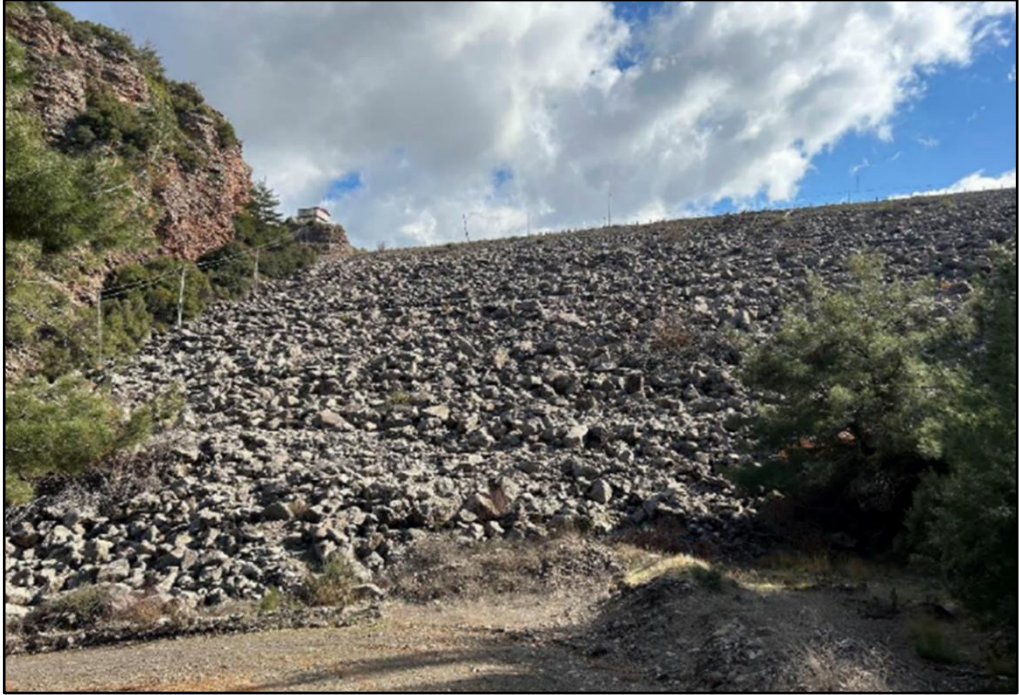
Şekil 6. 78: Kalecik Barajı mansap şevi görünümü.
