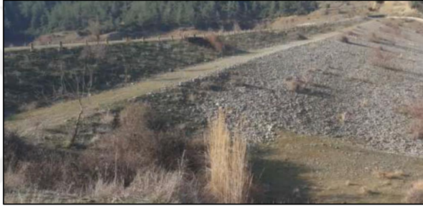
Şekil 6. 19: Sağ sahilden mansap şevi ve ilave yapılan dolgunun görünümü.
