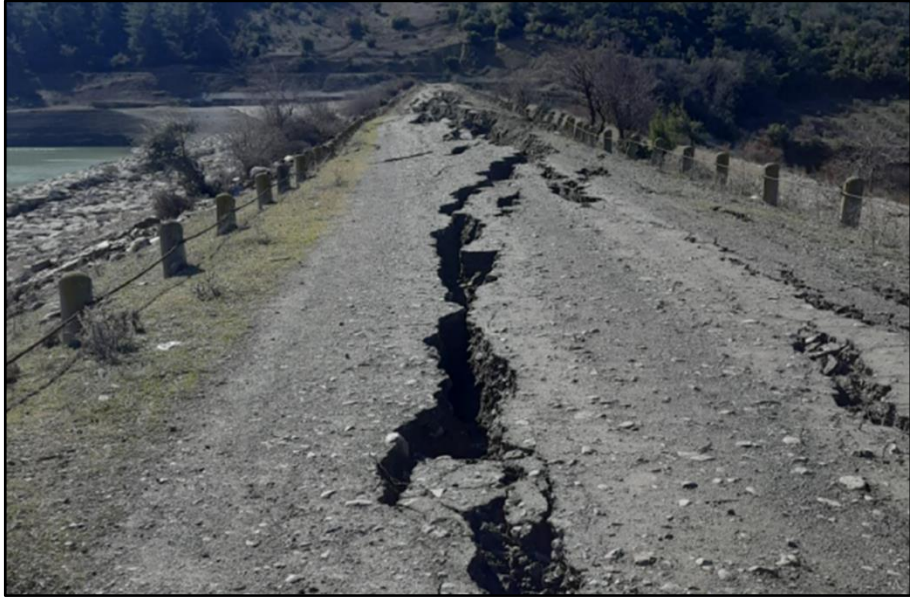
Şekil 6. 14: Krette memba yönlü yanal hareket ve boyuna derin çatlaklar.
