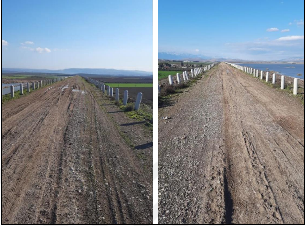
Şekil 6. 44: Baraj kreti Km: 2+000 – 6+200 arası hasarsız bölge.
