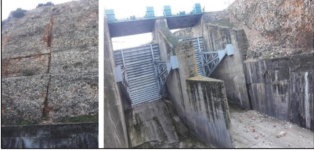
Şekil 6. 109: Dolusavak boşaltım kanalı sol sahil şevi ve radyal kapaklar.
