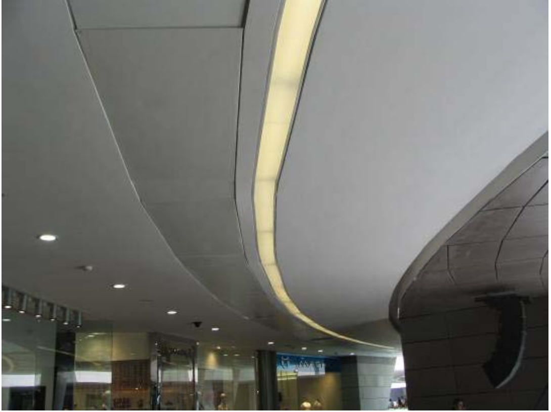
Resim 12.14. Panellerin levent kanyon alışveriş merkezine montajı
