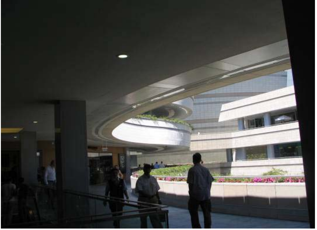
Resim 12.16. Panellerin levent kanyon alışveriş merkezine montajı
