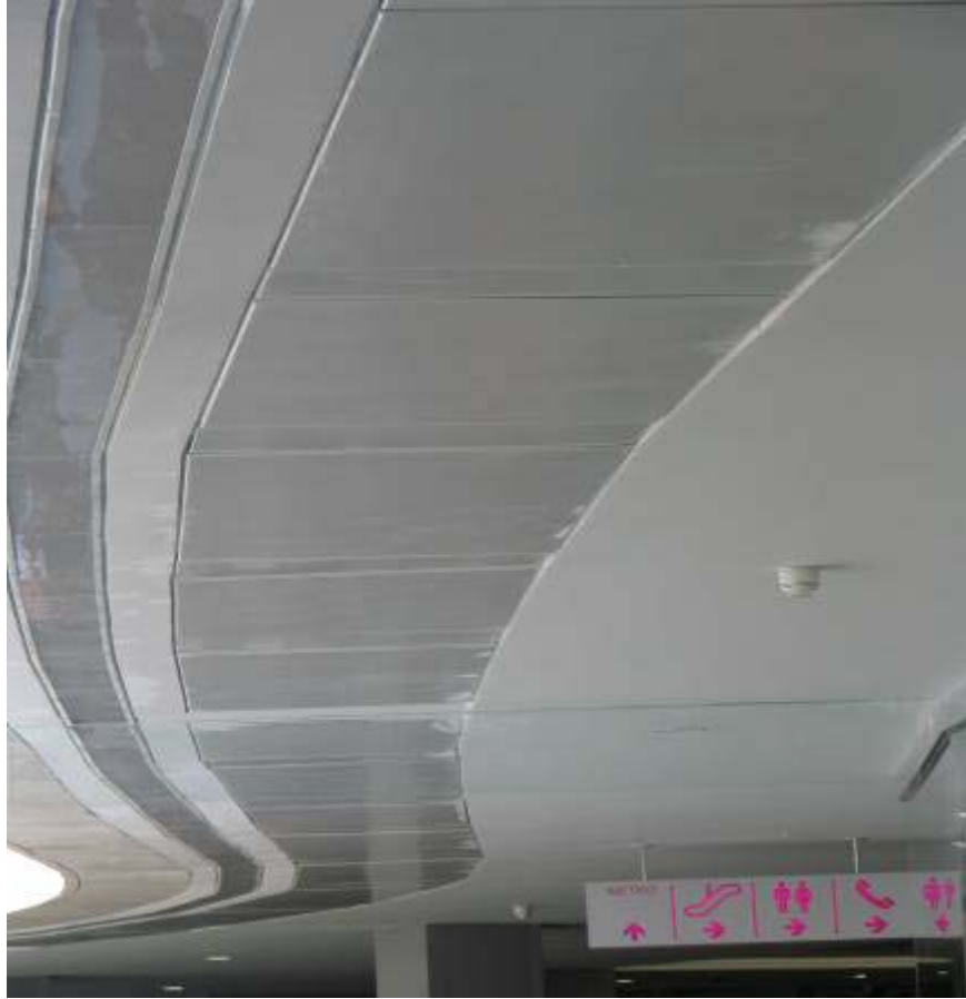
Resim 12.15. Panellerin levent kanyon alışveriş merkezine montajı
