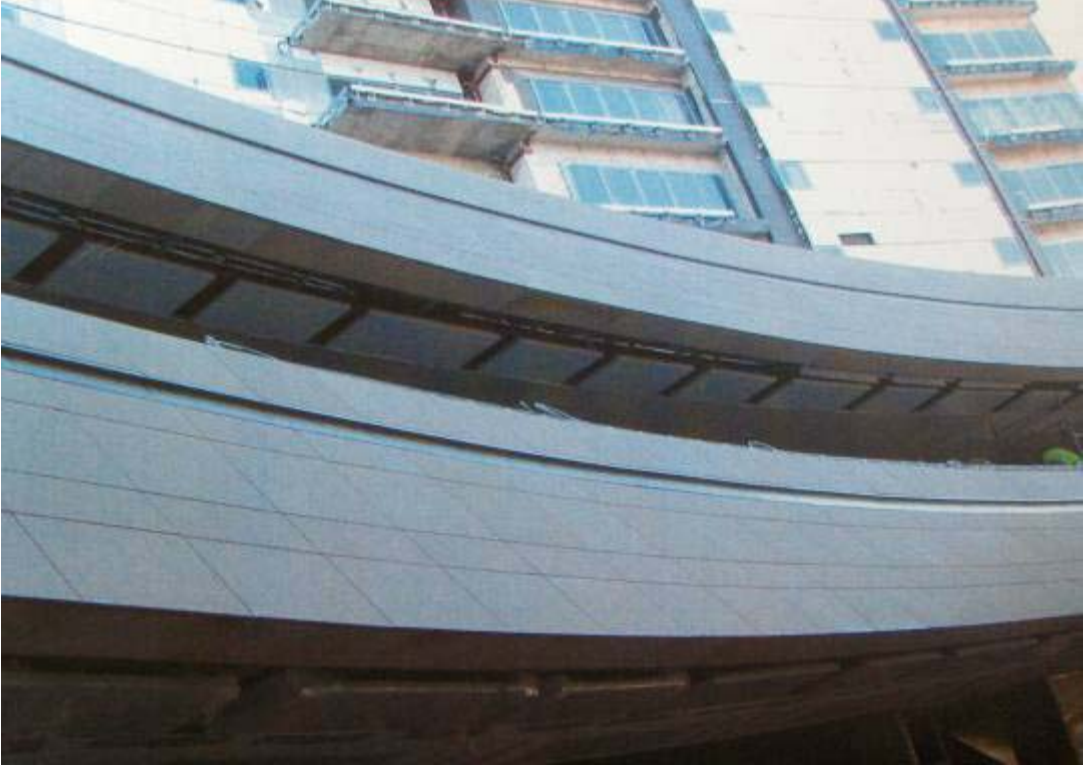
Resim 12.3. Panellerin levent kanyon alışveriş merkezine montajı
