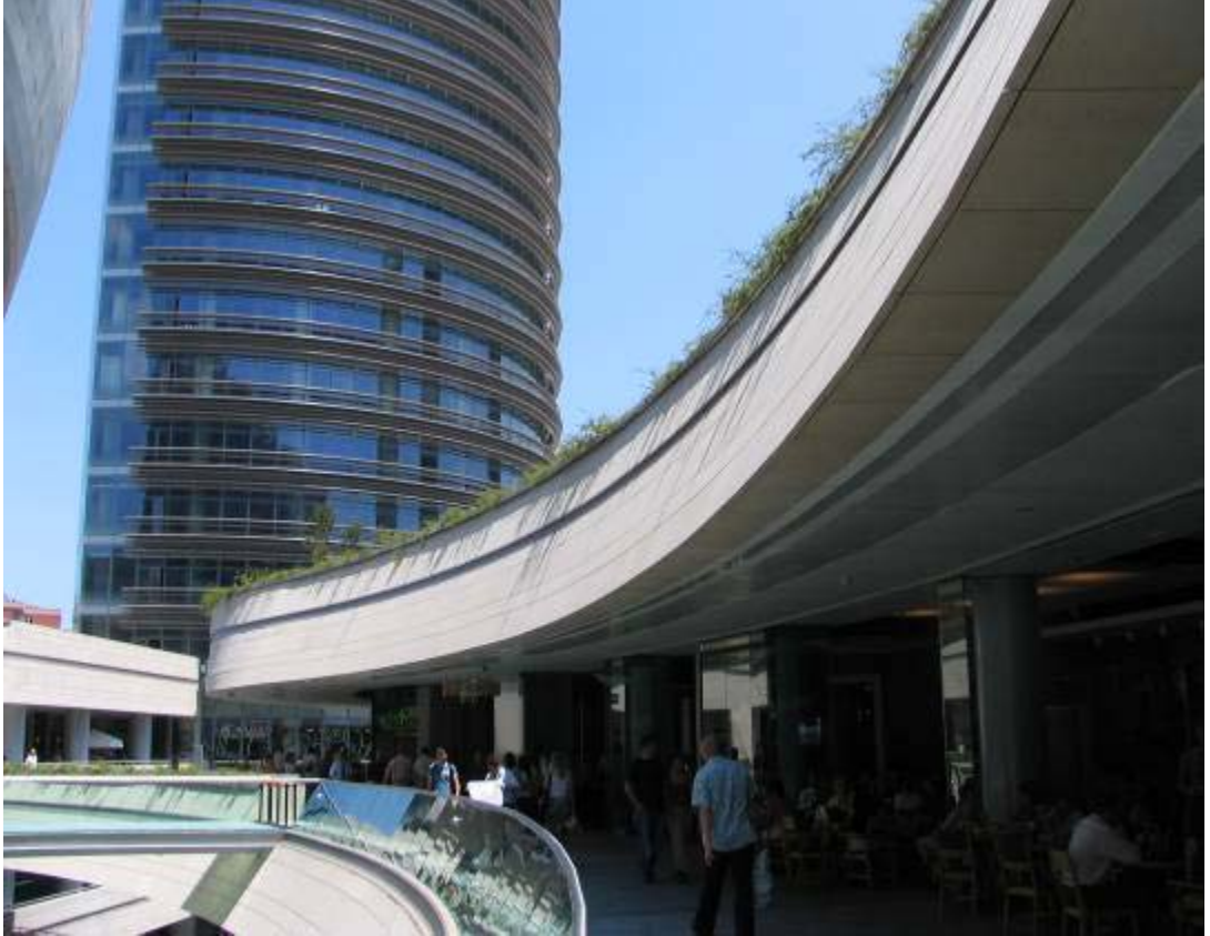
Resim 12.13. Panellerin levent kanyon alışveriş merkezine montajı
