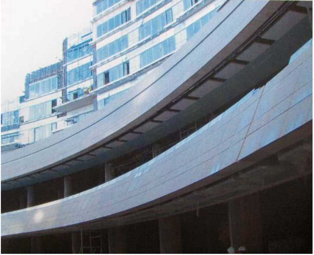
Resim 12.5. Panellerin levent kanyon alışveriş merkezine montajı
