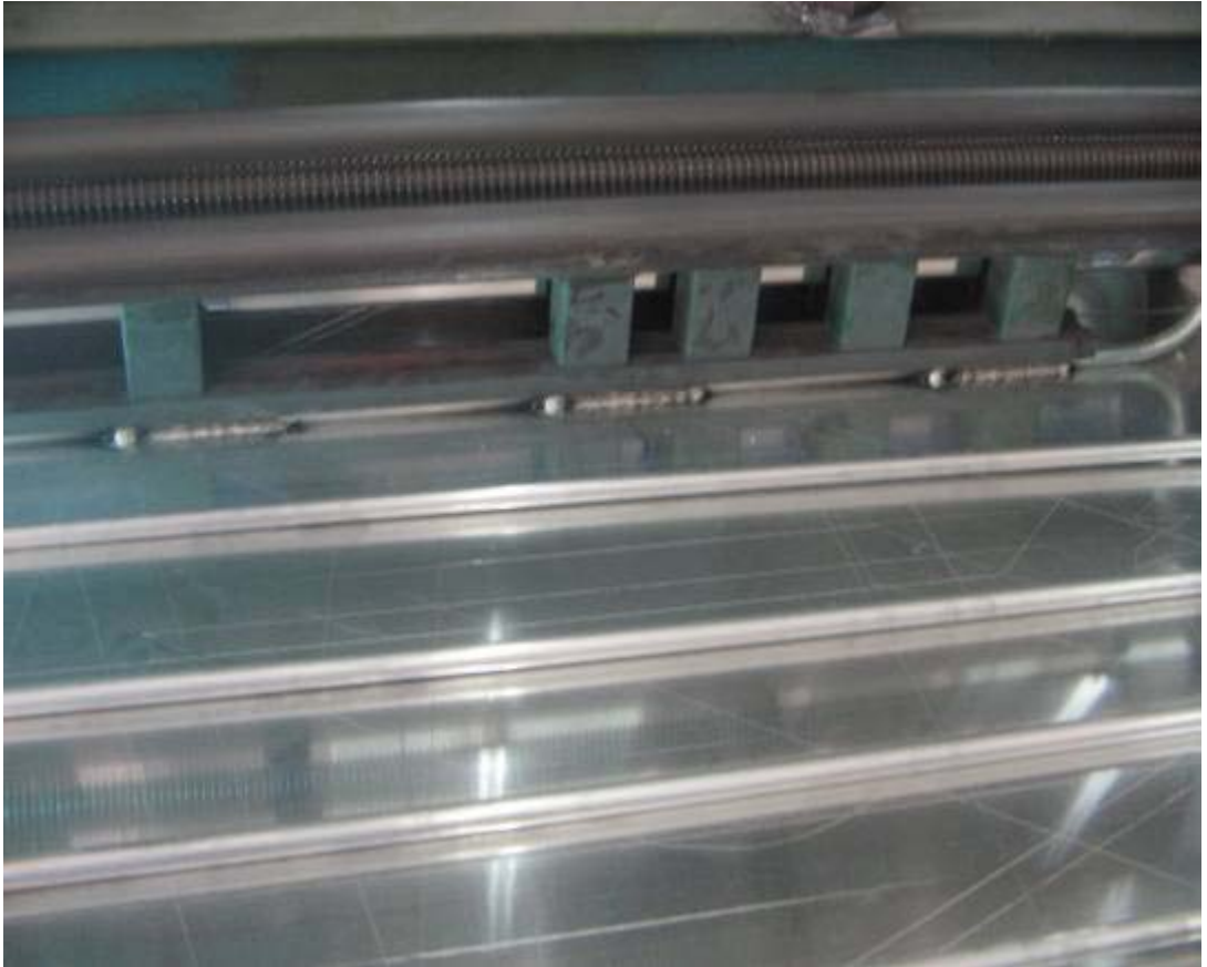
Resim 11.16. Alüminyum borunun tava'ya metod kaynağı ile kaynatılması
