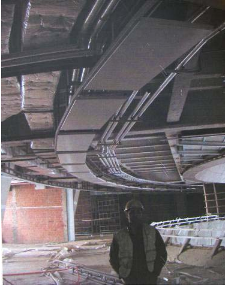
Resim 12.4. Panellerin levent kanyon alışveriş merkezine montajı
