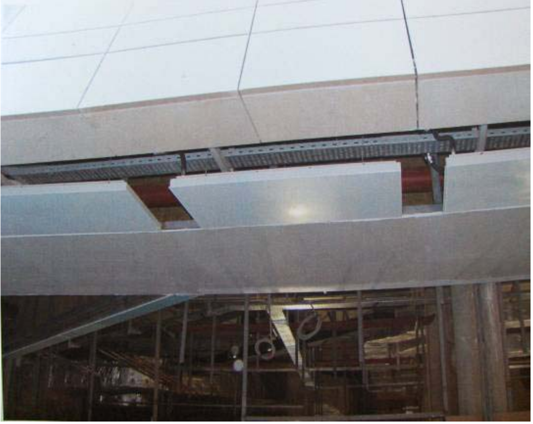
Resim 12.8. Panellerin levant kanyon alışveriş merkezine montajı
