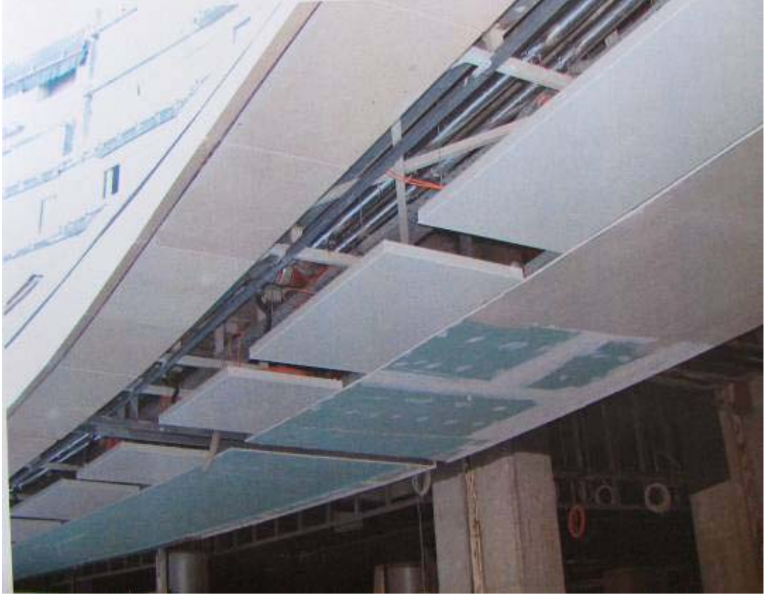
Resim 12.6. Panellerin levent kanyon alışveriş merkezine montajı
