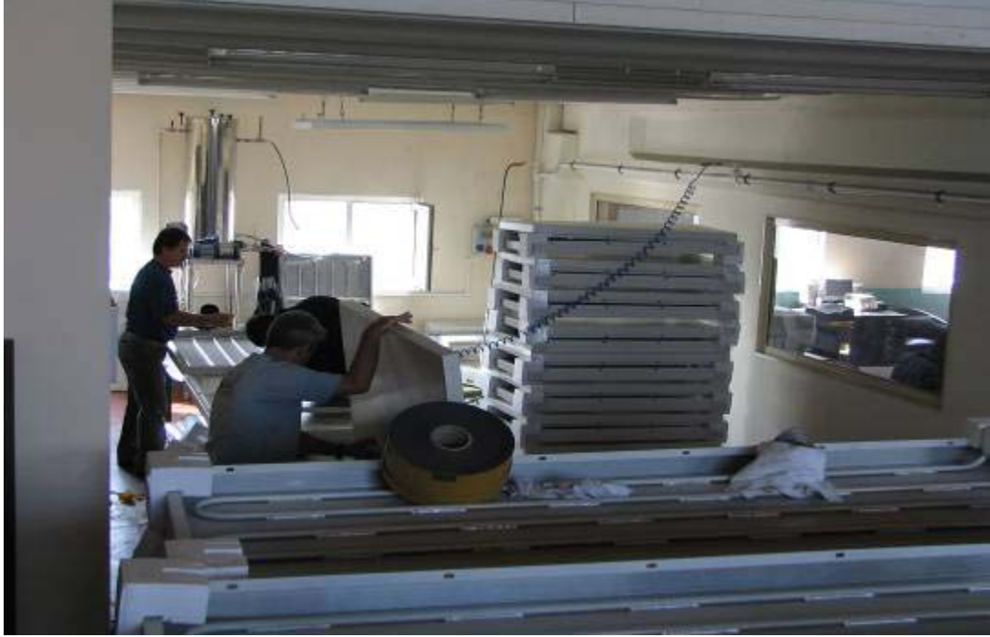
Resim 11.26. Panellerin izolasyon montajı
