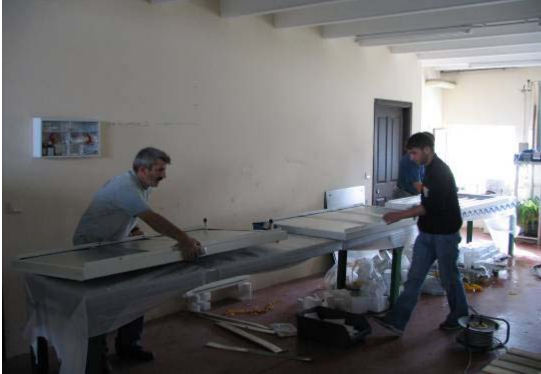
Resim 11.27. Panellerin izolasyon montajı
