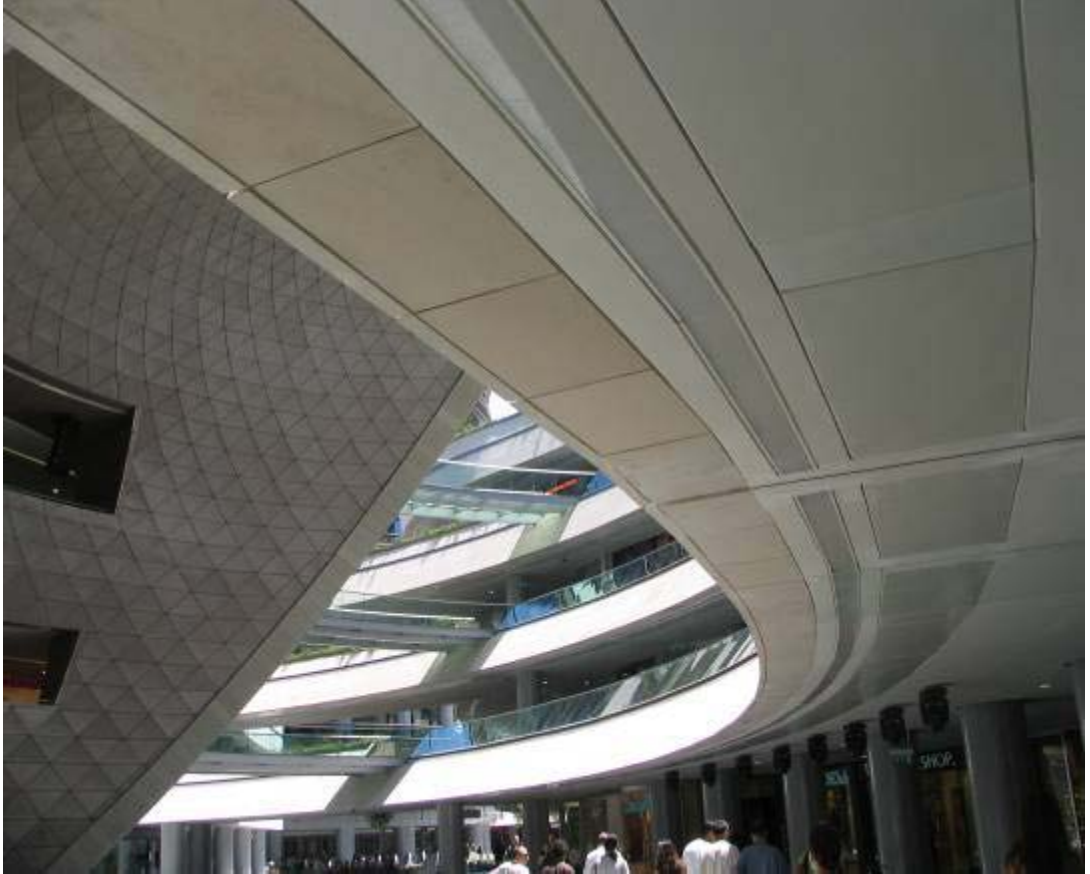
Resim 12.11. Panellerin levent kanyon alışveriş merkezine montajı
