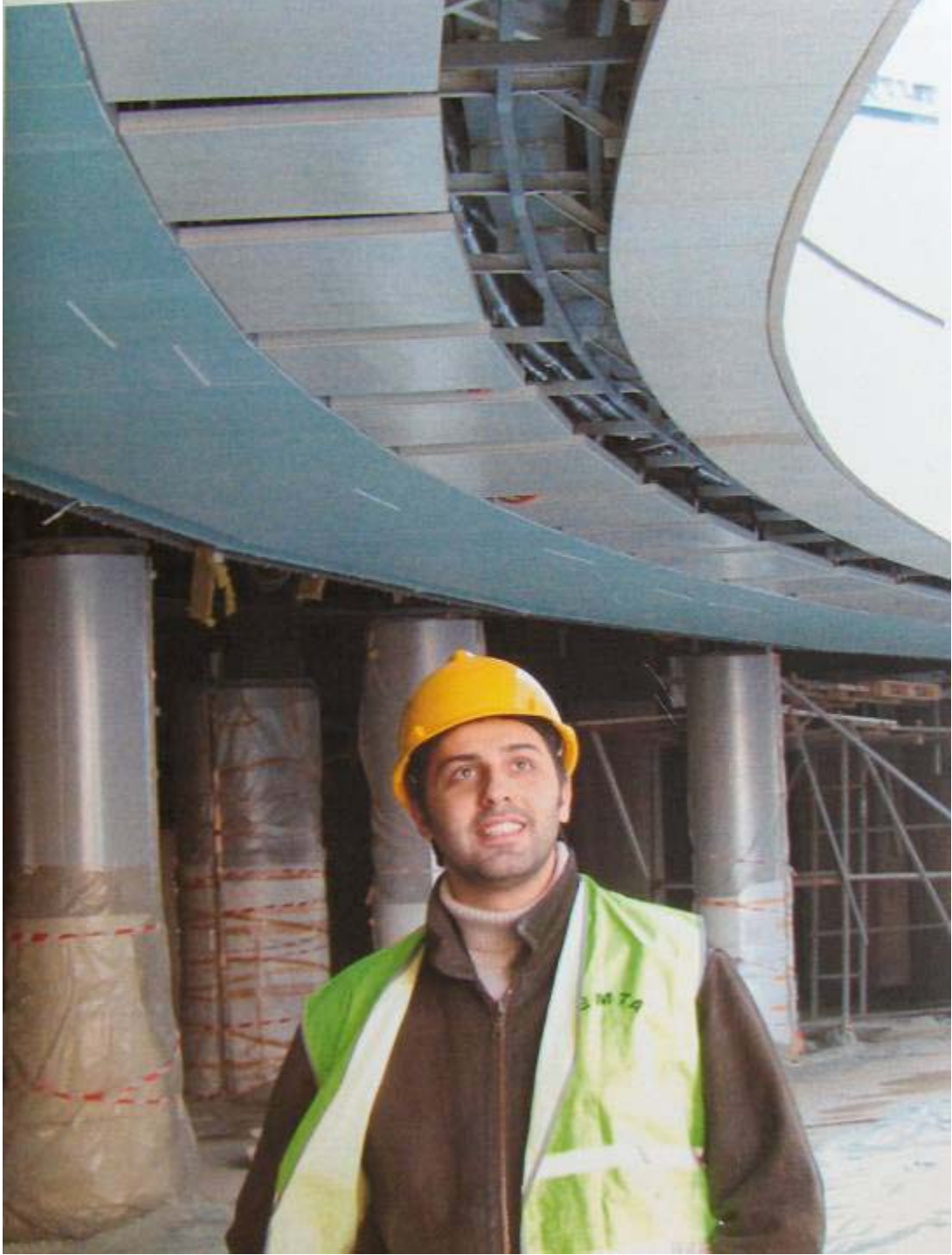
Resim 12.7. Panellerin levent kanyon alışveriş merkezine montajı
