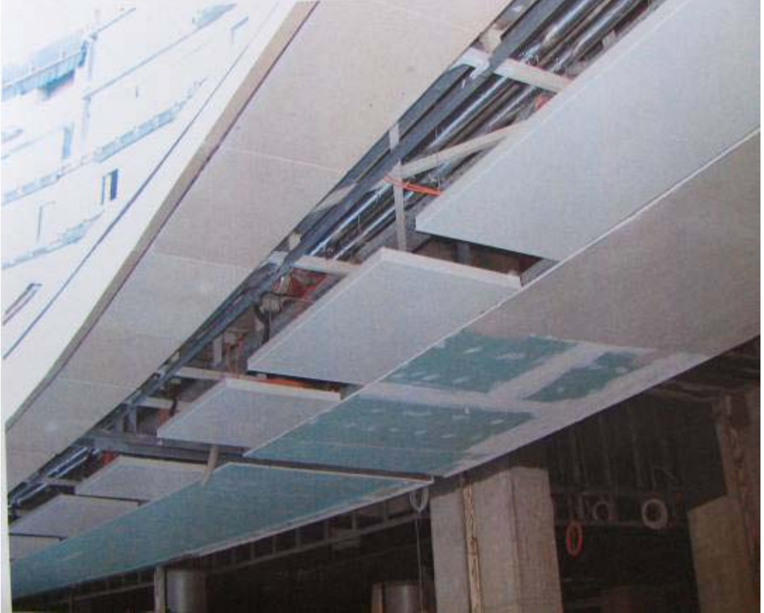
Resim 12.9. Panellerin levant kanyon alışveriş merkezine montajı
