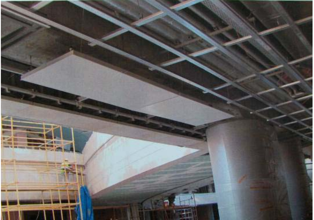
Resim 12.2. Panellerin levent kanyon alışveriş merkezine montajı
