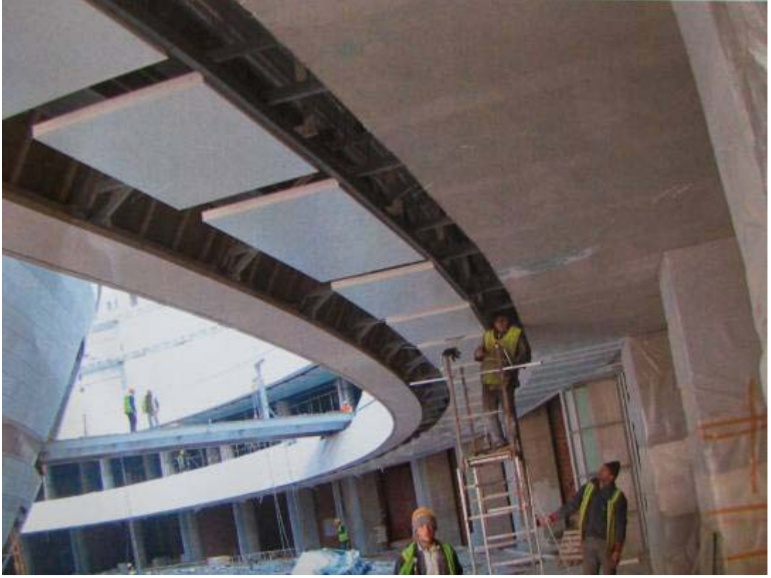
Resim 12.1. Panellerin levent kanyon alışveriş merkezine montajı
