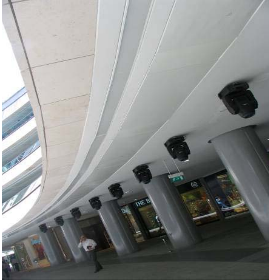
Resim 12.17. Panellerin levent kanyon alışveriş merkezine montajı
