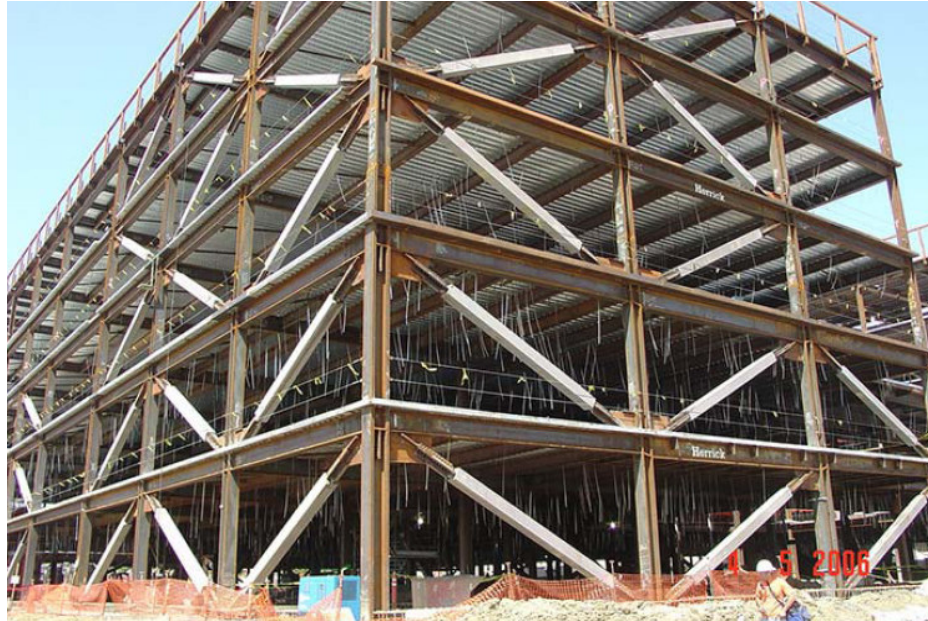
Şekil 5.16. BÖÇÇ Sistemli Bir Çelik Yapı[Engelhardt, 2007]
